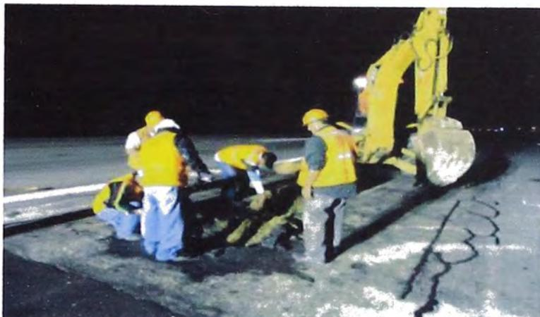
La profundidad de estas calicatas llego hasta la segunda capa de asfalto, con ello confirmando su estructura tipo “sándwich”. En cada una de las calicatas excavadas se midieron los espesores de capas superiores del pavimento, obteniendo los siguientes resultados:
