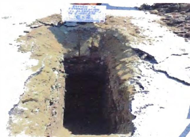
Con la finalidad de obtener muestras de la capa de base situada entre las dos capas de carpeta asfáltica en la pista, para poder verificar el contenido de
