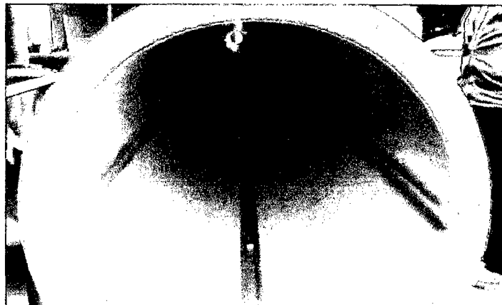
c) Vista del interior de tubería con perfiles instalados.
