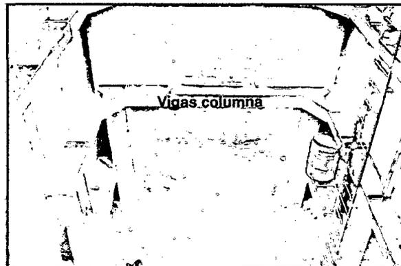
*Fotografía 7.12: Vigas columna montadas a cada lado del anillo de emboque*
