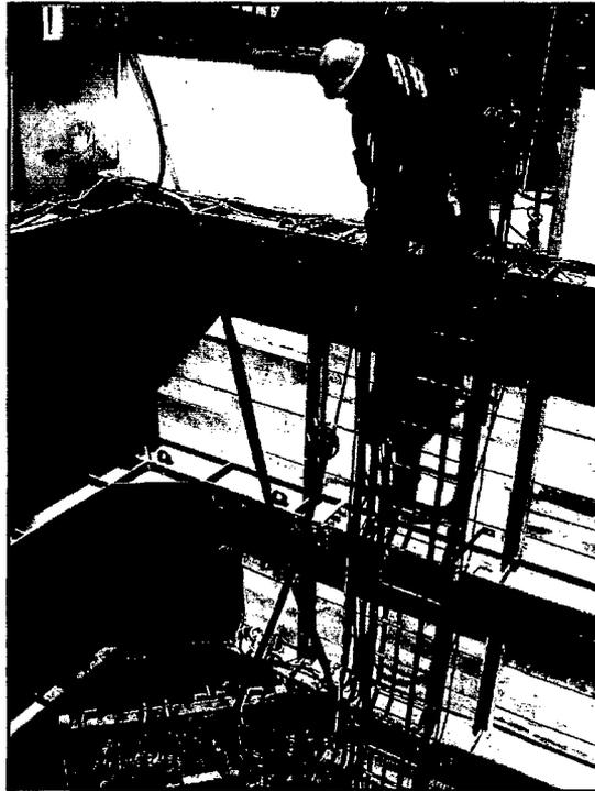
*Fotografía 7.71: Levantamiento de manguera de retorno con cuerda de  $\frac{5}{8}$ " x 10 m*
