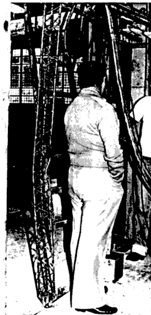
Nótese la "falla local" en la columna con diagonales.
