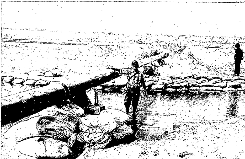
ENCAUCE DE LAS AGUAS QUE CRUZA EL EJE DE LA TUBERÍA
