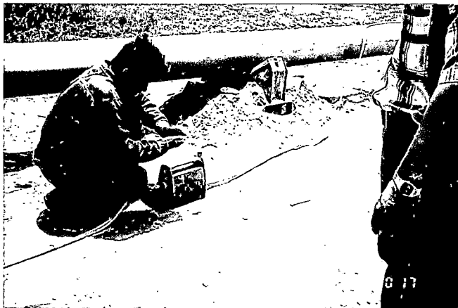
PREPARACION DEL EQUIPO DE RADIACION CON LA PASTILLA DE IRIDIO.
