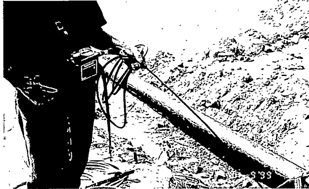
TUBERIA EXISTENTE CORTADA Y RETENIDA DEL CANGAMO.
