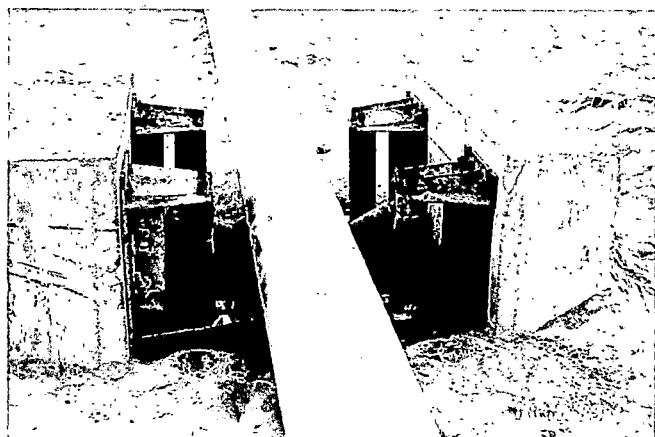
BASE GUÍA EN PLAYA CON POLINES Y LA TUBERÍA
