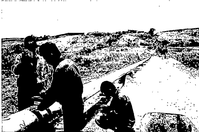
PREPARACION DE LAS PLACAS RADIOGRAFICAS
