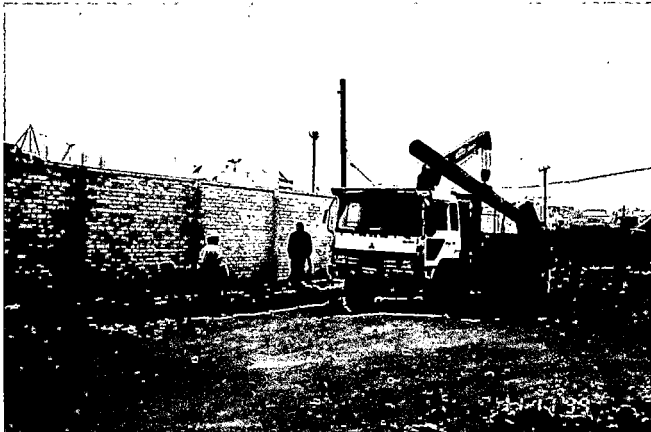
TRANSPORTE DE LOS TRAMOS RECUPERADOS HACIA EL TERMINAL
