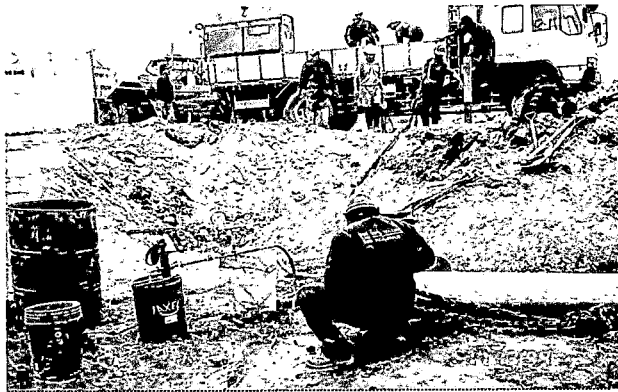
UNIÓN DE LA TUBERÍA EXISTENTE CON LA NUEVA
