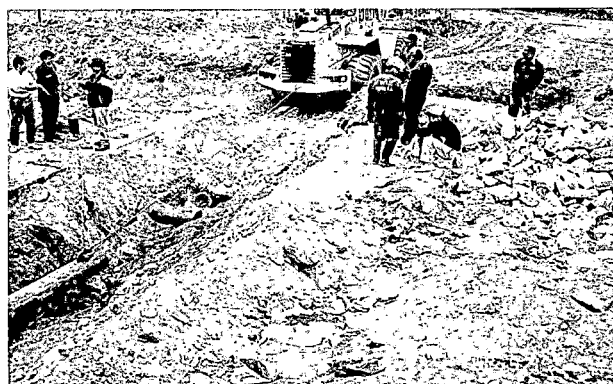
REFLOTAMIENTO DE LA TUBERÍA EXISTENTE EN SUPE
