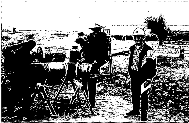
SOLDADURA DE NIPLES Y CODOS PARA HABILITAR EL CUELLO DE GANSO
