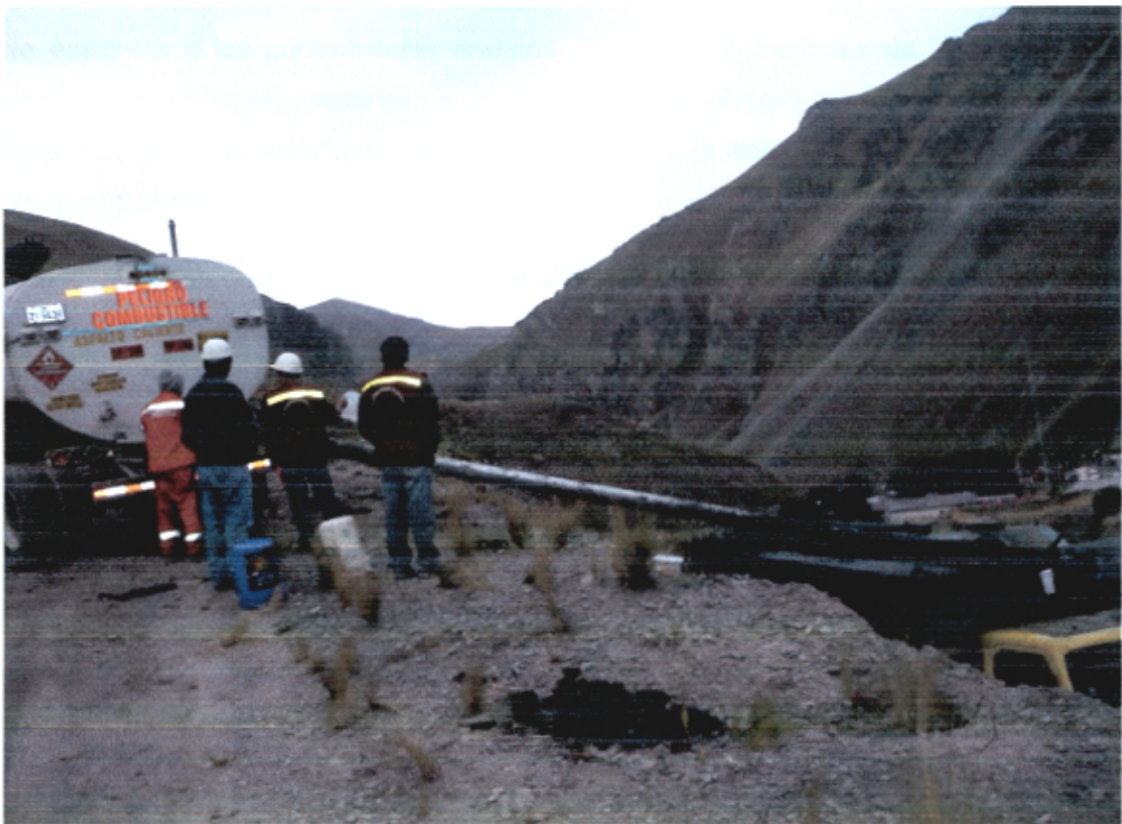
FOTO 1.1. CAMIÓN DE TRANSPORTE Y DE DISTRIBUCIÓN DE EMULSIÓN EN OBRA
