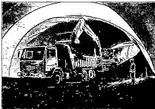
Figura N° 26 Trabajos de movimiento de tierra bajo cobertores insuflados.
