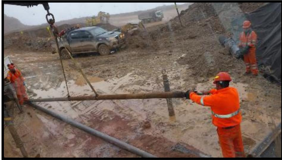
Figura 5.6 rotación de la barra de perforación
