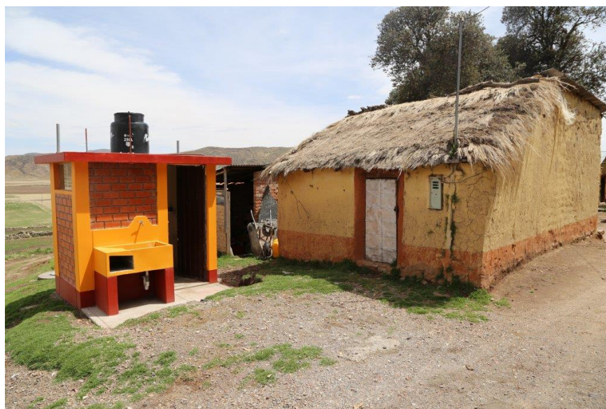
Foto N° 02: Unidad Básica de Saneamiento (Baño) en construido por el PRONASAR
