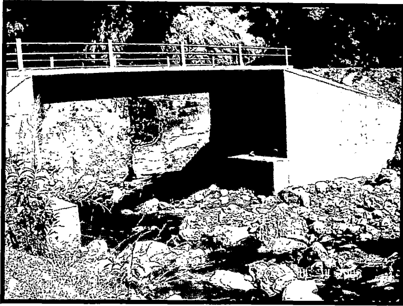
Fotos N° 94: Progresiva Km. 236+200.00
