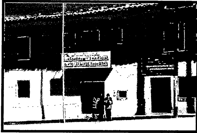
Foto N° 47: Local de la Unidad de Gestión Educativa – Local Piscobamba
