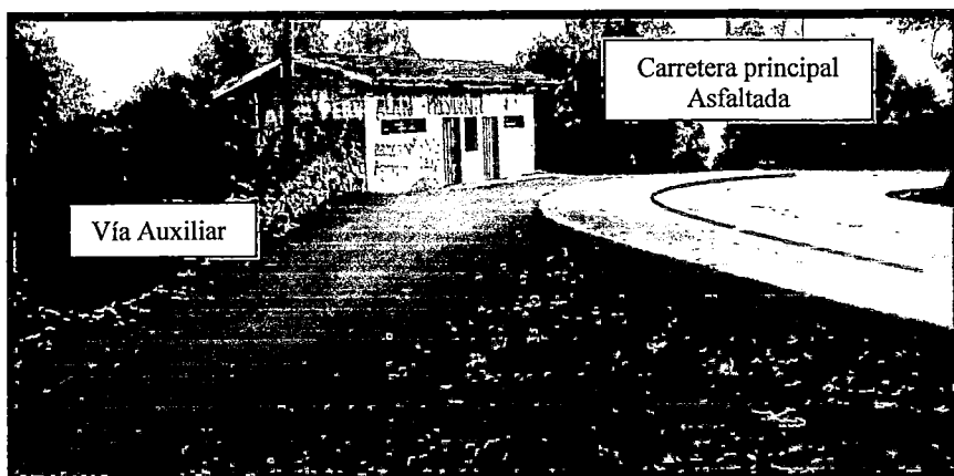
Fotos N° 93: Km. 233+770.00 - vía auxiliar a la carretera principal, que descarga en una curva muy cerrada.
