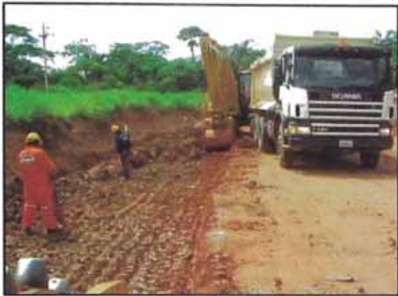
Foto 30. Mejoramiento en los hombros (zona de ensanche de la plataforma existente), eliminación del material inadecuado.
