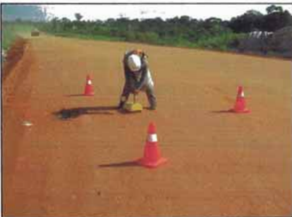
Foto 16. Control de densidades a nivel de sub base suelo cal.
