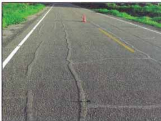
Foto 38. Tratamiento de sellado de fisuras a nivel de TSB con elastómero (betuflex), en el sector km 660.
