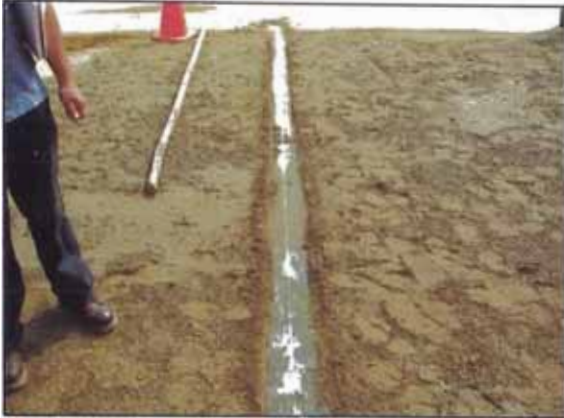
Foto 41. Delineamiento con tiza para la ejecución de la prefisura en la capa de suelo cemento.
