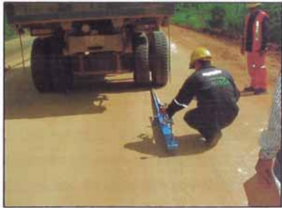
Foto 17. Control deflectométrico a nivel de sub base suelo cal terminado.
