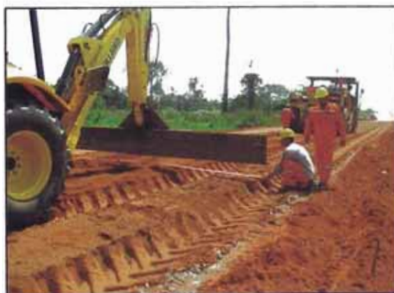
Foto 45. Colocación del geosintético mediante equipo retroexcavadora en el suelo cemento fresco.
