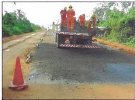
Foto 27. Arenado con espesor de 2.0 cm, aproximadamente luego de la imprimación con emulsión asfáltica de rotura lenta.
