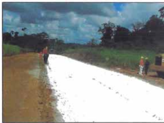
Foto 31. Aplicación del mejoramiento suelo cal en los ensanches de la plataforma, con la adición de material de cantera.
