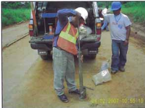
Foto 04. Moldeo de los especímenes de suelo-cemento en campo sobre una superficie compacta.
