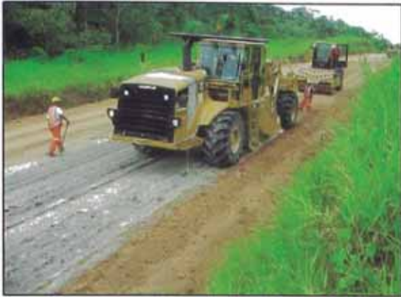
Foto 22. Mezclado del suelo cemento con el equipo escarificador - reciclador.
