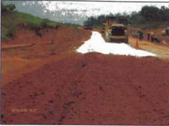
Foto 12. Mezclado homogéneo del suelo con la cal mediante la recicladora.
