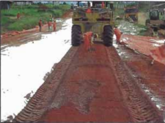
Foto 14. Verificación de la profundidad de mezclado que alcanza el rotor de la recicladora.
