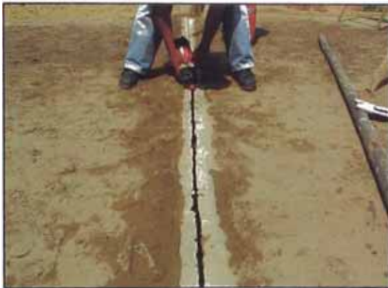
Foto 43. Aplicación manual de la emulsión de rotura lenta en la junta previa limpieza de la junta.
