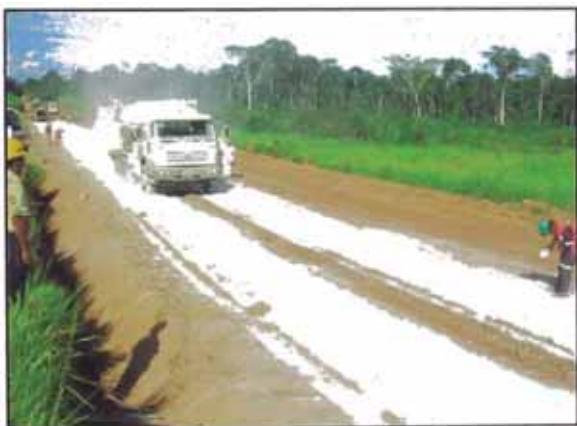
Foto 10. Esparcido de la cal por el camión dispensador de cal.
