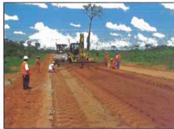
Foto 46. El geosintético se coloca en los 4.5 m (ancho del carril) a una profundidad de 0.07 m de la por superficie.
