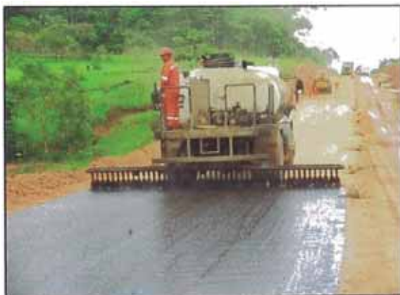
Foto 26. Imprimación del tramo de base suelo cemento después de su aprobación de laboratorio y topografía.
