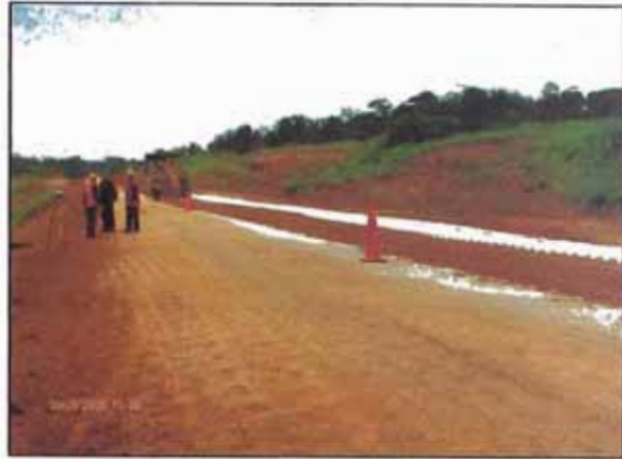
Foto 13. Trabajos rutinarios de sub base suelo cal, un tramo de 300 m en el carril derecho.
