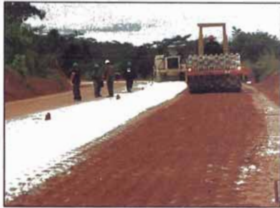
Foto 15. Compactación con rodillo pata de cabra en la sub base suelo-cal.
