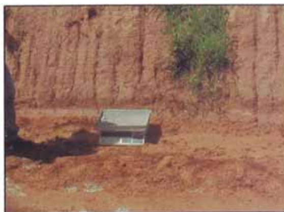
Foto 21. Control de la dosificación de cemento en campo.
