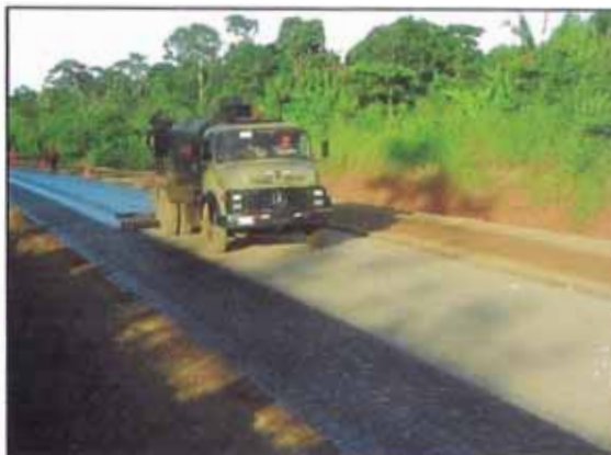
Foto 48. Imprimación asfáltica con emulsión de rotura lenta, realiza la función de curado evitando la evaporación del agua en la base estabilizada.
