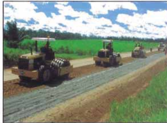
Foto 25. Trabajos cotidiano, tren de compactación en la base suelo cemento.
