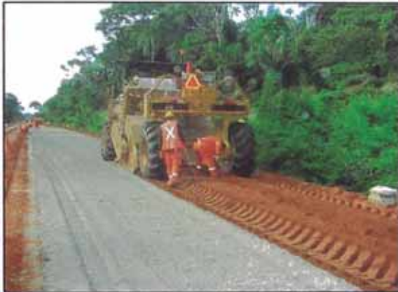
Foto 24. Verificación de la profundidad y homogenización de estabilización suelo cemento.
