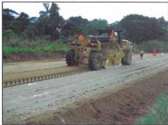
Foto 23. Mezclado por franjas, con la estabilizadora con rotores internos en un sector de 100 m.
