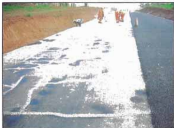
Foto 37. Bacheo y tratamiento de fisuras a nivel de base imprimada en la progresiva km 681+500.
