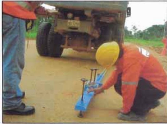
Foto 29. Control de deflexiones a nivel de base suelo cemento culminado.
