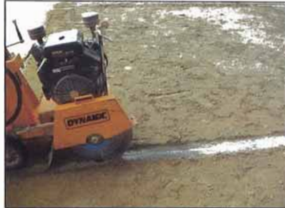
Foto 42. Máquina de cortadora de pavimento realizando la junta de contracción (prefisura).
