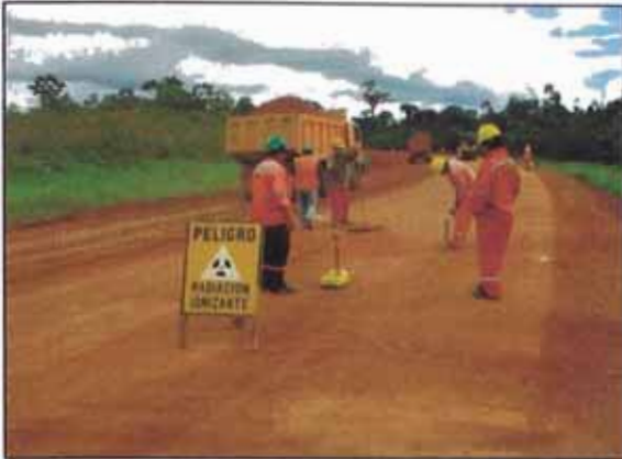
Foto 28. Control de densidades con el densímetro nuclear a nivel de base suelo cemento.
