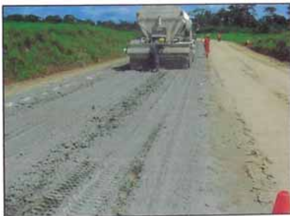
Foto 20. Esparcido del cemento con el camión dispensador.
