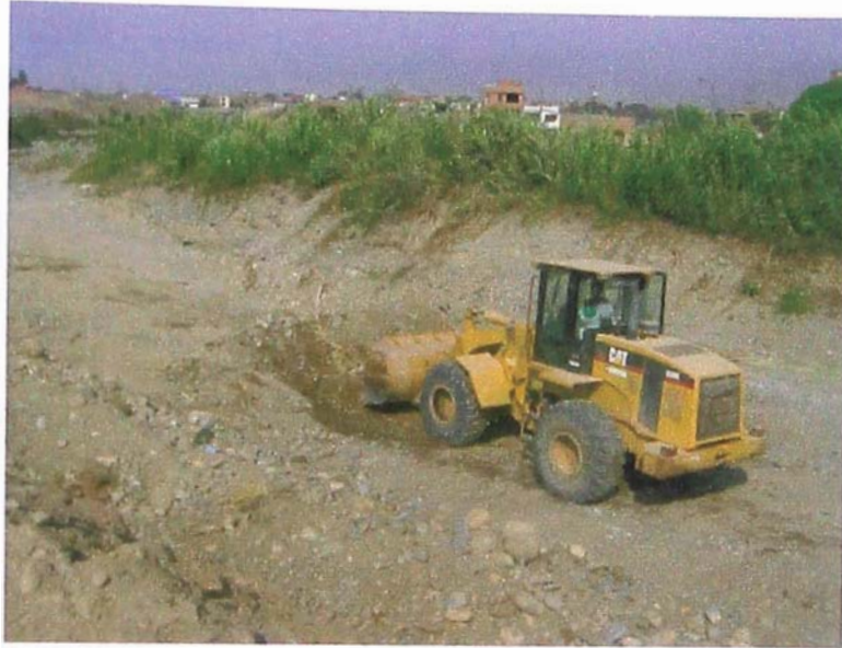
ACUMULACION DE AGREGADO DE CANTO RODADO EN LA RIBERA DEL RIO CHILLON
