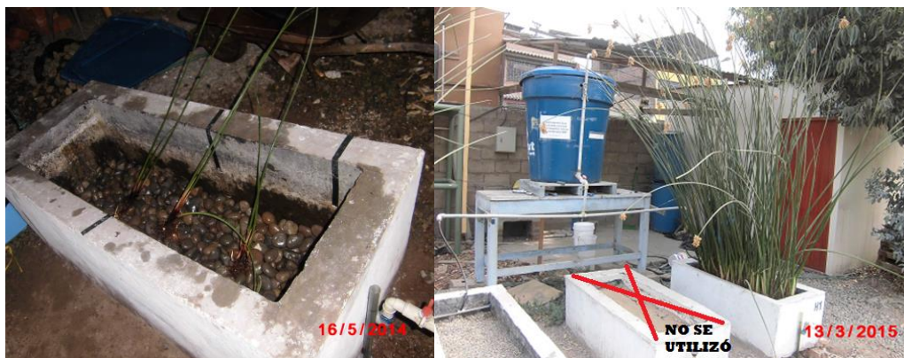
Figura 41 Instalación del sistema experimental en la segunda etapa
