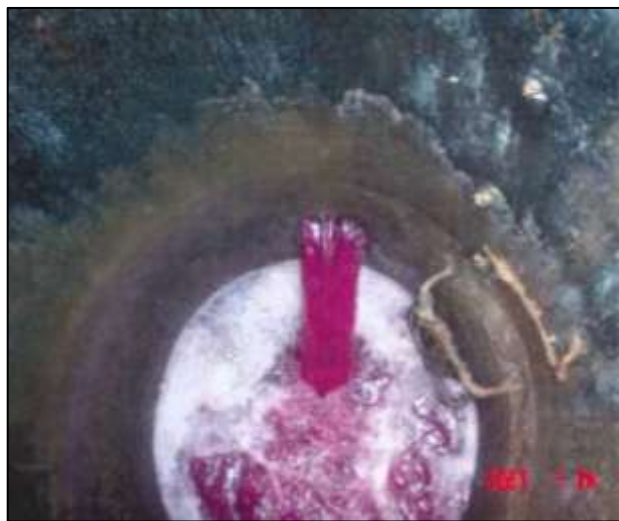
Figura 3.2. Colector Ventanilla (Fuente: ANEPSSA)
