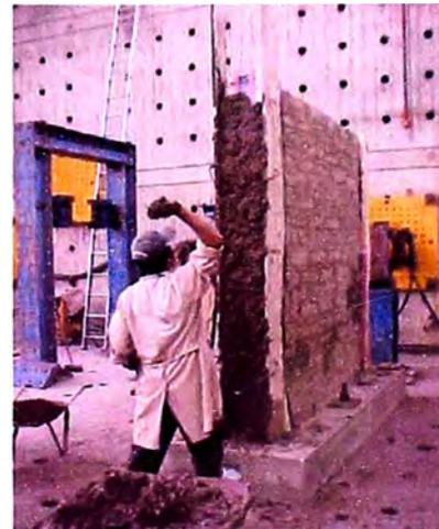
**Figura 105:** Aplicación de mortero
