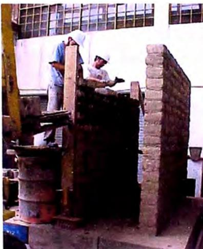
**Figura 74:** Segunda etapa de construcción ( $h > 1,5m$ )
