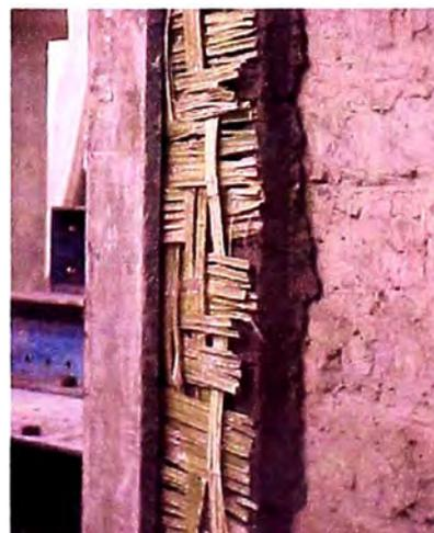
**Figura 99:** Detalle de refuerzo con estera
