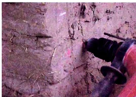
**Figura 91:** Perforación del muro para los amarres
