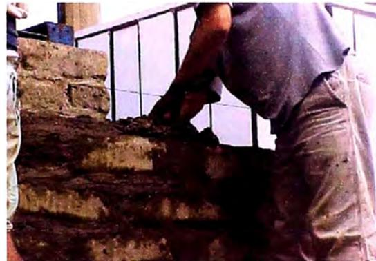
**Figura 73:** Colocación de mortero
