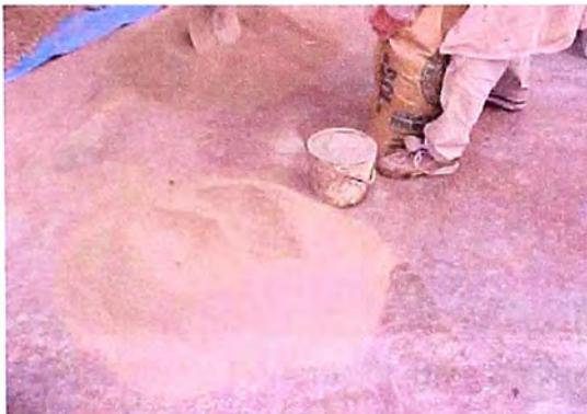
**Figura 84:** Mezcla de suelo y cemento
