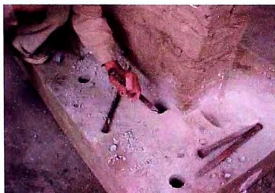
**Figura 90:** Perforación para anclaje de las maderas
