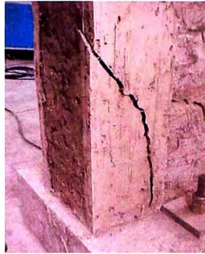
**Figura 113:** Detalle del mortero del muro reforzado con costalillo
