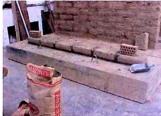
**Figura 71:** Primera hilada del muro
