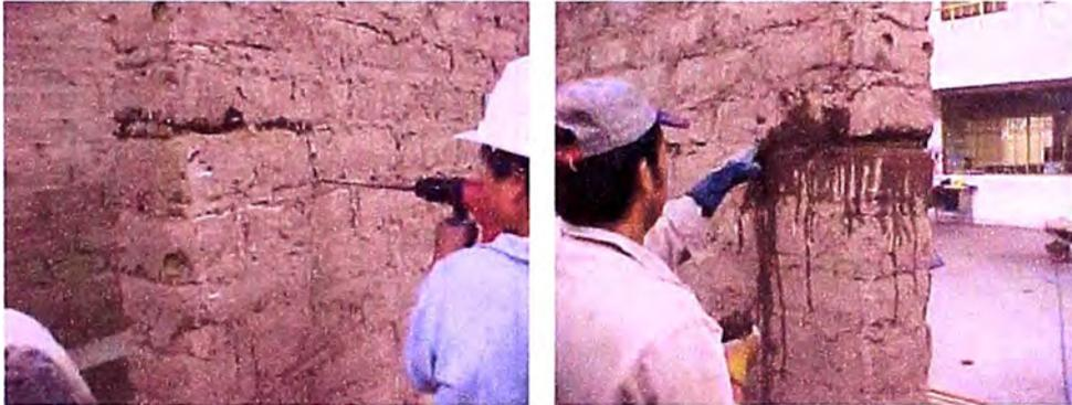
Nota: La reparacion de fisuras debe hacerse por etapas (grietas de menos de 50 cm de longitud) para no comprometer la integridad del muro.
