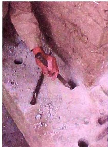
Las maderas se colocan en los agujeros y se aseguran, amarrándolas una con otra con alambre N° 16, el cual se pasa a través de perforaciones hechas en el muro con una broca de 1/4" o con un tornillo.
