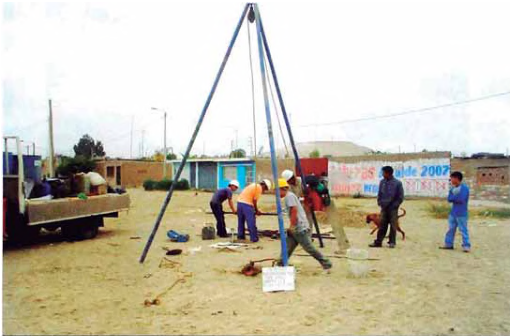
Fotografía No. 9 Ubicación del Sondaje S-6, entre la Calle 2 y el Jr. Antisuyo – Túpac Amaru.
