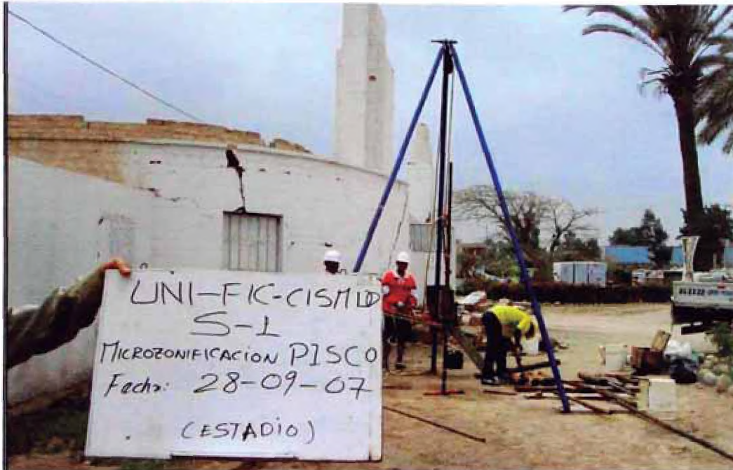
Fotografía No. 1. Ubicación del Sondaje S-1, al lado derecho de la puerta del Estadio "Teobaldo Pinillos Olaechea" (Calle Arequipa).
