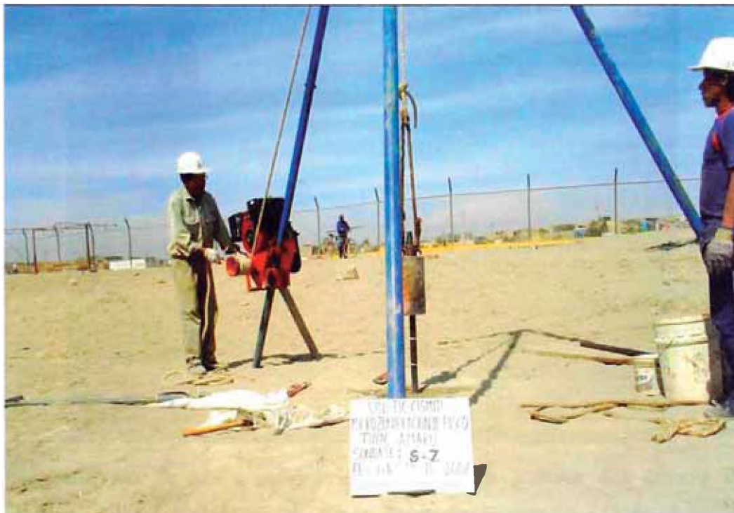
Fotografía No. 10. Ubicación del Sondaje S-7, en el Estadio de Túpac Amaru.
