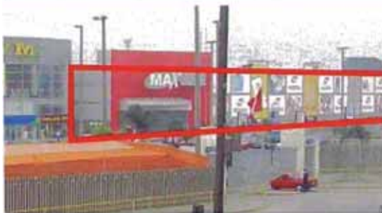
Fotografía desde el exterior en el puente peatonal
