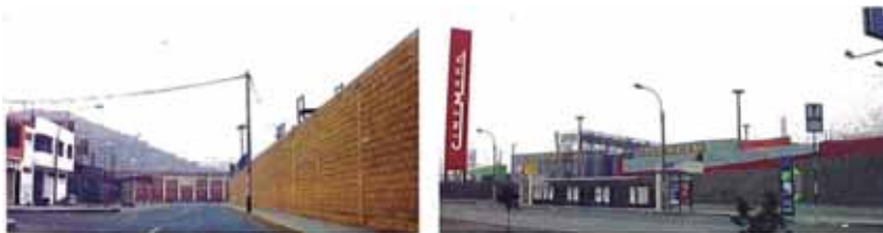
Vista desde la calle "A" y Av. El Pacifico
