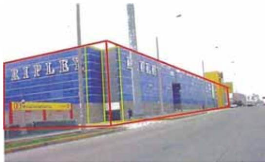
Fotografía en la esquina del volumen.
