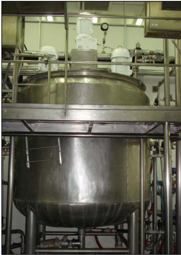
Figura 13: Reactor de 2 Ton
