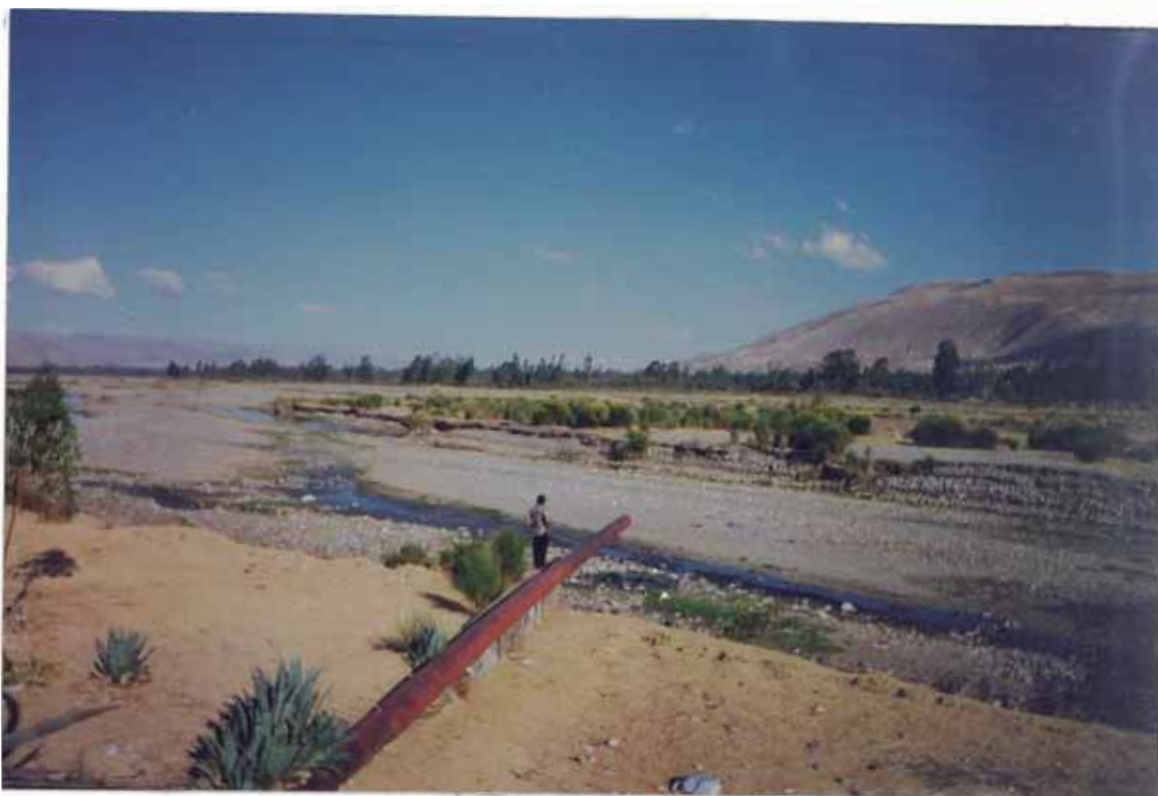
Emisor No2 evacuando su descarga en el río Mantaro, \phi 14", material F•F•
