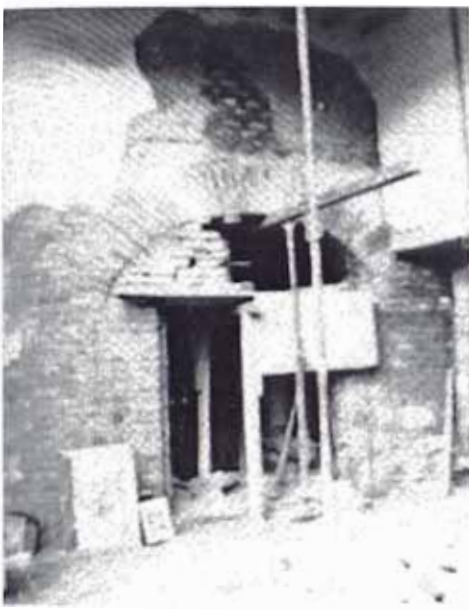
JIMENEZ: Restauración de vano original
