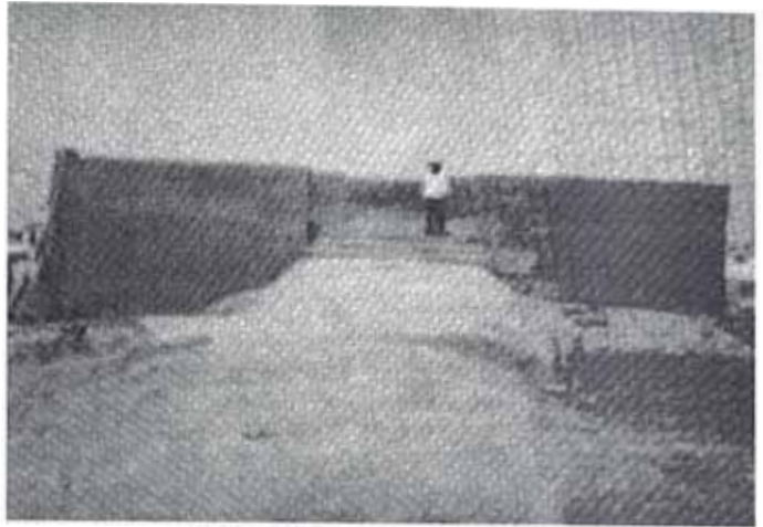
STA. CATALINA: Restauración escalinata.
