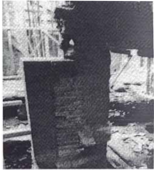
JIMENEZ: Restauración de elementos estructurales original
