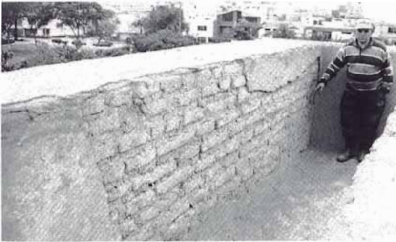
STA. CATALINA: Unidad de adobe de reconstrucción post restauración.
