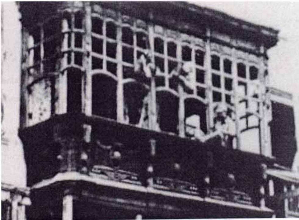
OSAMBELA: Restauración de estructura de un balcón. Fuente: Fototeca Personal Arq. Víctor Pimentel, 2000.
