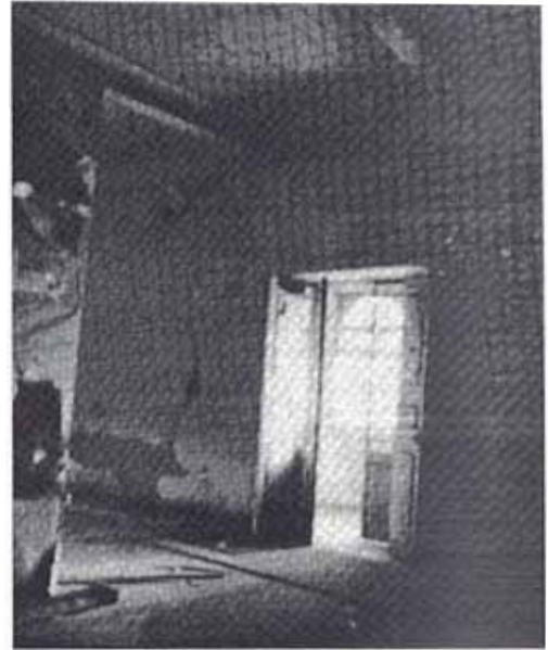
JIMENEZ: Vano pre - restauración Fuente: Fototeca Personal Arq. José Correa, 2000.
