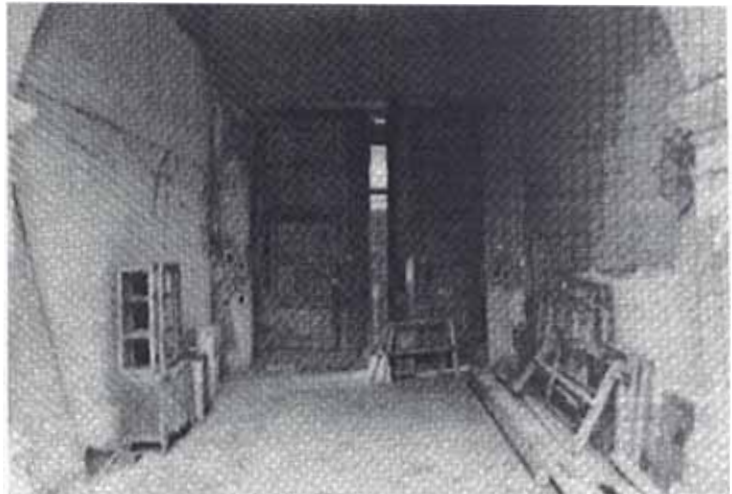
JIMENEZ: Zaguán pre - restauración
