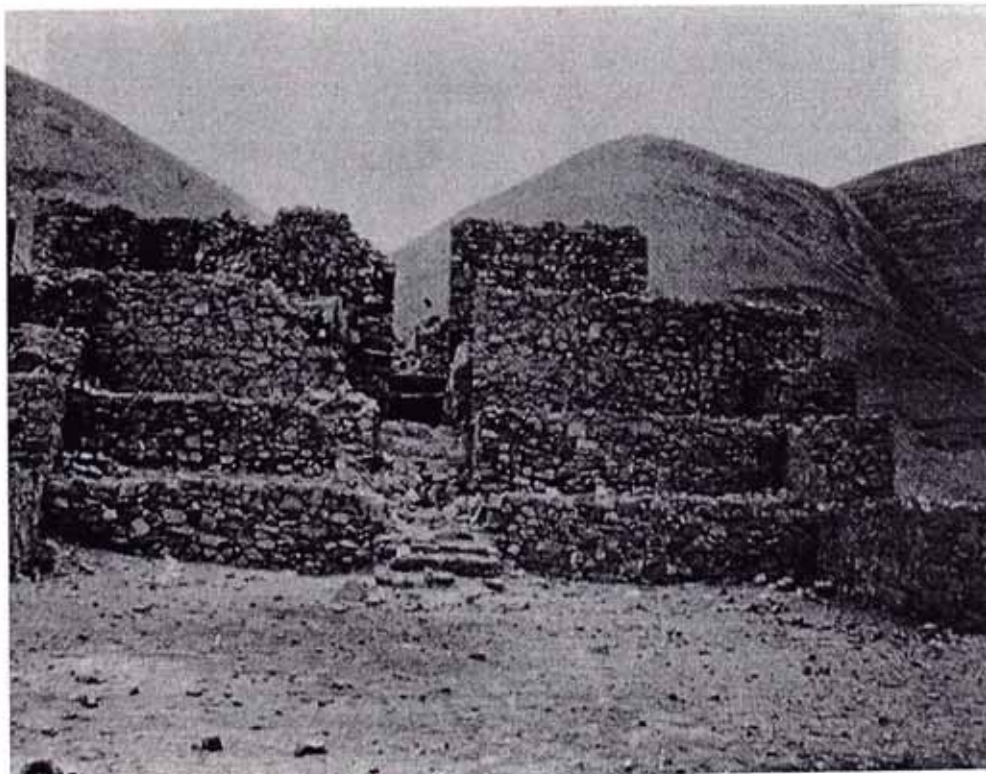
EL PARAÍSO: Esquina nor oeste post-restauración
