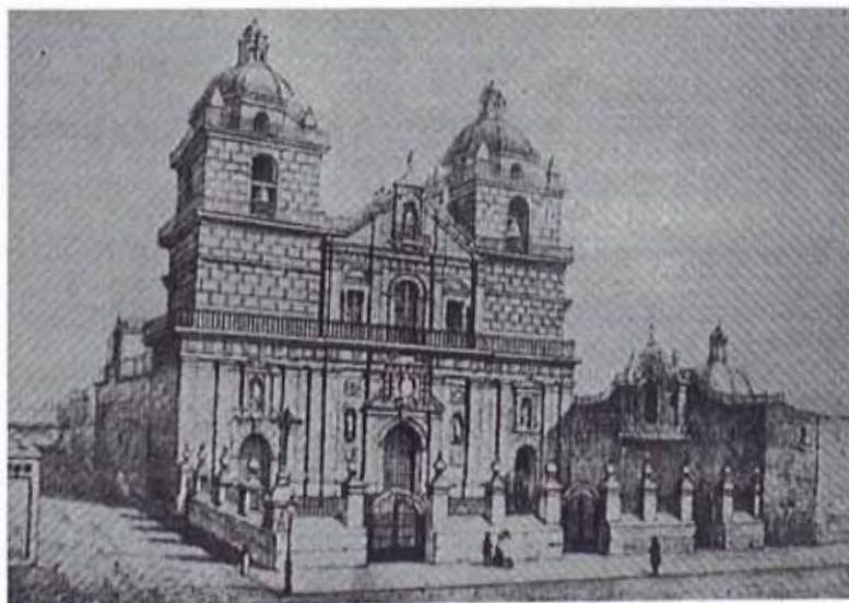
SAN PEDRO: Fachada anterior a 1896 Fuente: El Arquitecto Peruano N° 80, 1944.
