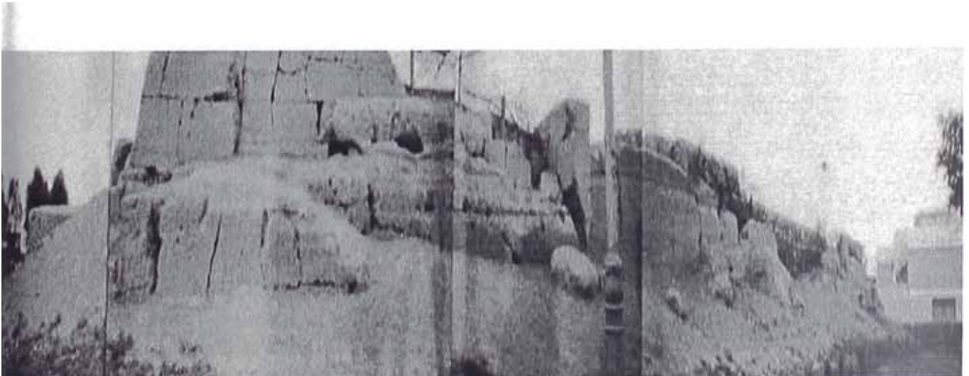
STA. CATALINA: Sector norte inferior pre restauración.
