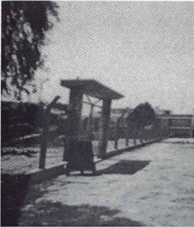
STA. CATALINA: Puerta principal de acceso.
