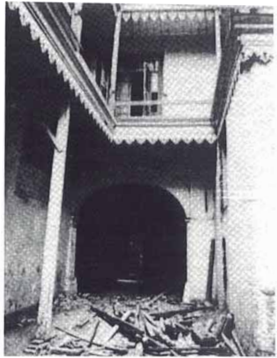
JIMENEZ: Patio pre - restauración Fuente: Fototeca Personal Arq. José Correa, 2000.
