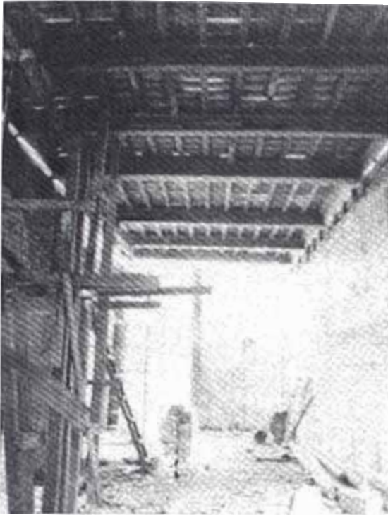
JIMENEZ: Refuerzos estructurales de concreto armado Fuente: Fototeca Personal Arq. José Correa, 2000.
