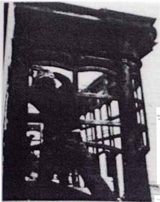
OSAMBELA: Restauración de estructura de un balcón. Fuente: Fototeca Personal Arq. Víctor Pimentel, 2000.
