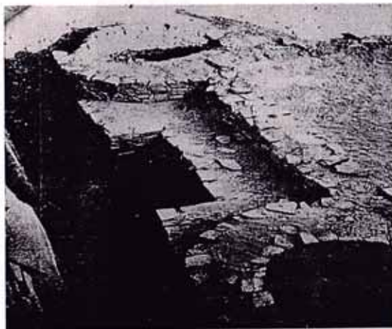
EL PARAÍSO: Plataforma superior post-restauración
