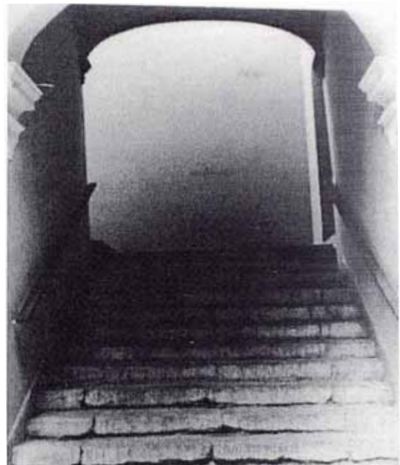
OSAMBELA: Estado actual de la escalera principal. Fuente: Fototeca Personal Arq. Víctor Pimentel, 2000.
