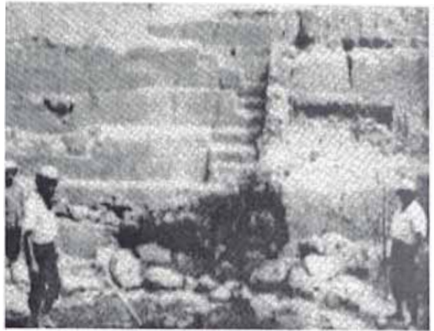
STA. CATALINA: limpieza y escalinata sector este pre restauración.
