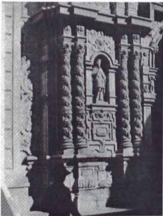
LA MERCED: Decoración de fachada post-restauración
