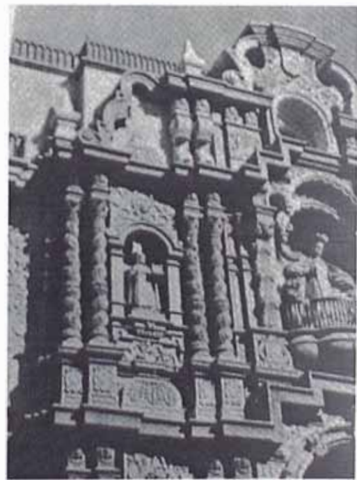
LA MERCED: Decoración de fachada post-restauración
