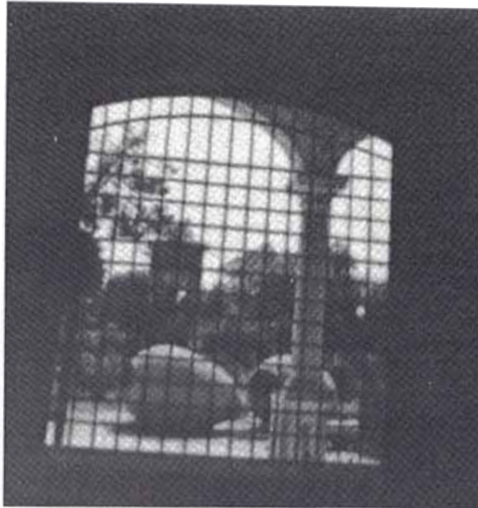
QUINTA DE PRESA: Detalle de reja post- restauración.
