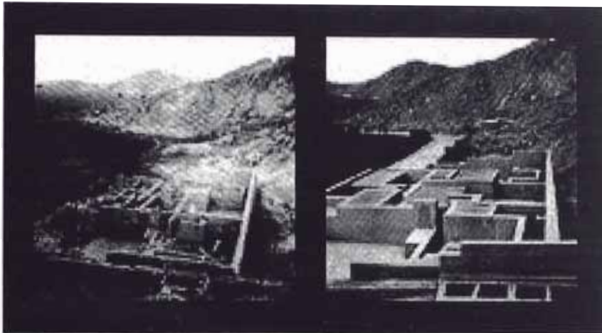
PURUCHUCO: Vista del conjunto pre y post restauración
