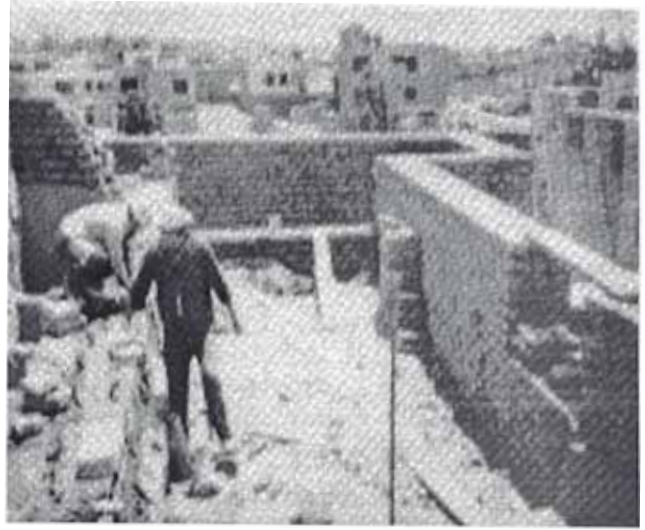
STA. CATALINA: Restauración del templete Fuente: "Informe Arqueológico Huaca Santa Catalina", Humberto Gherzi Barrera, 1972.
