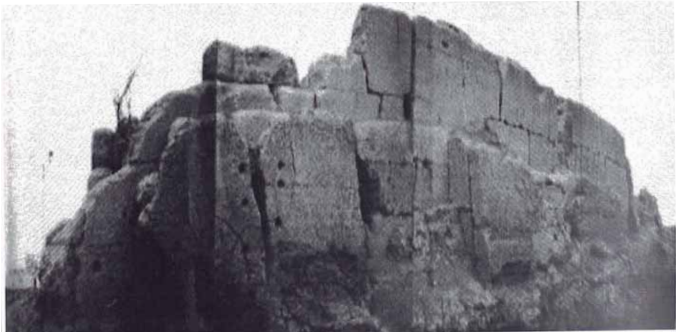
STA. CATALINA: Sector oeste superior pre restauración.
