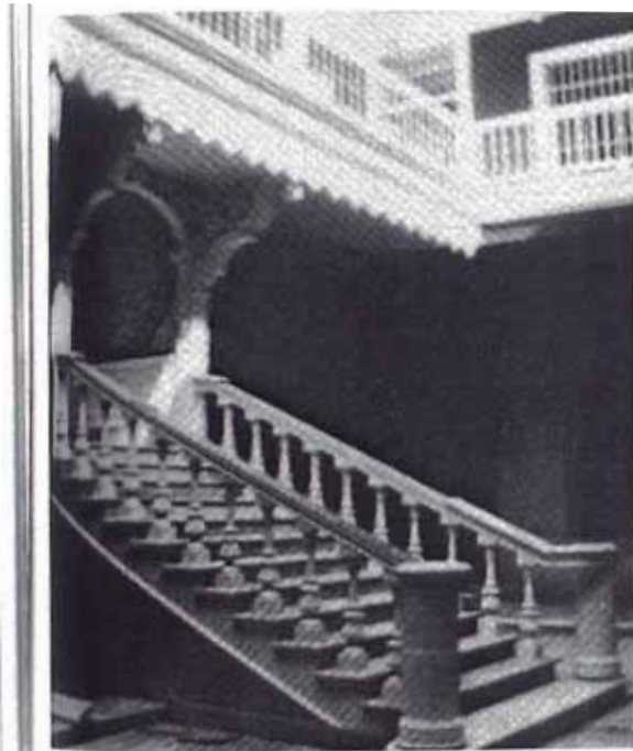
JIMENEZ: Escalera principal post restauración
