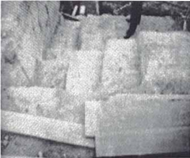
STA. CATALINA: Limpieza y escalinata sector este pre restauración.
