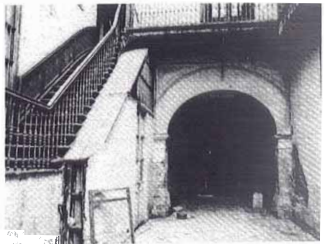
JIMENEZ: Patio pre restauración Fuente: Fototeca Personal Arq. José Correa, 2000.
