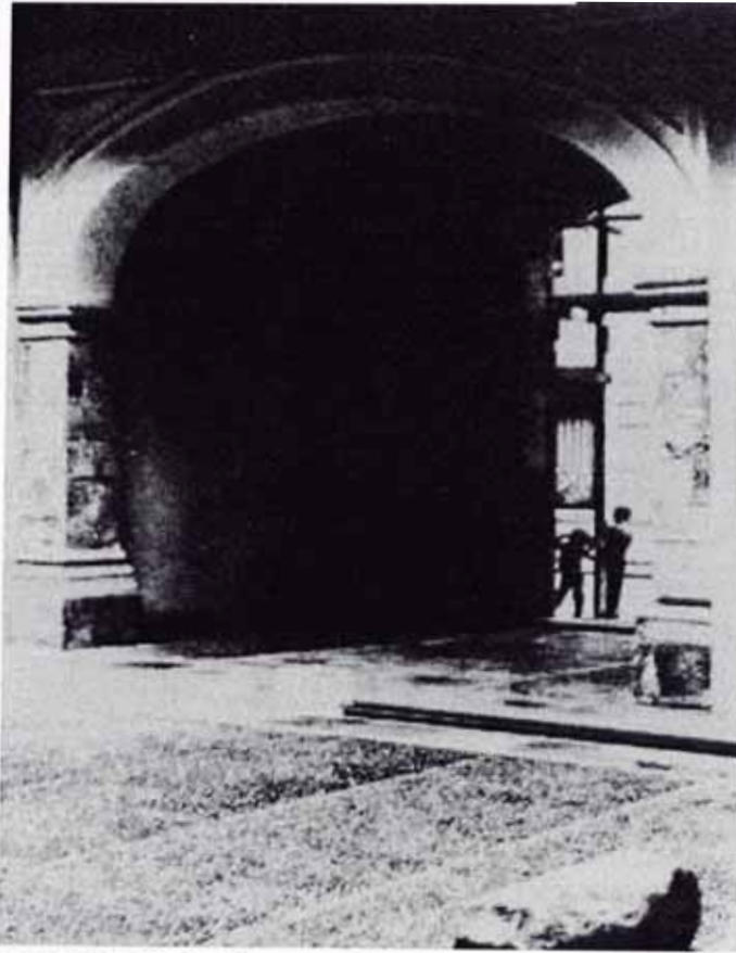
OSAMBELA: Patio y zaguán restaurados. Fuente: Fototeca Personal Arq. Víctor Pimentel, 2000.
