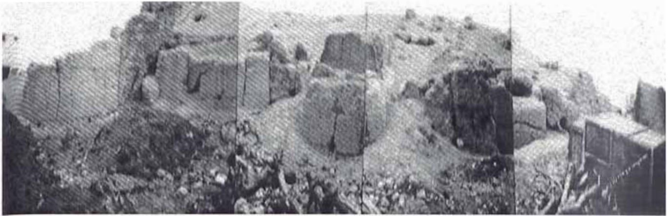
STA. CATALINA: Sector sur inferior pre restauración.
