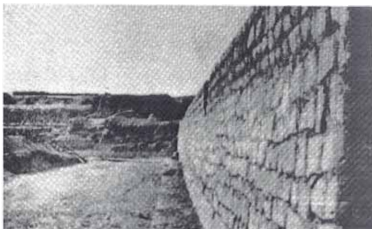
PACHACAMAC: Muro circundante reconstruido cisterna 1
