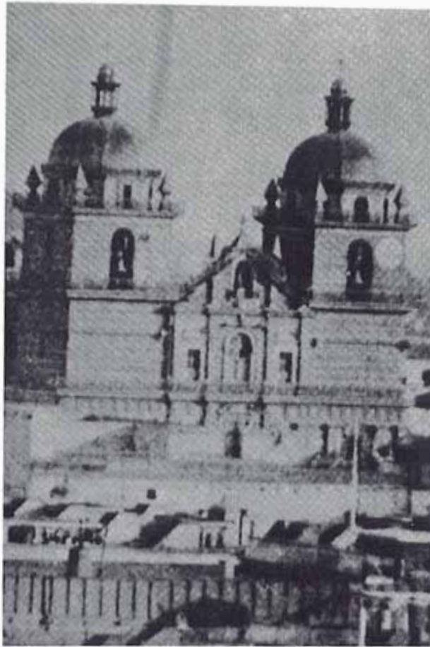
SAN PEDRO: Fachada anterior a 1896 Fuente: El Arquitecto Peruano N° 80, 1944.
