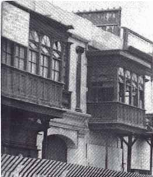
JIMENEZ: Balcones pre - restauración Fuente: Fototeca Personal Arq. José Correa, 2000.
