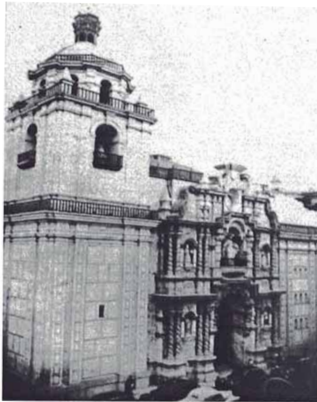
LA MERCED: Fachada post-restauración Fuente: El Arquitecto Peruano N° 39, 1940.
