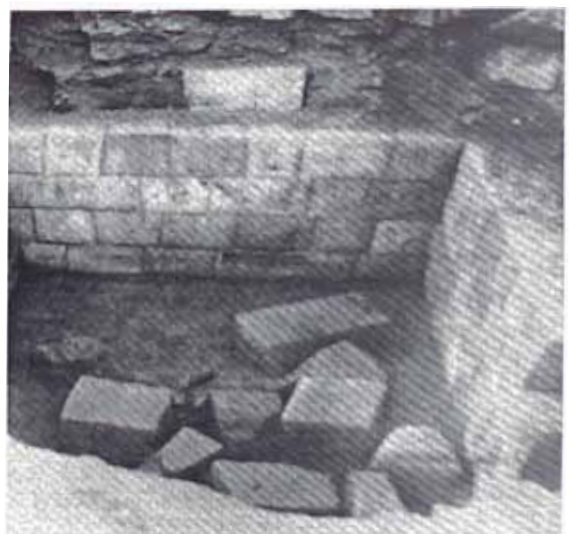
PACHACAMAC: Cisterna de piedras labradas pre - restauración
