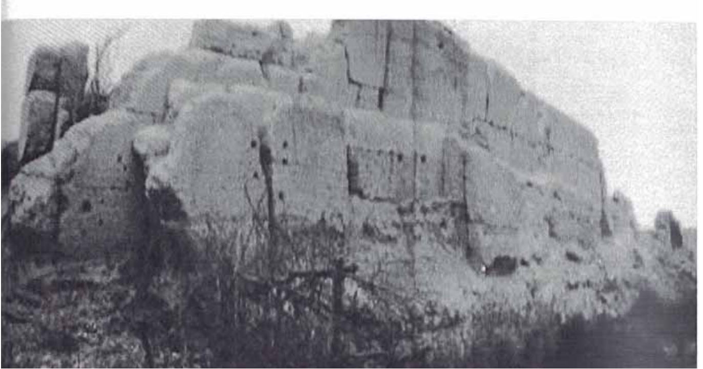
STA. CATALINA: Sector oeste inferior y superior pre restauración.
