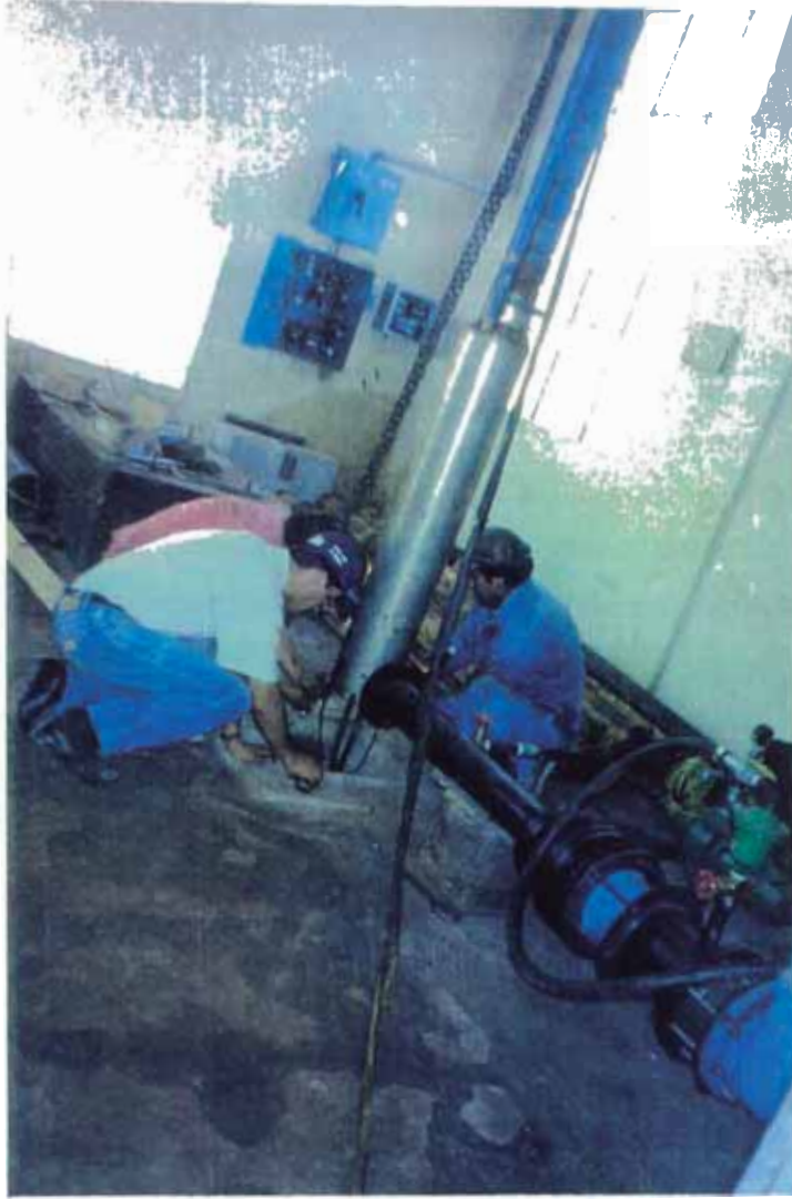
MONTAJE DEL EQUIPO SUMERGIBLE DEL POZO CAJUCA Nº 1
