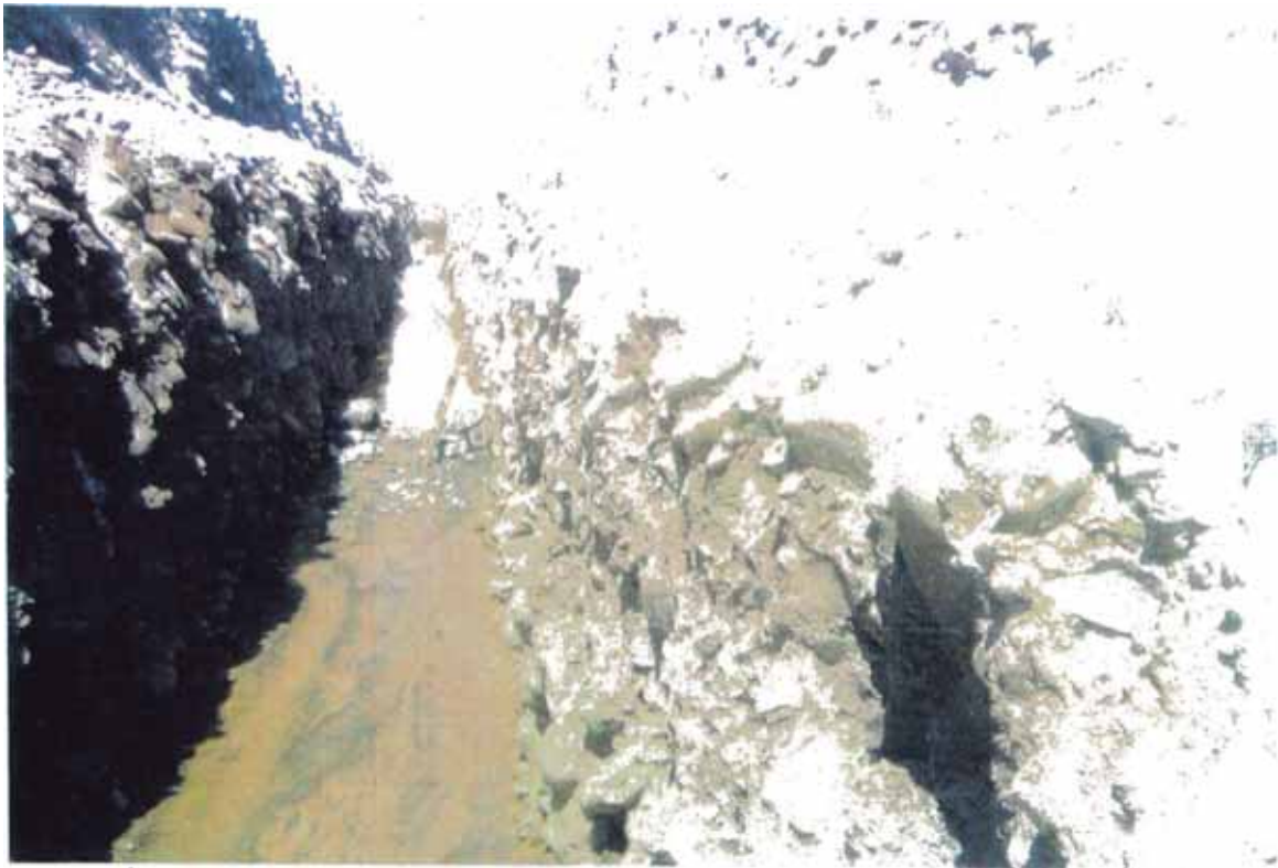
ZANJA DE PROFUNDIDAD PROMEDIO DE 9 M, PARA LA INSTALACIÓN DE DRENES (GALERÍA RÍO - AJA)
