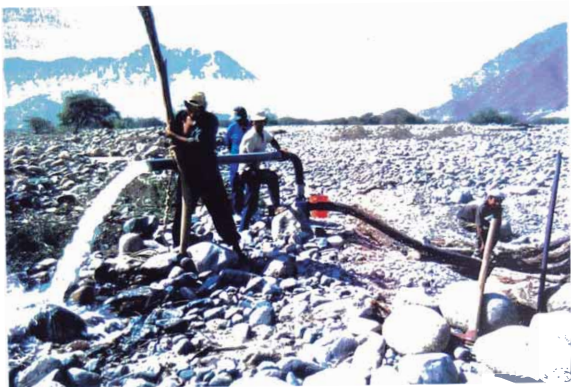
PRUEBA DE BOMBEO EN LA CALICATA SOBRE EL LECHO DEL RÍO AJA
