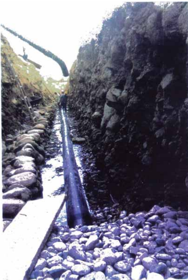
INSTALACIÓN DE TUBERÍA PERFORADA. CONSTRUCCIÓN DE GALERÍA FILTRANTE RÍO AJA
