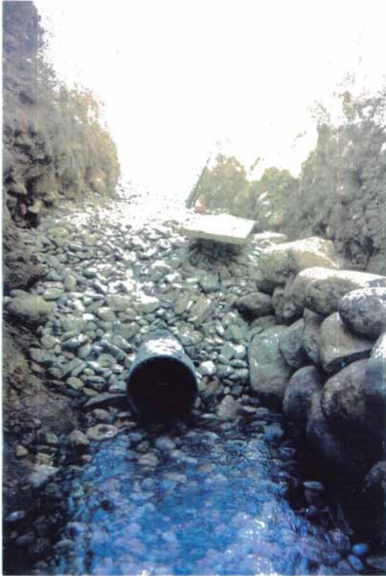
COLOCACIÓN DE GRABAS CUBRIENDO LA TUBERÍA PERFORADA. CONSTRUCCIÓN DE GALERÍA FILTRANTE RÍO AJA
