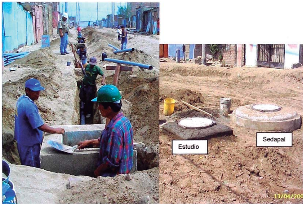
Foto N° 9.2: Fase de construcción conexión domiciliaria.
