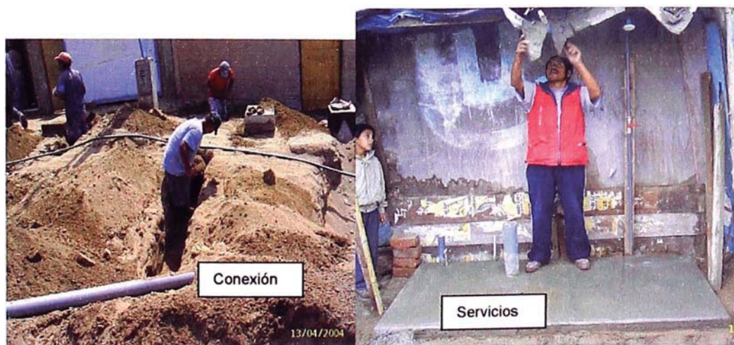
Foto N° 9.2: Fase de construcción conexión domiciliaria.
