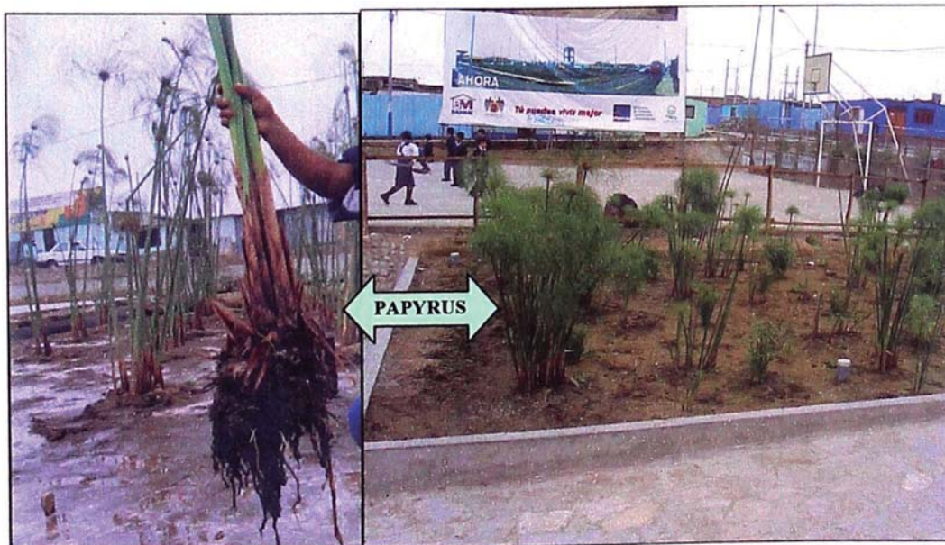
Foto 4.8: Izquierda: Siembra de Papyrus, en Humedal Subsuperficial Oasis, Derecha: Se aprecia la densidad de plantación.
