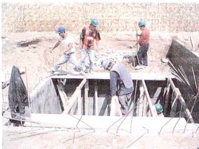
Foto N° 9.13: Construcción del tanque de almacenamiento de agua tratada.
