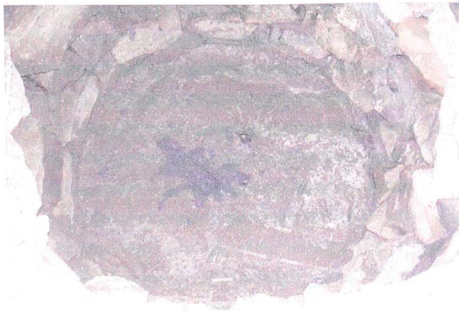
Foto N° 9.26: Pozo Percolador de Lodos Provenientes del Sedimentador
