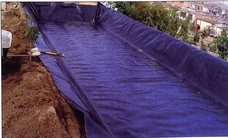
Foto 4.3: Colocación de Geomembrana
