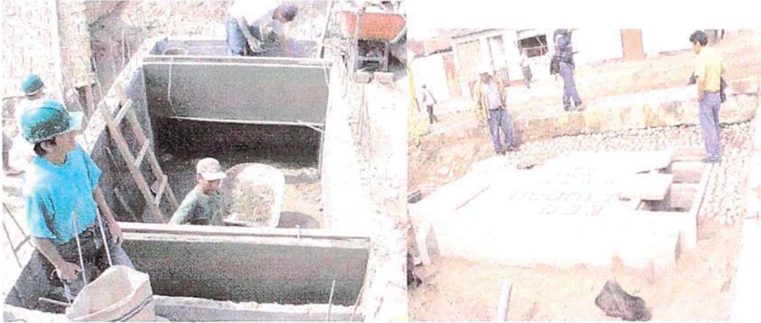
Foto N° 9.3: Fase construcción de sedimentador.
