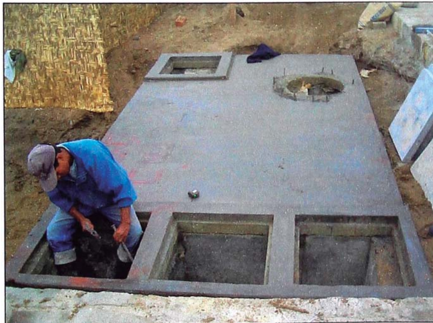
Foto 4.2: Construcción del Sedimentador.
