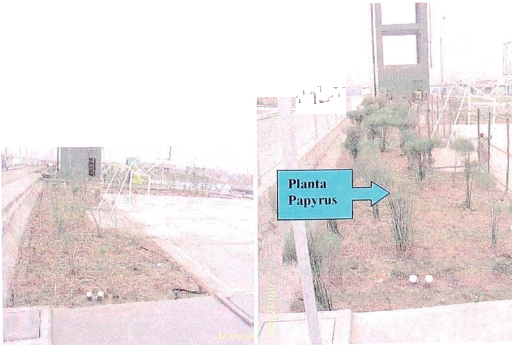
Foto N° 9.6: Papyrus instalado en humedal de flujo vertical
