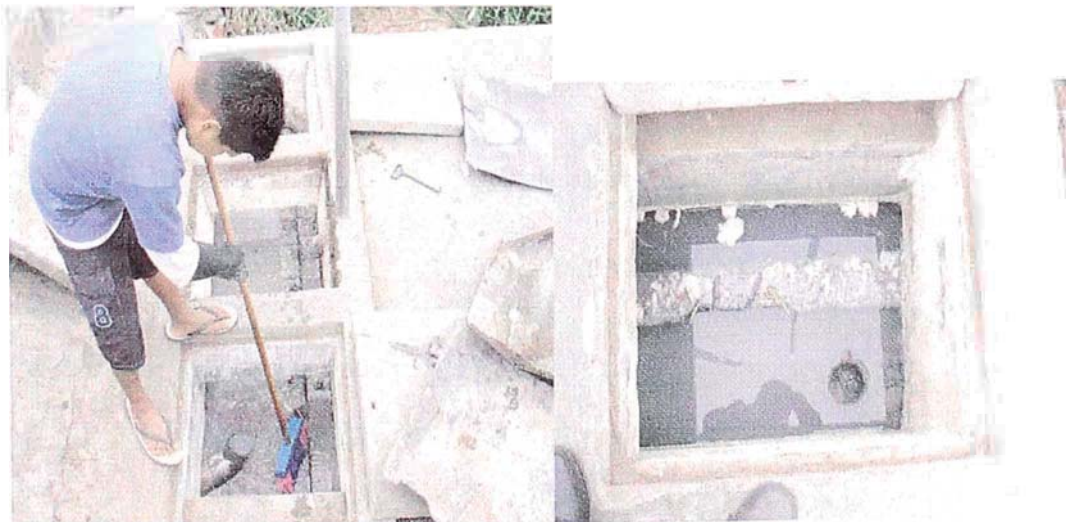
Foto N° 9.24: Operación y Mantenimiento de las unidades de ingreso y salida al Sedimentador
