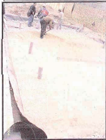
Foto N° 9.10: Instalación del Material Fino, sobre el lecho del Humedal.
