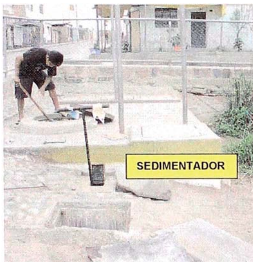
Foto N° 9.24: Operación y Mantenimiento de las unidades de ingreso y salida al Sedimentador
