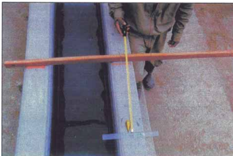
Foto 8.4. Medida del tirante seco el cual es usado para medir por diferencia con la altura total (tirante seco + tirante mojado) el nivel de agua en el canal aguas arriba del medidor Palmer Bowlus.
