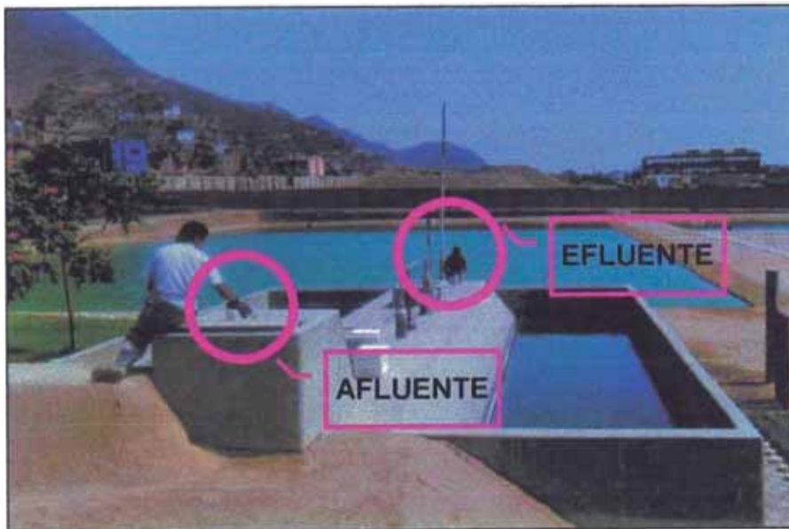
Foto 8.2. Toma de muestras en el afluente y efluente del RAFA a las 14:00 horas del día en forma simultánea.
