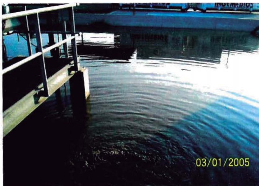
FIGURA 25. EXTRACCIÓN DE LODOS DEL TANQUE DE HOMOGENIZACION
