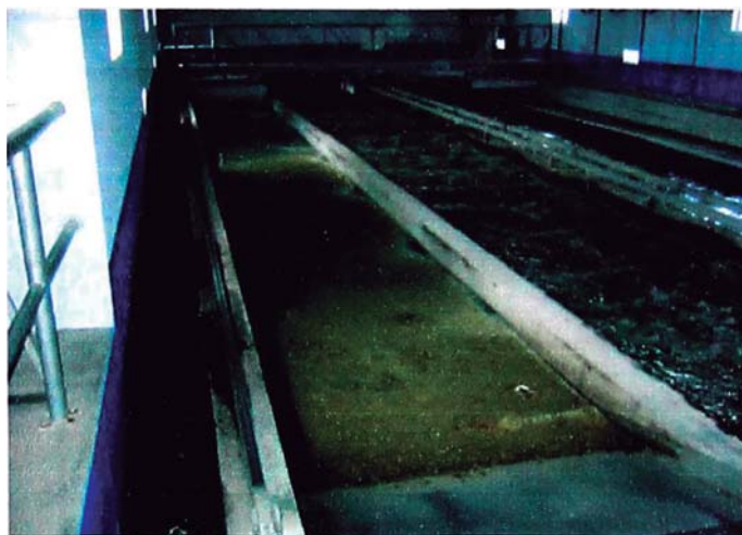
FIGURA 4.- DESARENADOR Y DESENGRASADOR
