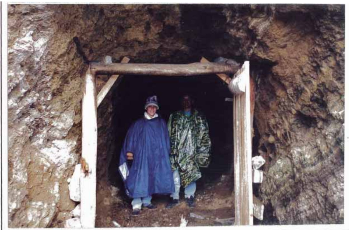
Foto N° 5.21: Se observa una bocamina abandonada (Mina Santa Teresita), de donde escurre, producto de la oxidación, efluente con alto potencial de drenaje ácido.
