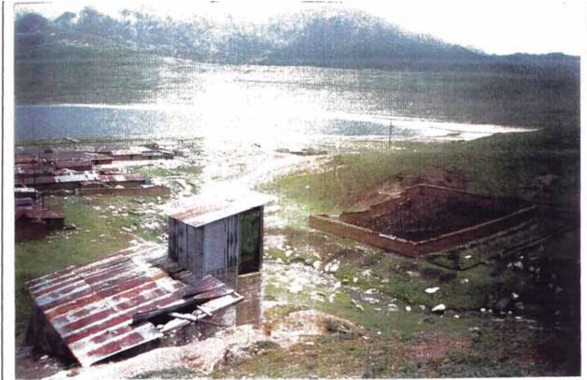
Foto N° 5.18: Se observa el reservorio de agua del poblado de Marcapomacocha (lado inferior izquierdo). Se encuentra en malas condiciones de salubridad.
