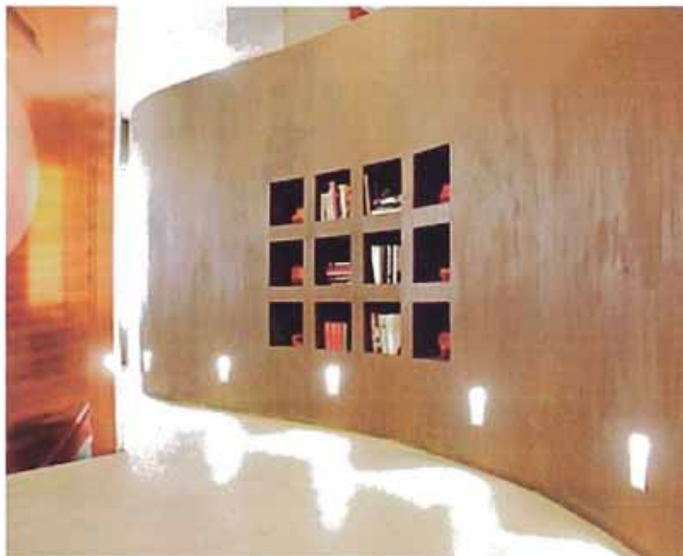
Figura N° 35: Luminarias en zócalo y estantes empotrados en pasillo.
