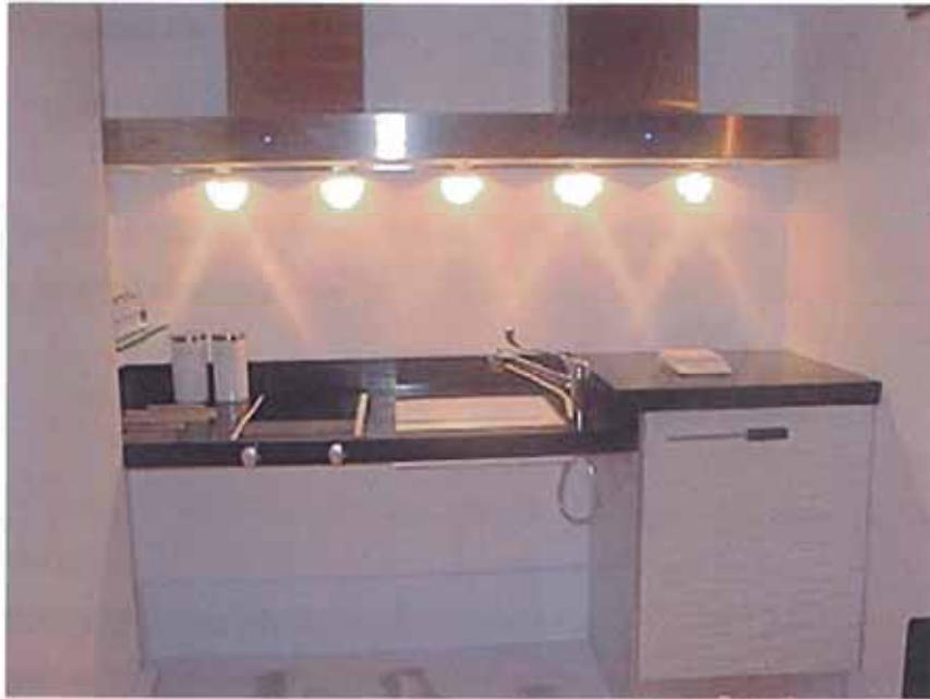
Figura N° 49: Diferencia cromática entre mobiliario y paredes. Nótese iluminación adicional en área de trabajo.
