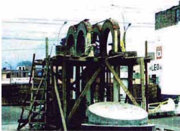
Encofrado del monumento central, en esta página se muestran 3 etapas del proceso constructivo, del mismo.
