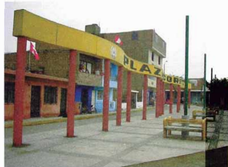
Dos fotos del parque, a días de la inauguración (izq.) y en la actualidad. El nombre del parque ha cambiado a Plaza Corea, y las luminarias han sido eliminadas, quedando solo los postes vacíos.
