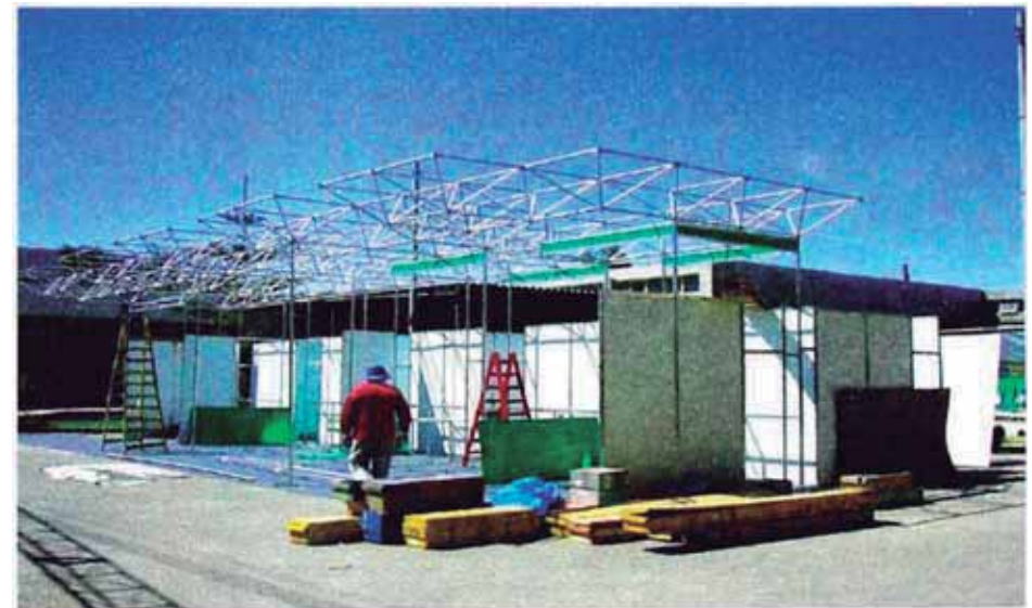
Proceso constructivo de la coberura, modulada con perfiles octanorm.
