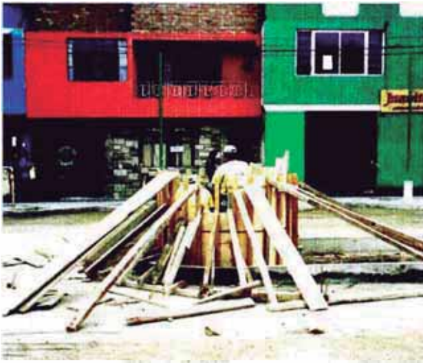
Encofrado del monumento central, en esta página se muestran 3 etapas del proceso constructivo, del mismo.
