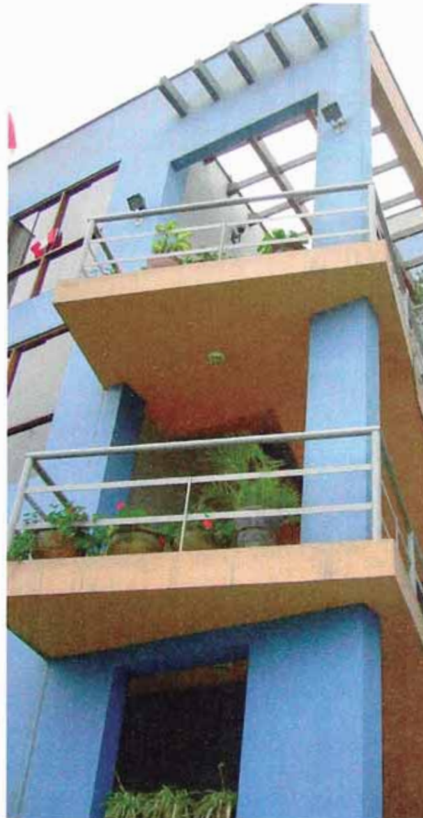
Vista de la escalera de ingreso y elementos decorativos funcionales del mismo.
