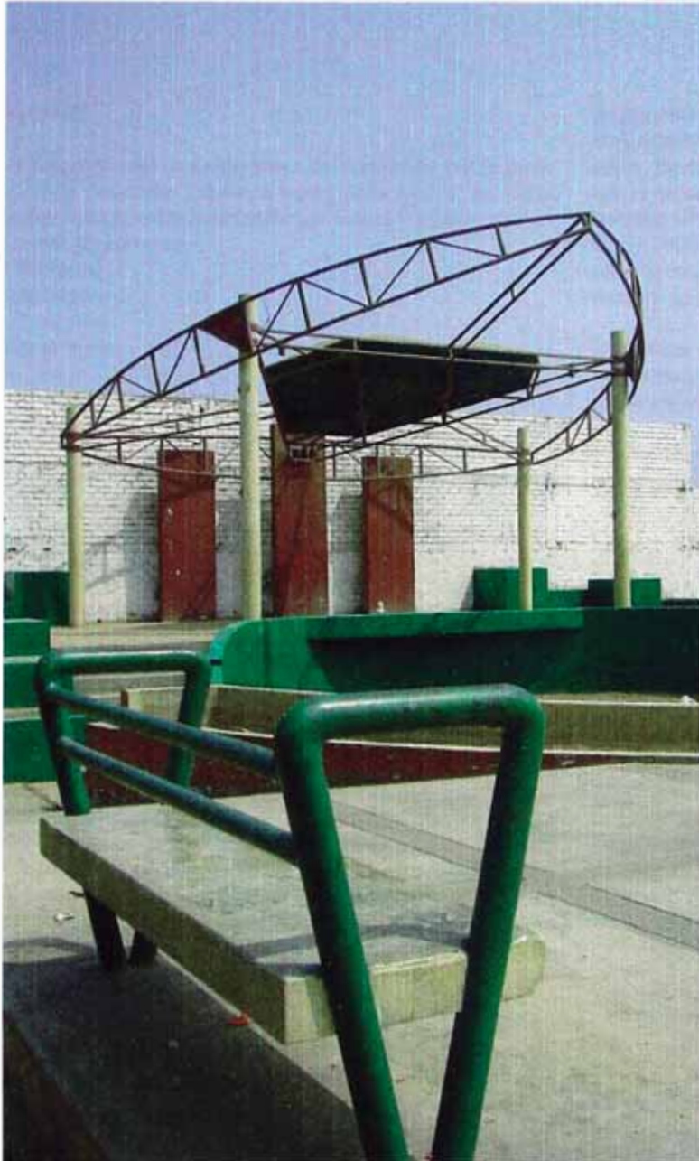
Vista del proscenio en etapa de construcción, está elevado sobre la plaza y ses el remate del anfiteatro.
