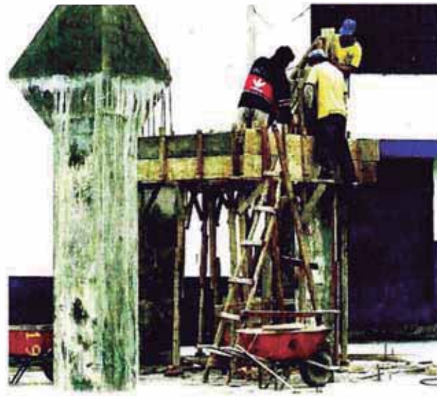
Bancas de concreto si acabados Abajo: Vigas encofradas listas para el vaciado de concreto.
