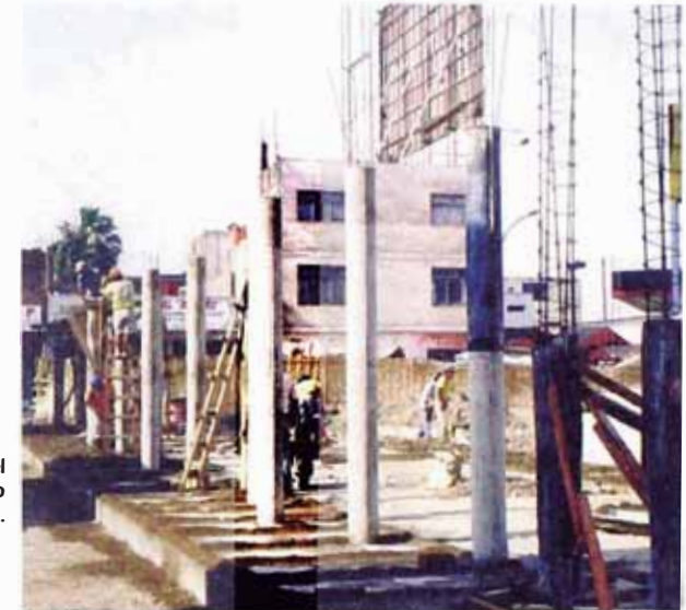
A la izq. Planta y Corte típico del pórtico, el cual se aprecia en esta foto durante su etapa de construcción.
