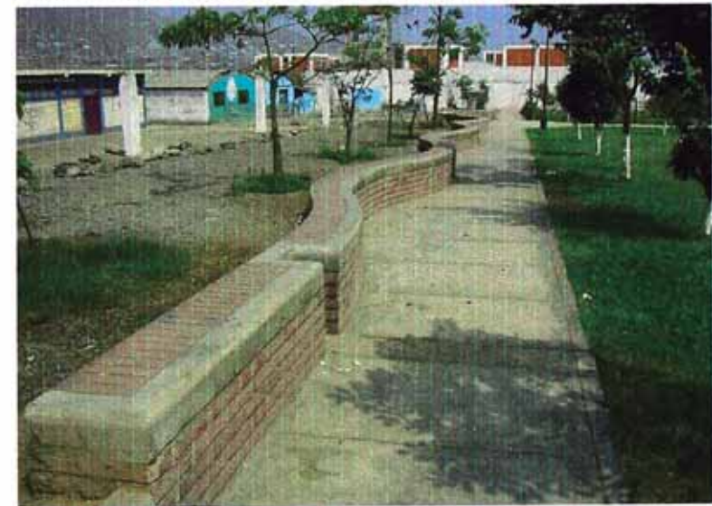
Vista Superior: Tratamiento de veredas, en base a cemento pulido y bruñado Abajo: Detalle de banca corrida de ladrillo caravista, delimita el parque con las otras áreas públicas.
