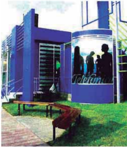
Plaza Telefónica - Boulevard Asia Vista Ingreso
