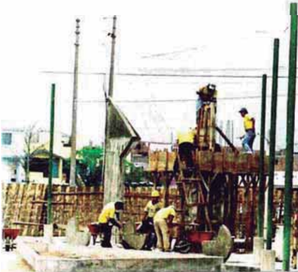
El pasaje el Tumi se remodeló en su totalidad, aquí habilitando la pista. Abajo: encofrado de pórticos de ingreso.
