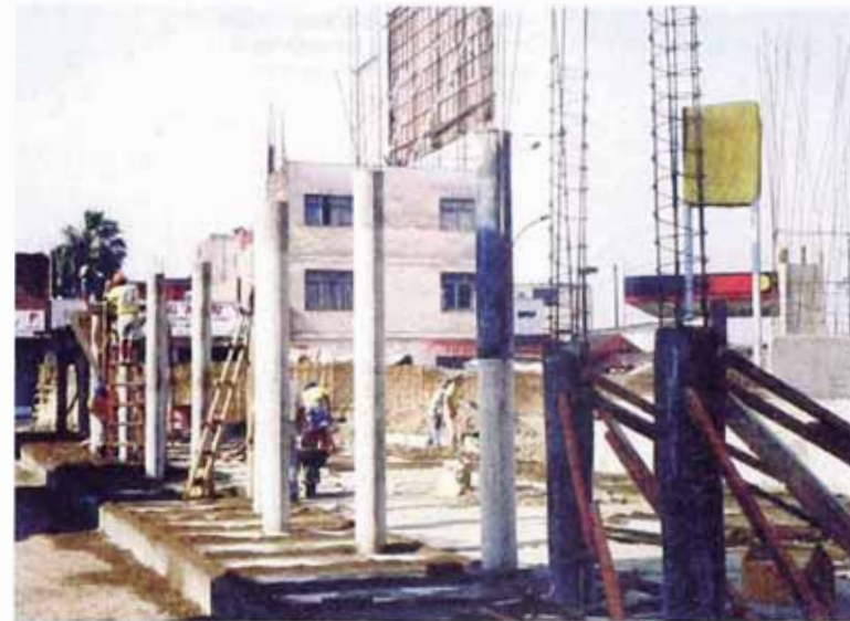
A la Izq. Vaciado de muros de plataforma conmemorativa. A la Der. Columnatas del pórtico ubicado delante de la viviendas existentes.
