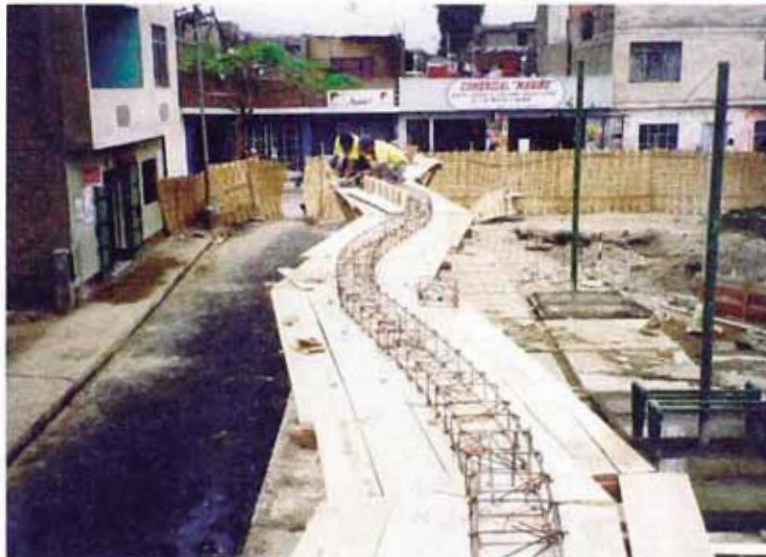
Proceso constructivo de la viga curva del pórtico A la Der. Vista del pórtico terminado, con columnatas y vigas curvas.
