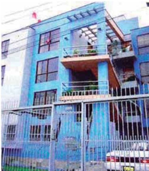
Edificio Multifamiliar Morro Solar
