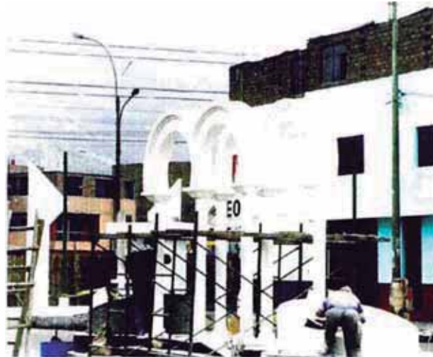
Tanajeado y acabados del monumento, para su posterior pintado, en las fotos siguientes.
