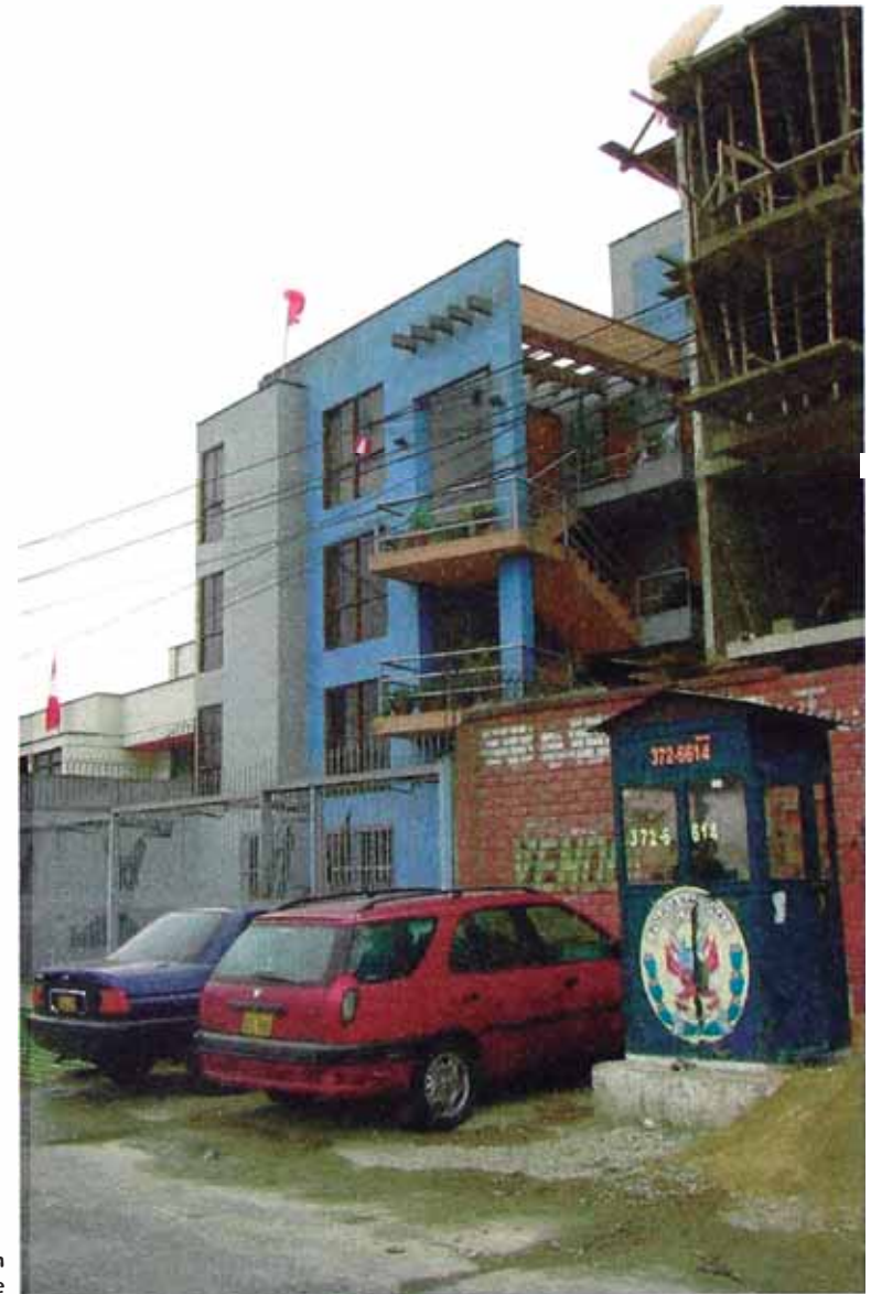
Vista de la fachada y construcción adyacente
