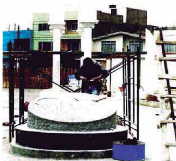
Tanajeado y acabados del monumento, para su posterior pintado, en las fotos siguientes.
