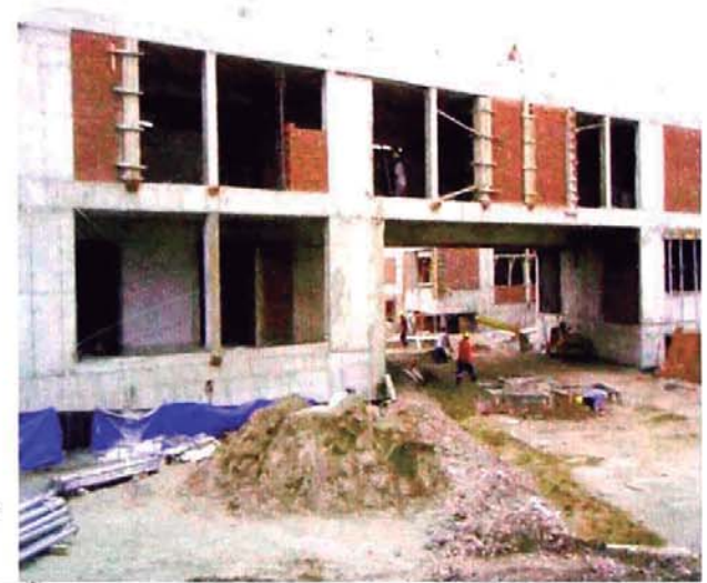
VISTA DEL PUENTE ENTRE LOS SECTORES I Y III
