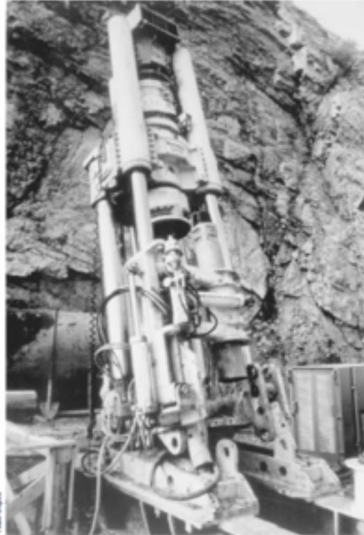
Figura 7 - Máquina Perforadora de pozos - Fuente: OIT
