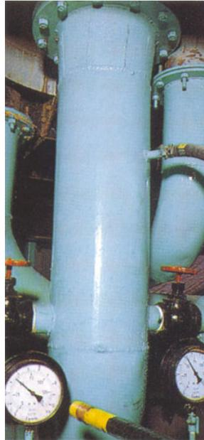
**Figura 2.6:** Unidad ADT, de un en clarificador Daf de patente Krofta, tomado de <http://www.kroftaengineering.com/krofta-supracell.html>
