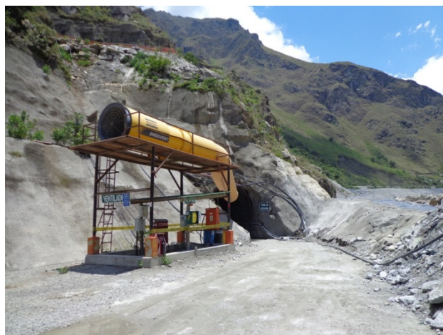
Figura 6: Vista de la ventana N°02 del túnel de conducción de la Central Hidroeléctrica Santa Teresa.
