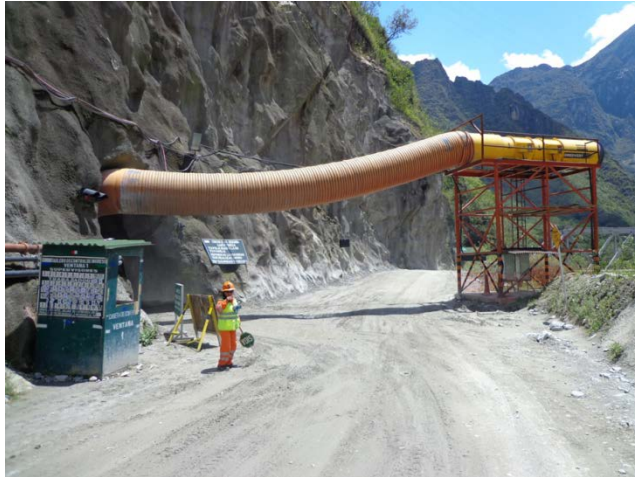
Figura 5: Vista de la ventana N°01 del túnel de conducción de la Central Hidroeléctrica Santa Teresa.
