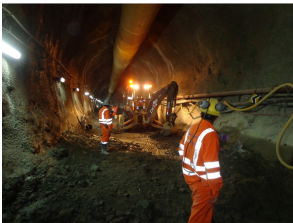
Figura 7: Vista de Los trabajos de ejecución que se realizan en el interior del túnel de conducción de la Central Hidroeléctrica Santa Teresa.
