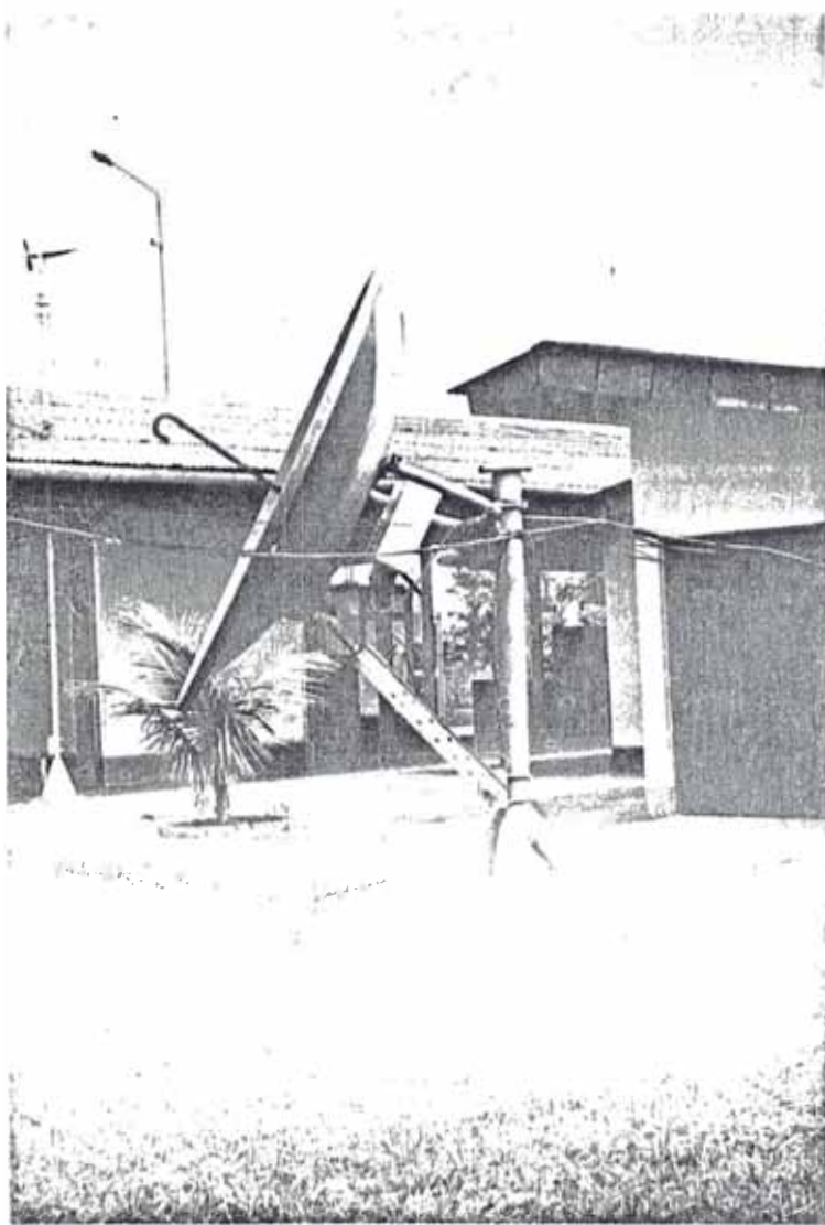
FIG. 2.3 ANTENA RADIOMETRICA DE 11.6 GHz (D/C EN LA PARTE POSTERIOR DE LA ANTENA)
