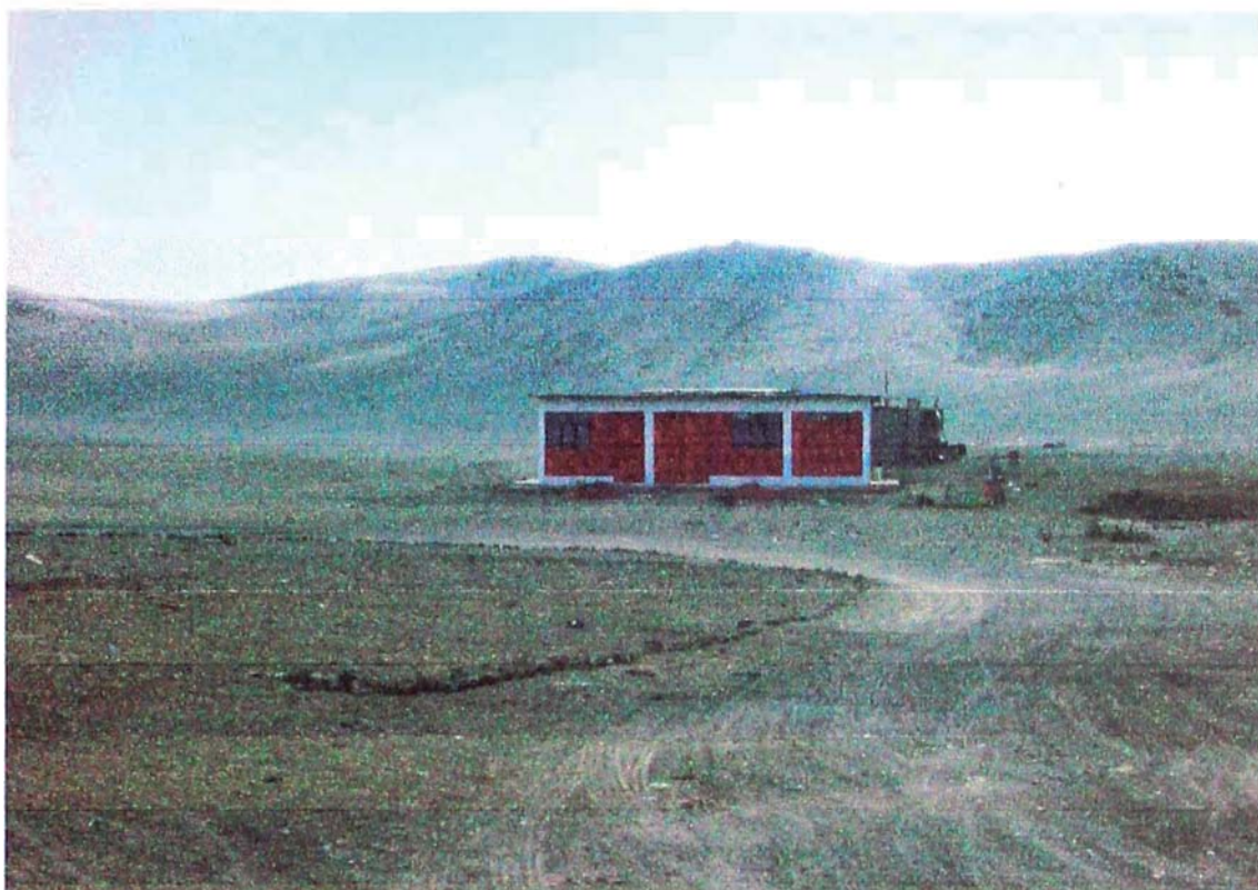
Fotografía 13: Vista panorámica de la actual casa de los segregadores y áreas administrativas del relleno sanitario
