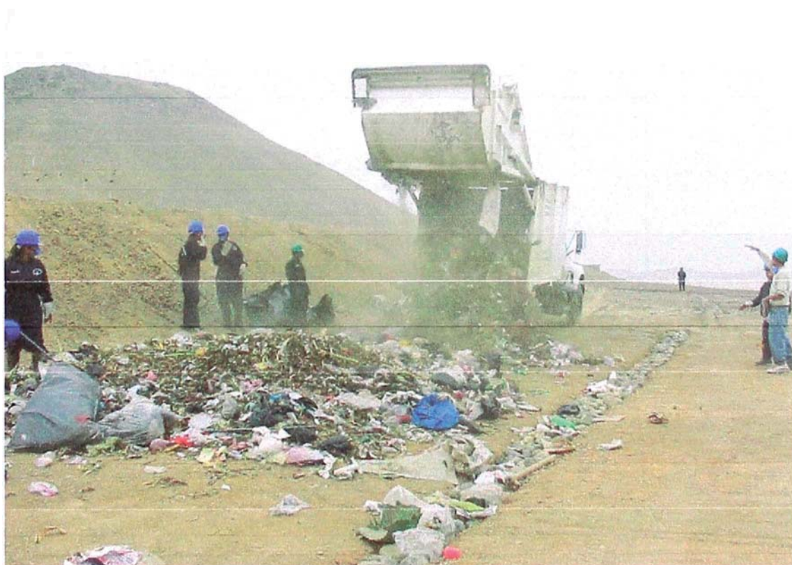
Fotografía 10: Descarga de residuos sólidos en trinchera sanitaria del actual relleno sanitario de Huarney
