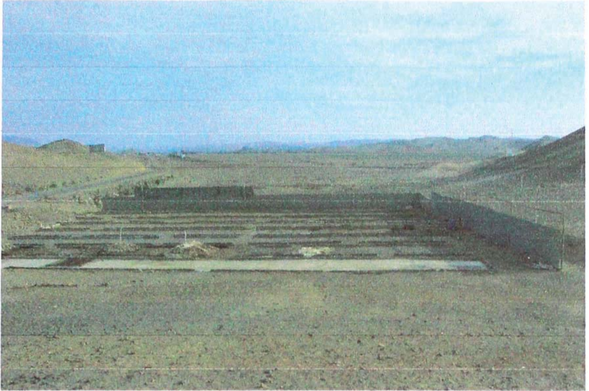
Fotografía 15: Vista panorámica de la planta de tratamiento de residuos orgánicos
