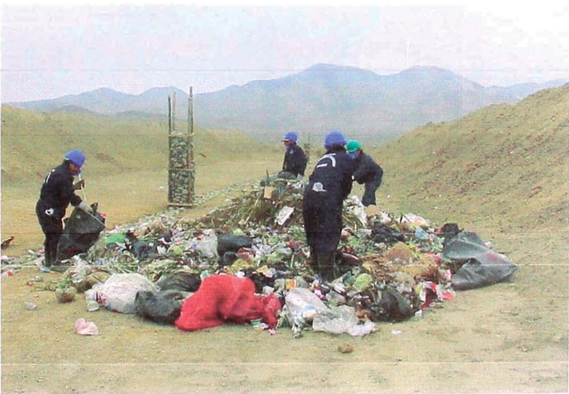
Fotografía 12: Trabajos del personal de la microempresa en trinchera sanitaria
