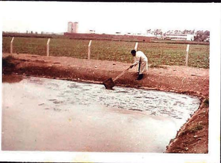
LIMPIEZA DE SOLIDOS FLOTANTES
