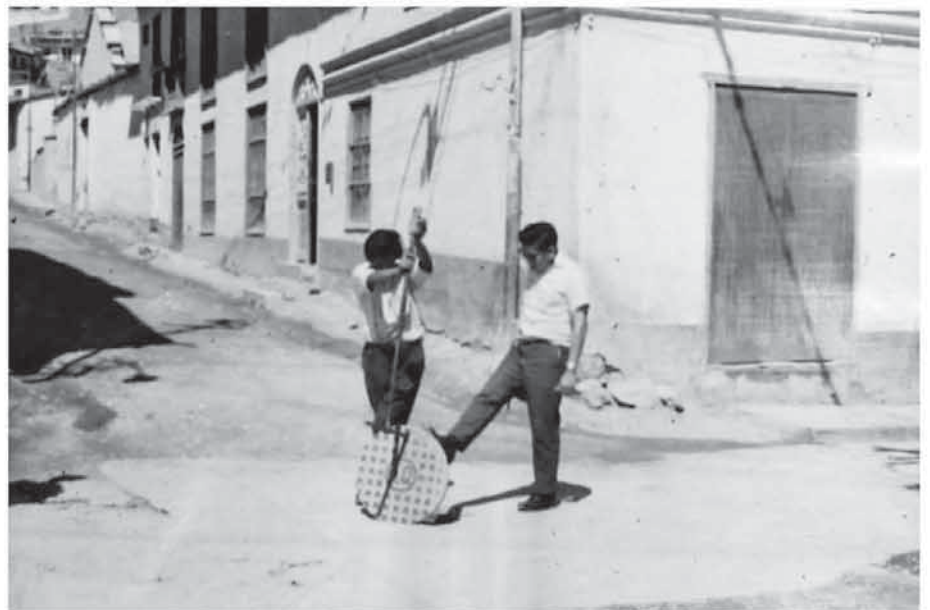
4.- INSPECCION DE BU- ZONES DE LA RED DE DESAGUES
