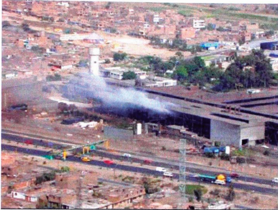
Foto 7: Fotografía tomada el 14 de febrero del 2002. Obsérvese emisiones fugitivas ostensiblemente visibles de coloración gris, conteniendo partículas y gases provenientes del sector de hornos (puede estar asociada a la inyección de oxígeno al material fundido).
