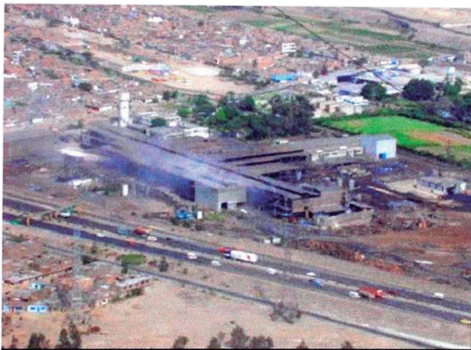
Foto 6: Fotografía tomada el 14 de febrero del 2002. Obsérvese emisiones fugitivas ostensiblemente visibles de coloración gris, conteniendo vapor y otros gases provenientes del sector de tornamesa
