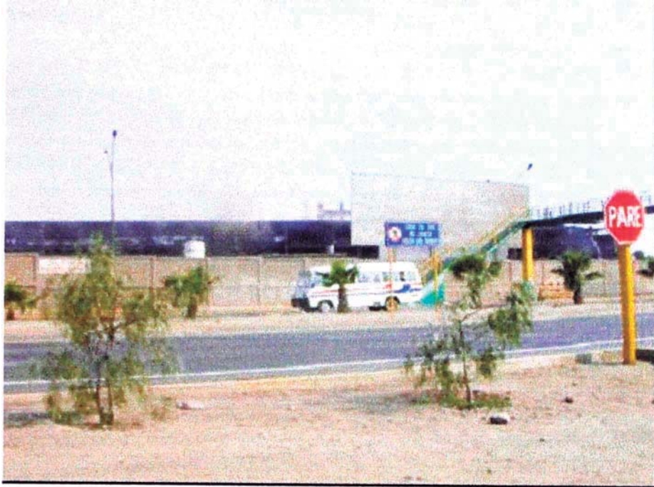
Foto 9: Fotografía tomada el 14 de febrero del 2002. Obsérvese emisiones fugitivas ostensiblemente visibles de coloración gris, provenientes del sector de hornos.
