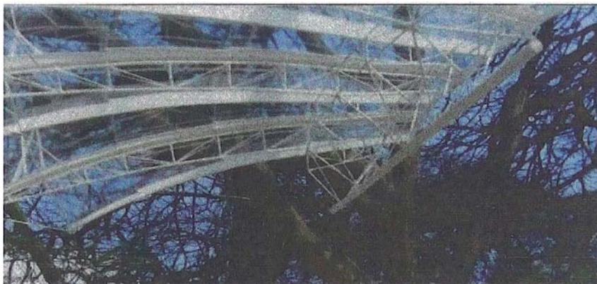
La flexibilidad del material permite elaborar diseños como el siguiente previsto para cubrir el patio interior de un nuevo hotel en Lima, la estructura tridimensional de fierro y las planchas de policarbonato compacto juegan con las formas curvas – cónicas muestra de la versatilidad del material y de las posibilidades de diseño.
