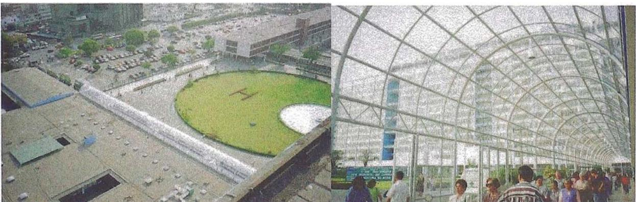
6. Limpieza y mantenimiento: El estado actual de limpieza y mantenimiento es Bueno, las planchas de policarbonato necesitan estar muy limpias por su calidad de transparencia, Como diseño dispone esta cobertura de un sistema de drenaje que permite evacuar las aguas pluviales.
