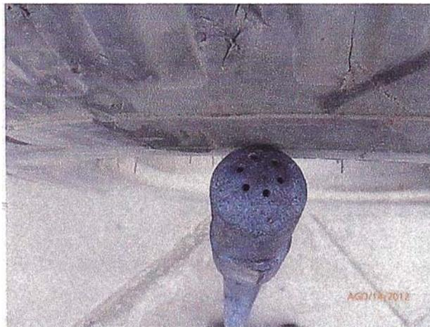
**Figura 3.2:** Boquilla de gas combustible en buen estado
