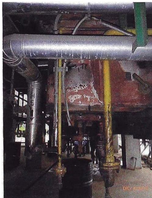
**Figura 3.9:** Derrame de aceite combustible en un Horno de Destilación que causa coquificación en las boquillas de combustibles, obstruyéndolas.
