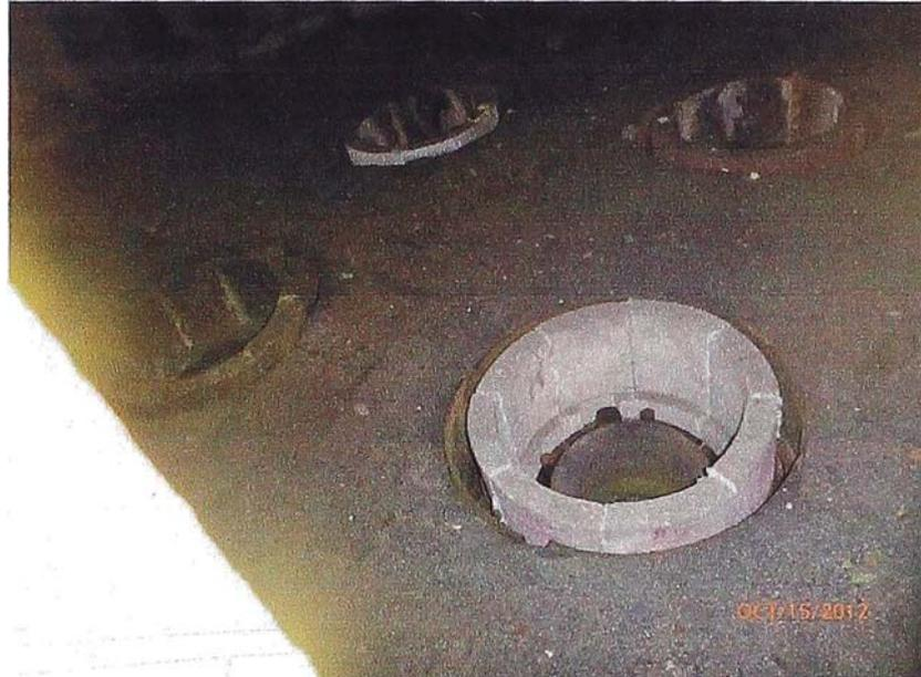
**Figura 3.3:** Muflas instaladas con mortero inadecuado (no soportan altas temperaturas) que desencadenan lo observado en la Figura 3.4.
