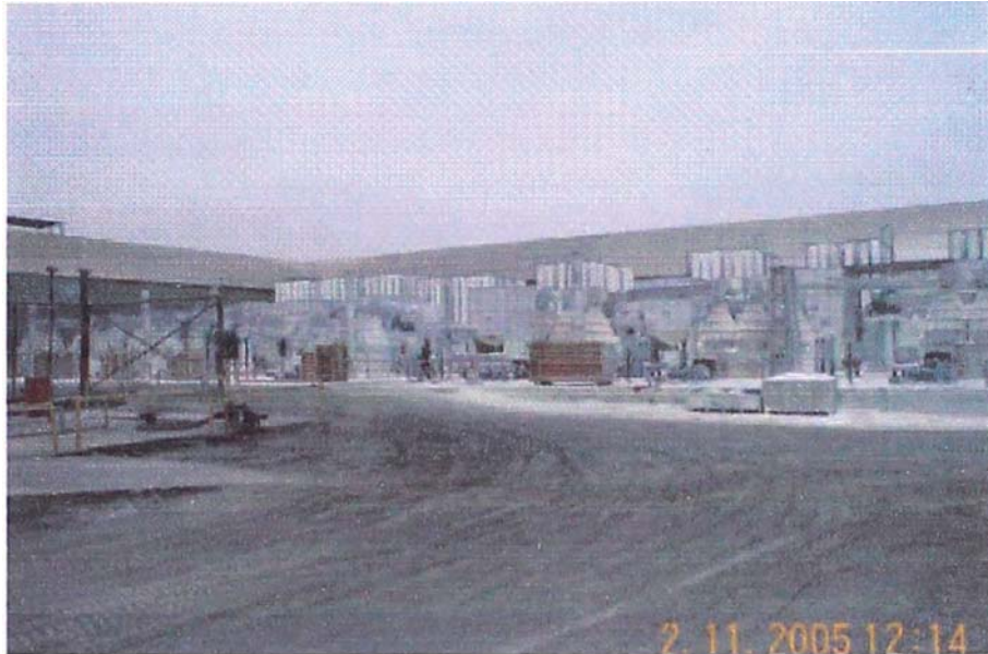
Foto N° 1 : Vista de la Unidad Operativa Oxido de Zinc
