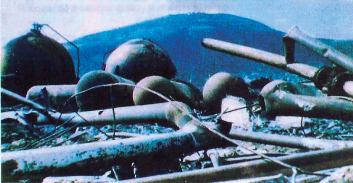
Foto N° 3: Después de las explosiones como quedó la Refinería
