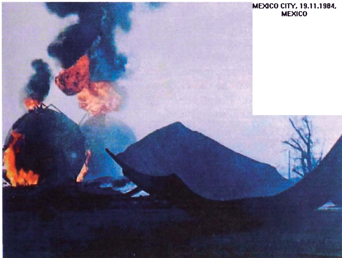
Foto N° 1: Explosiones en los tanques de GLP producidos en la Refinería
