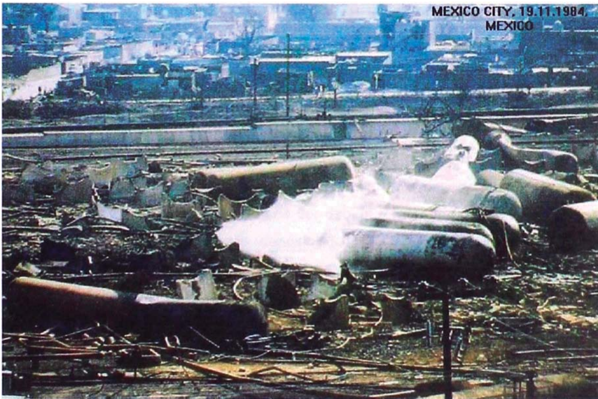
Foto N° 2: Condiciones en las que quedó la Refinería después de las explosiones
