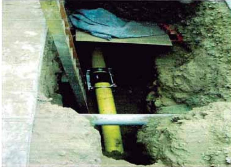
**Figura N° 40: Fusión de tuberías 2**
