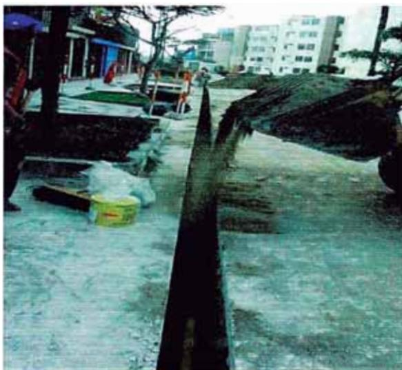
El ancho de zanja debe permitir el relleno y la compactación, de tal manera que las cargas mecánicas horizontales y verticales actuantes no dañen la tubería.
