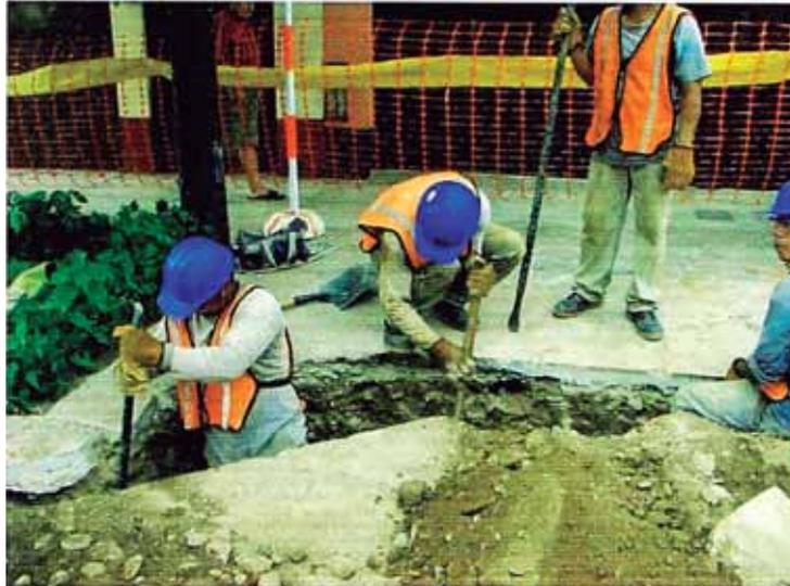
También puede ser una combinación de los 2 métodos mencionados, siempre que se cumpla con los requisitos del ancho y profundidad de zanja para la instalación de la tubería.
