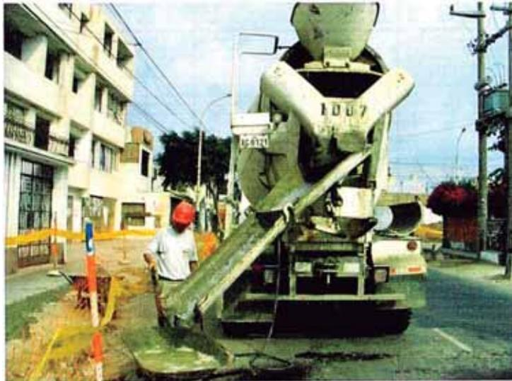
**Figura N° 31: Arreglo de concreto vertido en la zanja**
