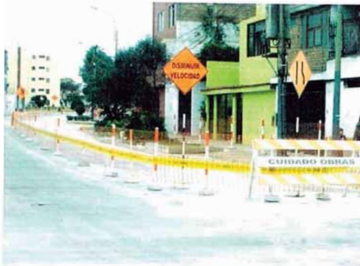
Asimismo se colocan carteles, letreros, tranqueras y demás elementos de seguridad (mediante señales informativas, prohibitivas, obligatorias o de advertencia) conforme al Manual de Dispositivos de Control del Tránsito Automotor para Calles y Carreteras (Ver anexo 10.4: Dispositivos de control de tránsito a través de zonas de trabajo).
