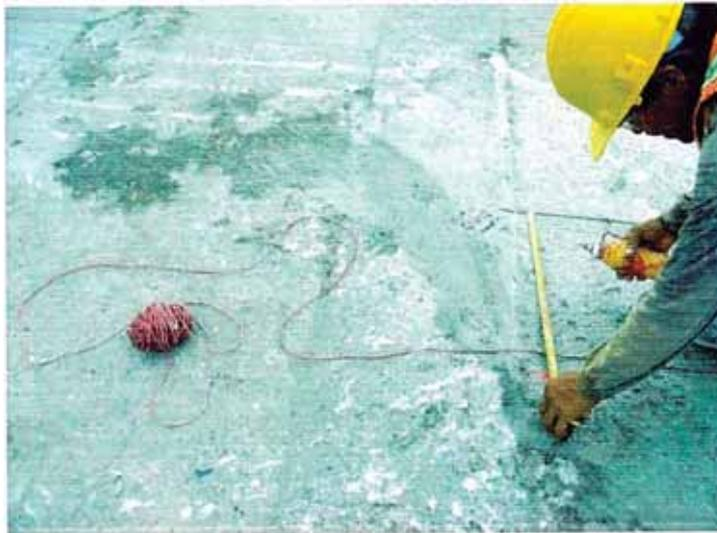
**Figura N° 07: Marcado de pavimento**
