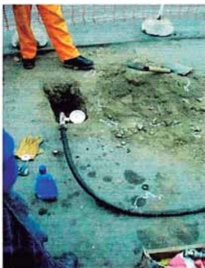
Se toman las precauciones necesarias para evitar desplazamientos de la tubería por descompresión repentina. Los tapones y trampas usados como cabezales de prueba deberán contar con dispositivos de seguridad que eviten su expulsión accidental.
