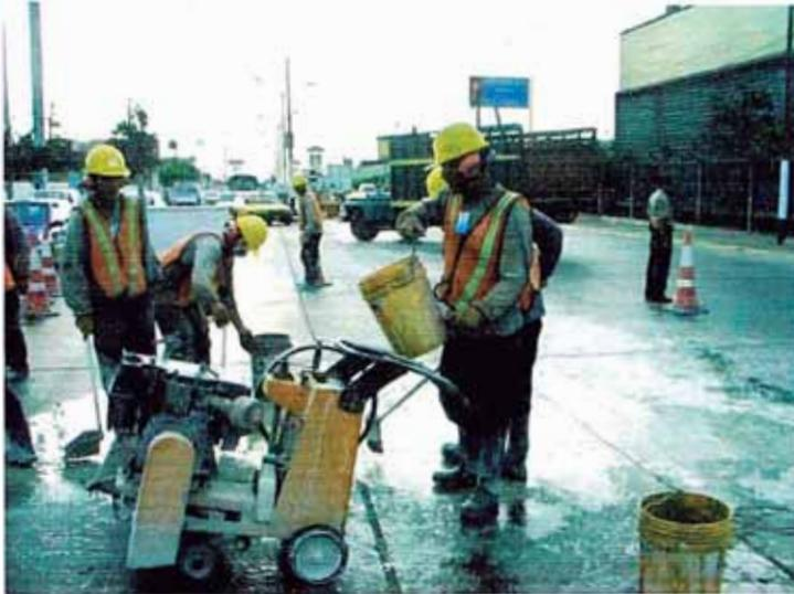
**Figura N° 10: Uso de equipos cortadores de pavimento**
