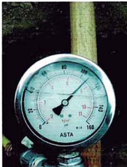
Es necesario controlar que el aceite del compresor de aire no penetre en el sistema de tuberías y que la temperatura del aire no sobrepase los 40° C, para evitar riesgos de deterioros de los tubos y/o accesorios.
