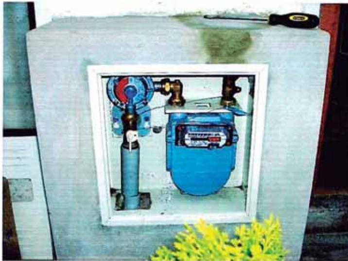
Finalmente viene la conexión interna domiciliaria, conformada por una tubería de cobre de  $\frac{1}{2}$  pulgada o  $\frac{3}{4}$  pulgada con sus accesorios, que atraviesan interiormente el domicilio desembocando en el artefacto que utilizará el gas natural (cocina, terma o equipo de calefacción).
