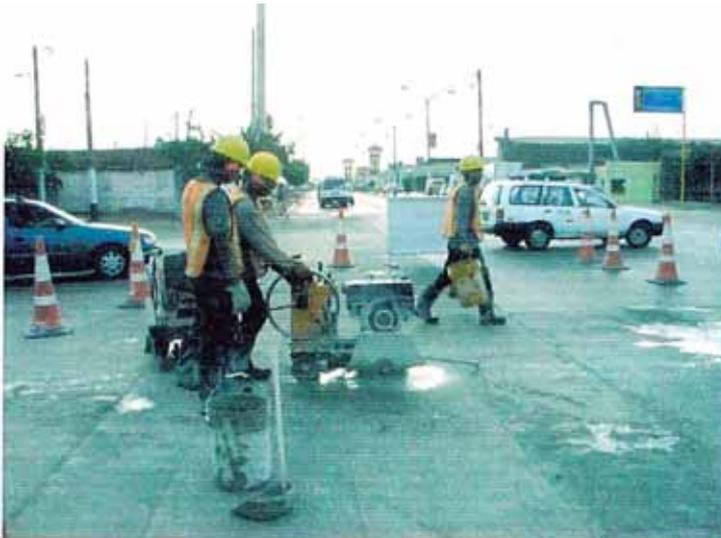
En el caso de pavimentos de concreto se corta a una profundidad de 4", mientras que en pavimentos de asfalto el corte es de 2.5". En situaciones que se presentan dos capas de diferentes materiales (una de concreto y otra de asfalto) se profundiza el corte a 4".
