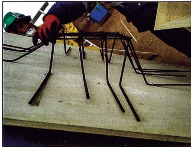
Figura N° 3.11: Armado del acero de refuerzo adicional en cabezales de anclajes.
