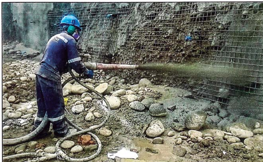
Figura N° 3.08: Lanzado horizontal y perpendicular al talud.
