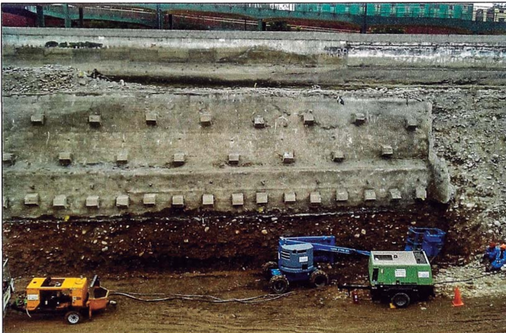
Figura N°3.16: Excavación del siguiente nivel.
