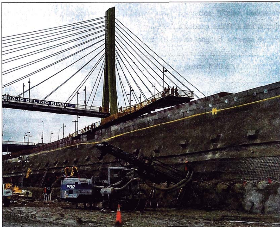
Figura N° 3.04: Perforación para el colocado de anclajes.
