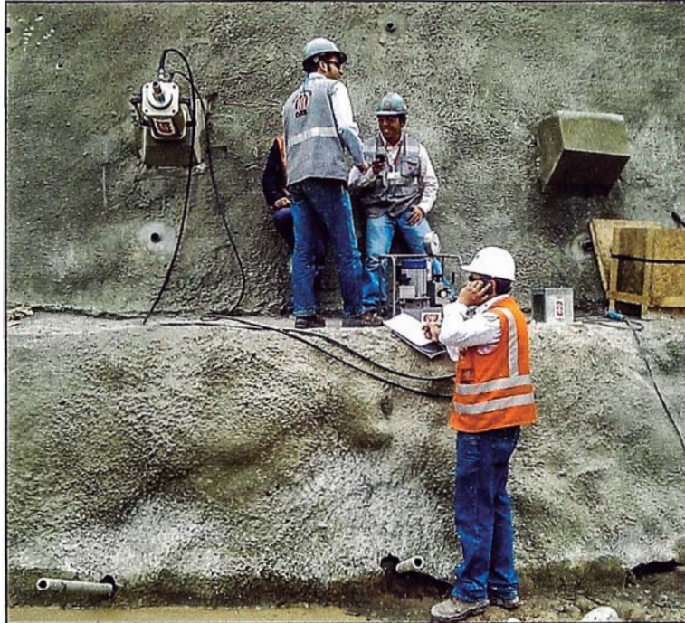
Figura N° 3.14: Tensado de los anclajes activos con gata hidráulica.
