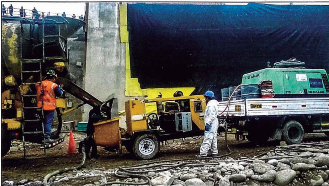
Figura N° 2.04: Equipo de proyección del Concreto Lanzado.
