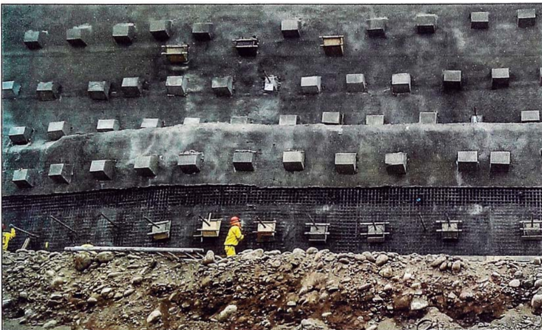
Figura N° 3.13: Colocado de segunda capa de refuerzo.
