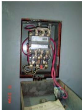
*Fig. 2.3 Contactor de alimentación a la bomba hidráulica*
