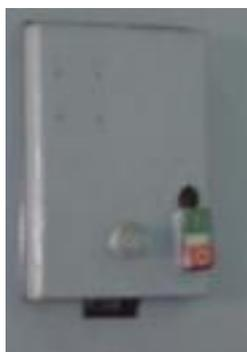
*Fig. 2.2 Interruptor eléctrico manual de la bomba hidráulica*
