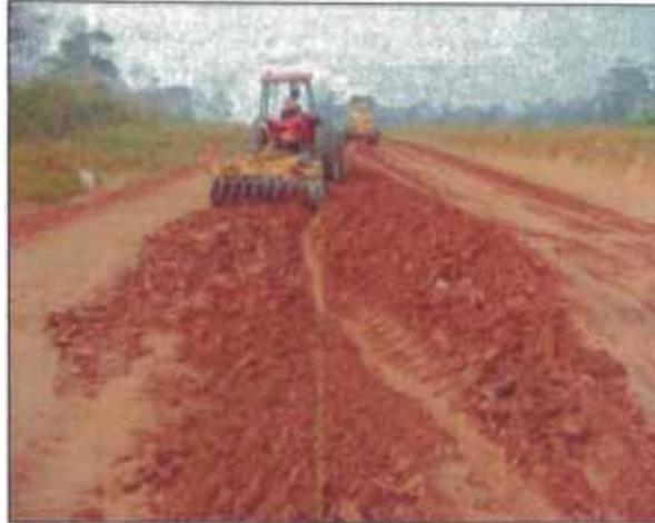
Figura N°4.1.-Escarificación y pulverización de la subrasante
