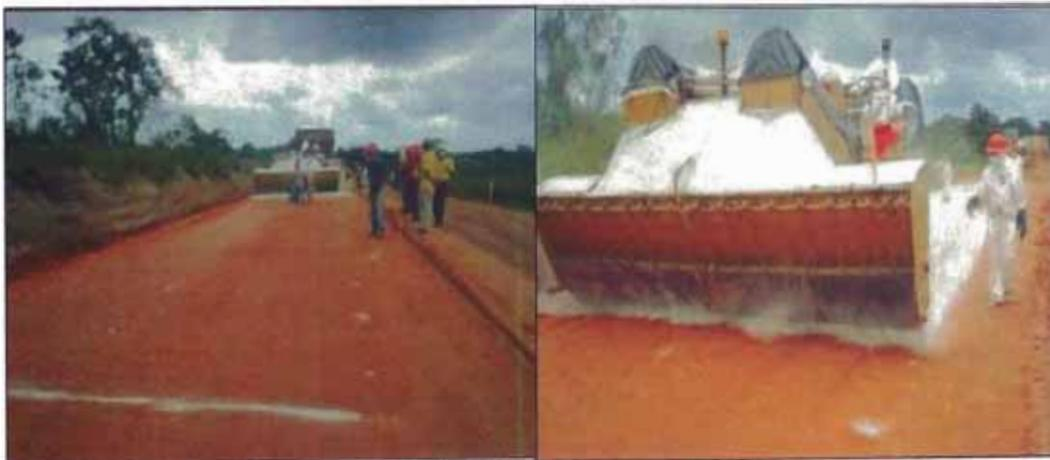
Figura N°4.3.-Extendido de la cal viva sobre la subrasante
