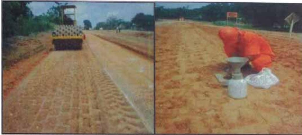
Figura N°4.5.-Compactación de la mezcla suelo-cal
