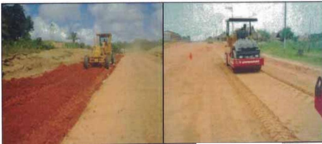
Figura N°4.2.-Conformación y compactación a nivel de subrasante
