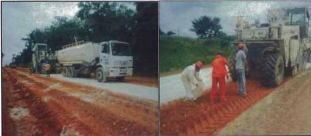
Figura N°4.4.-Proceso de mezclado del material natural y cal
