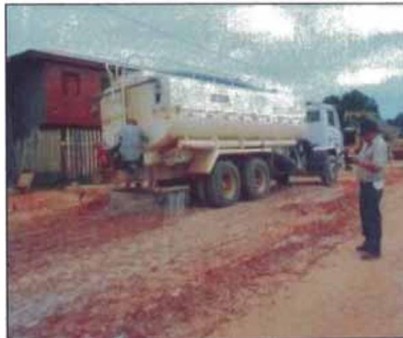
Figura N°4.6.-Curado húmedo de la mezcla suelo-cal
