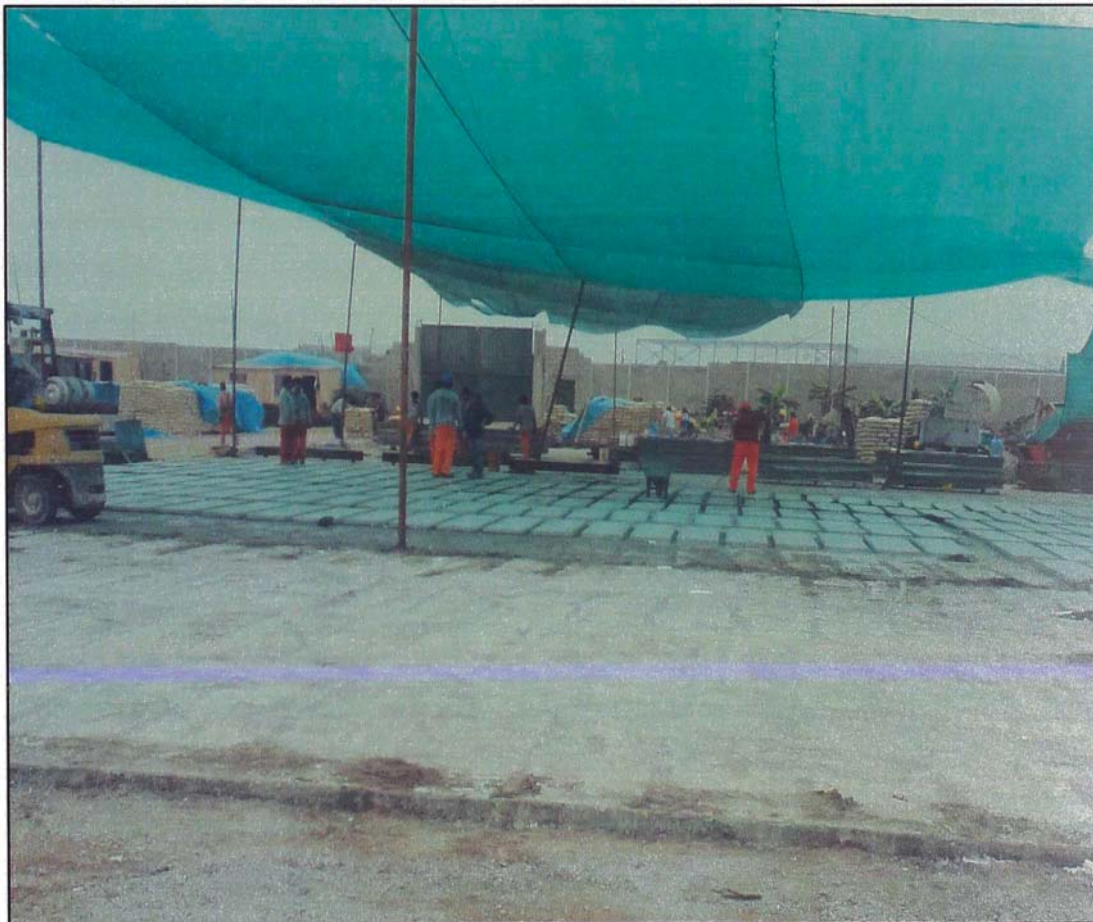
Figura N° 2.45. Preparación de losa para la fabricación
