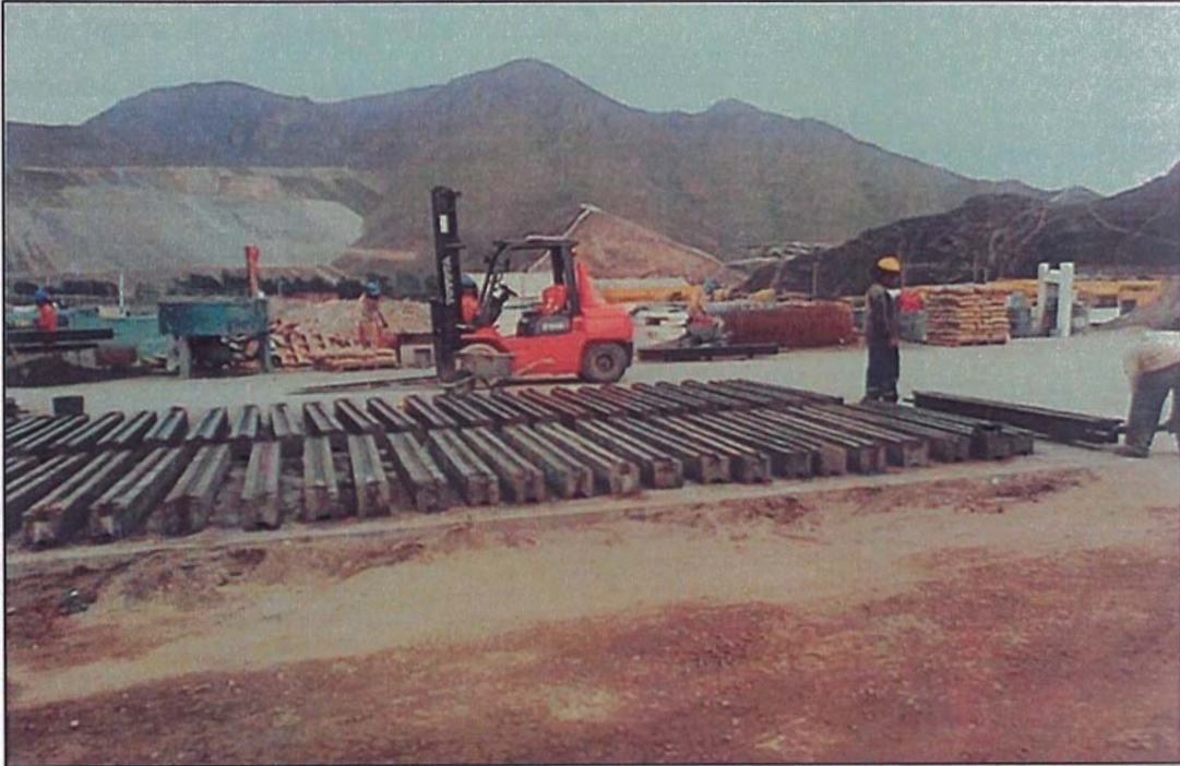
Figura N° 2.22. Fabricación de Columnas – Acopio de columnas
