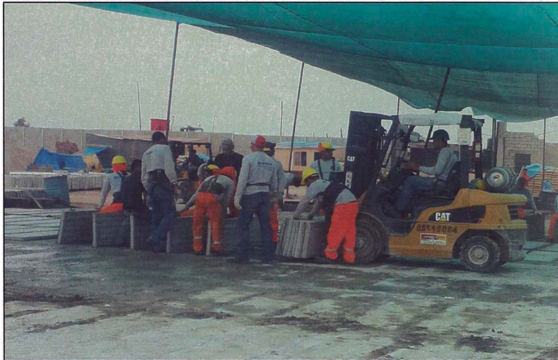
Figura N° 2.55. Fabricación de paneles – Recojo de paneles
