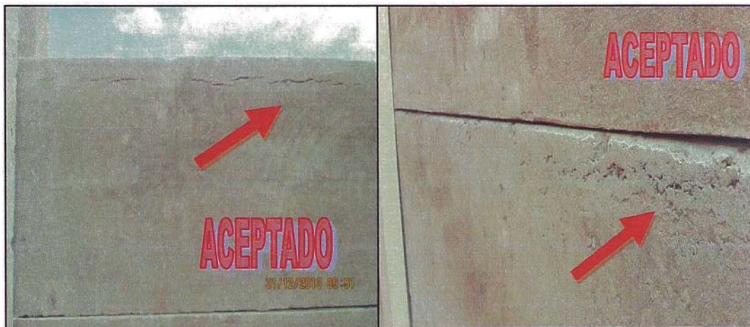
Figura N° 3.9. Línea base de aceptación – Paneles aceptados
