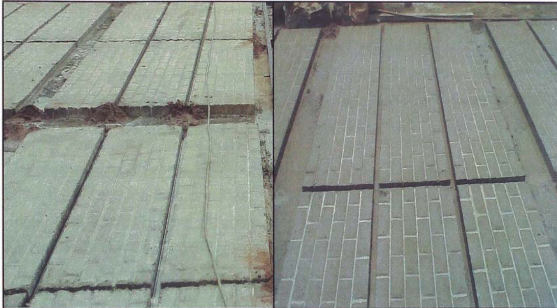
Figura N° 2.13. Fabricación de paneles – Curado de paneles prefabricados
