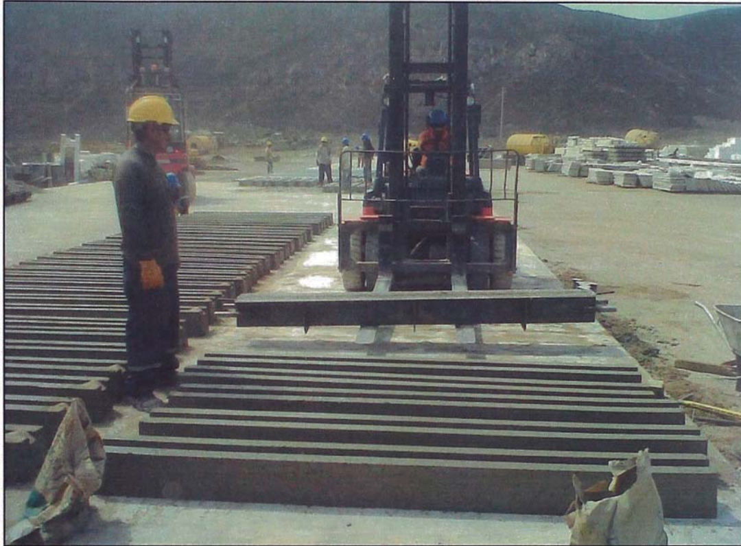
Figura N° 2.18. Fabricación de Columnas – Traslado del encofrado
