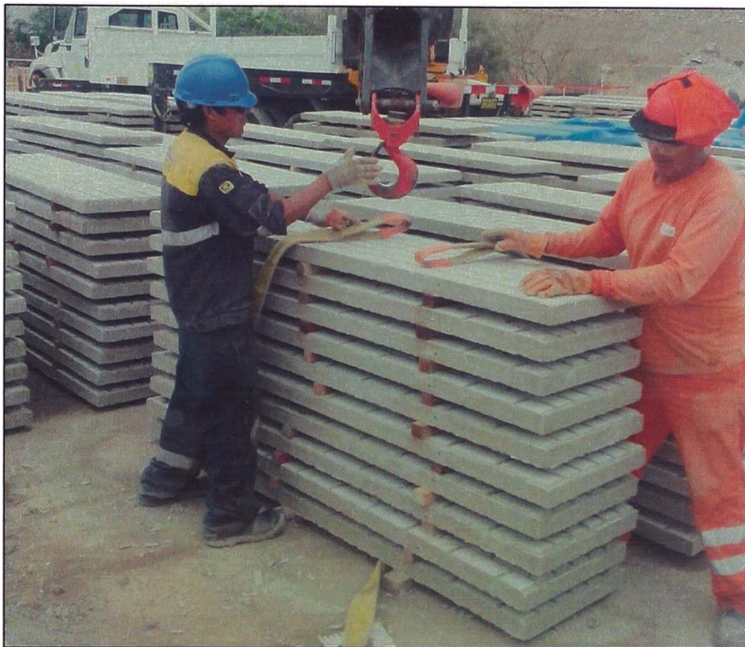
Figura N° 2.35. Fabricación de paneles – descarga de paneles
