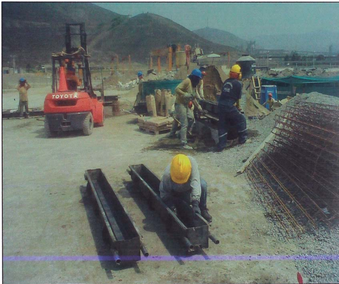
Figura N° 2.15. Fabricación de Columnas – Encofrado metálico
