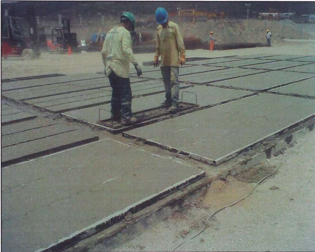
Figura N° 2.11. Fabricación de paneles – Colocación de parrilla
