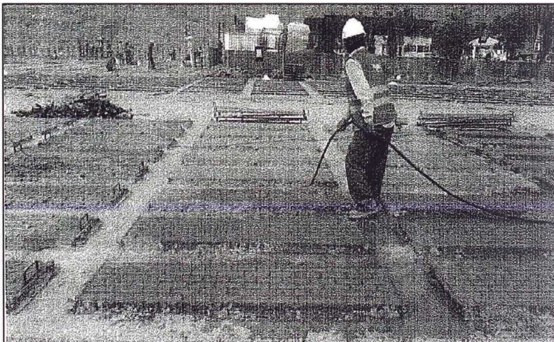
Figura N° 2.29. Fabricación de paneles – Curado de concreto con manguera
