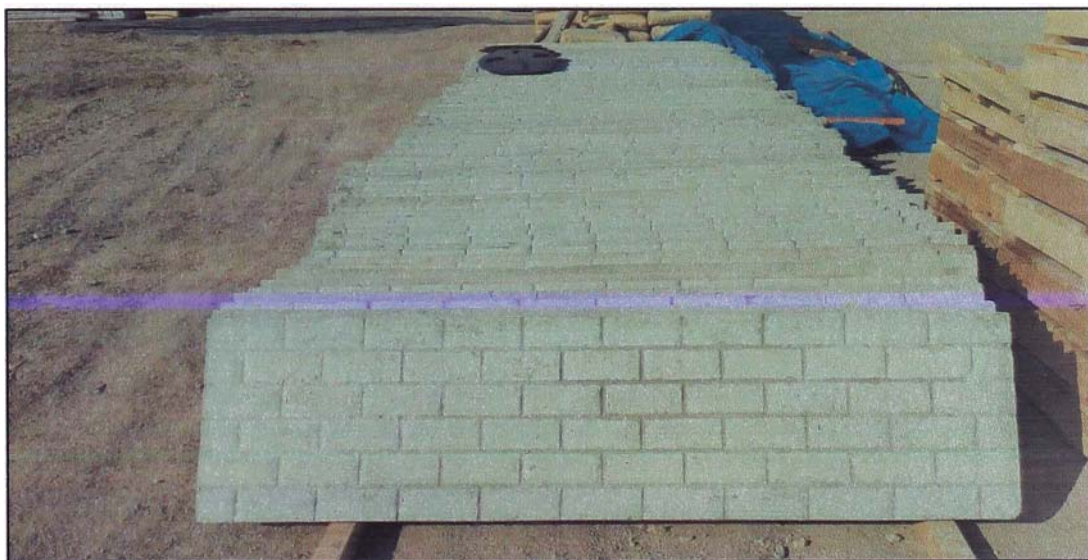
Figura N° 2.58. Paneles listos para transporte a obra
