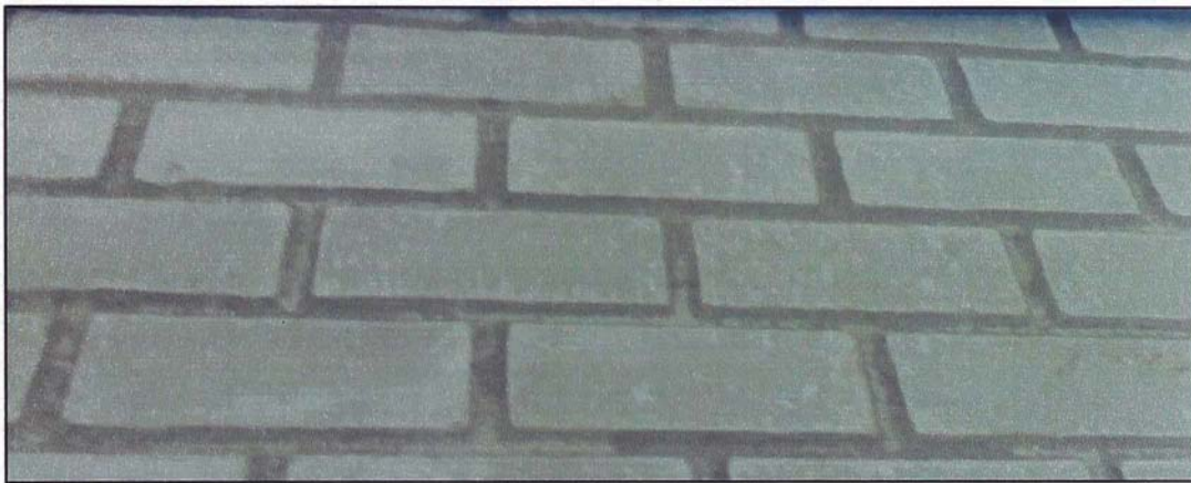
Figura N° 3.6. Paneles prefabricados de concreto – GyM S.A.
