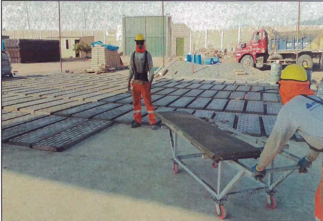
Figura N° 2.50. Fabricación de paneles – Traslado de paneles
