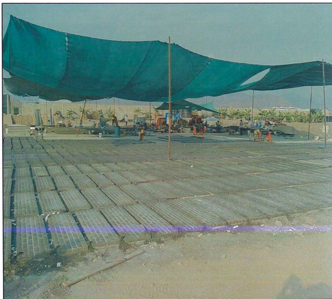
Figura N° 2.44. Planta de Prefabricados- INGENIERIA Y PREFABRICADOS DE CONCRETO S.A.C.
