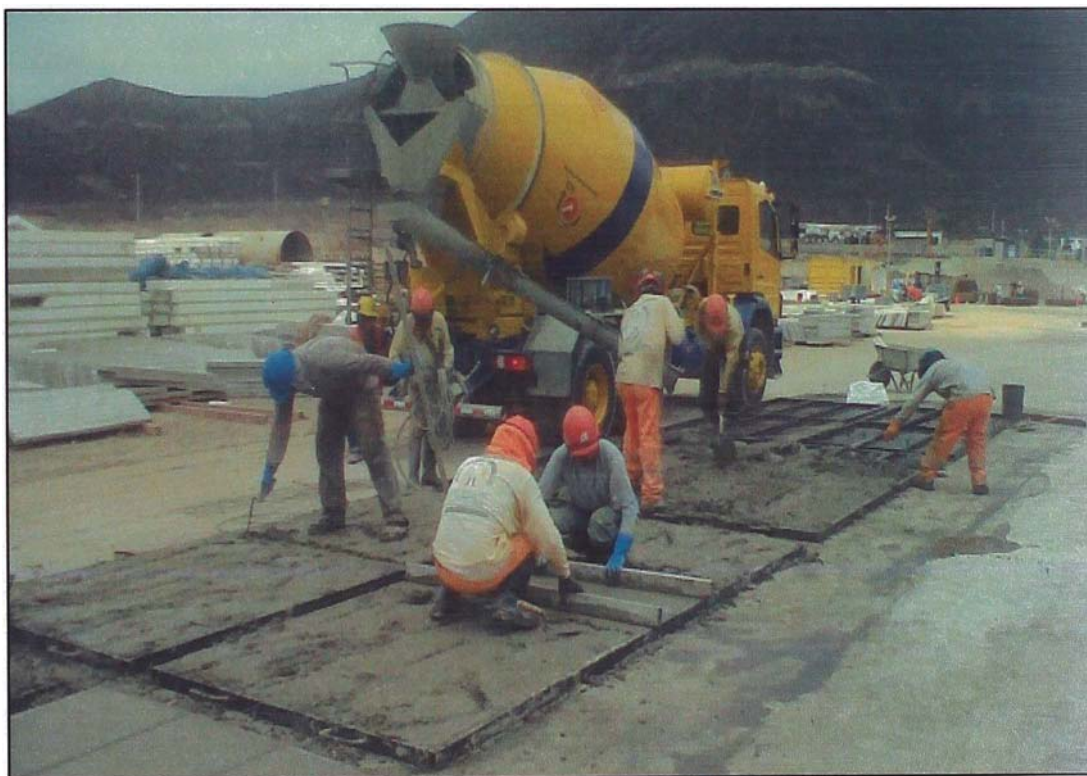
Figura N° 2.8. Fabricación de paneles – Vaciado de concreto
