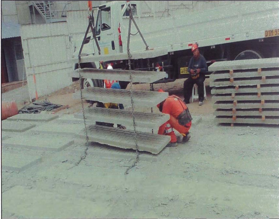
Figura N° 2.31. Fabricación de paneles – amarre de paneles
