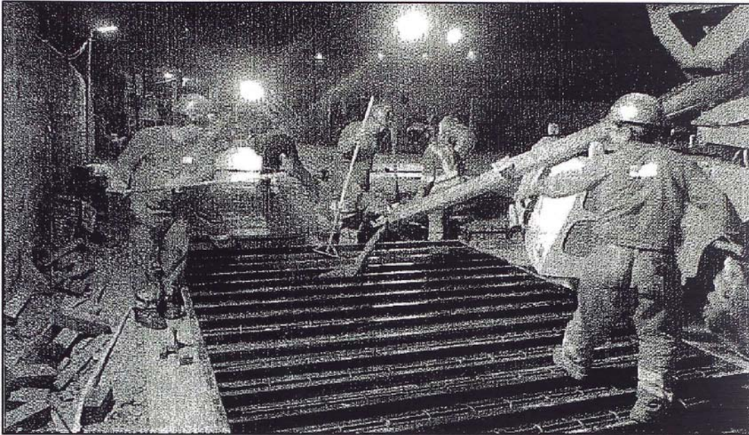
Figura N° 2.42. Fabricación de Columnas – Vaciado de concreto
