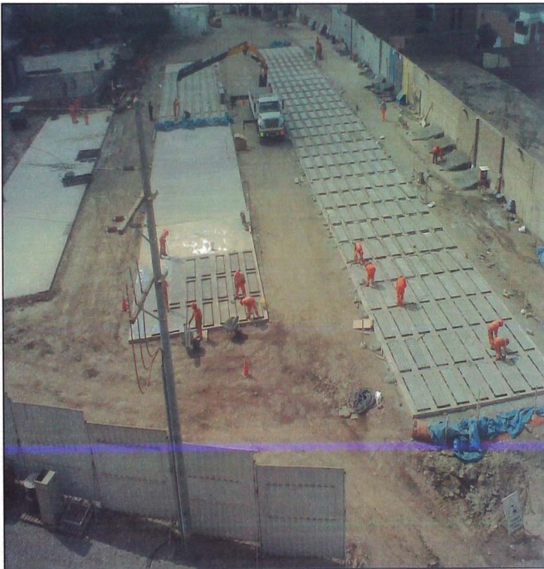
Figura N° 2.24. Planta de prefabricados – GyM S.A.
