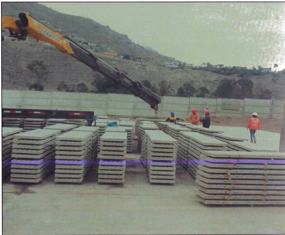
Figura N° 2.37. Paneles listos para su transporte a obra
