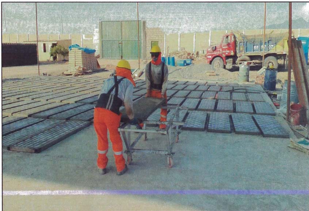
Figura N° 2.51. Fabricación de paneles – Desencofrado de paneles
