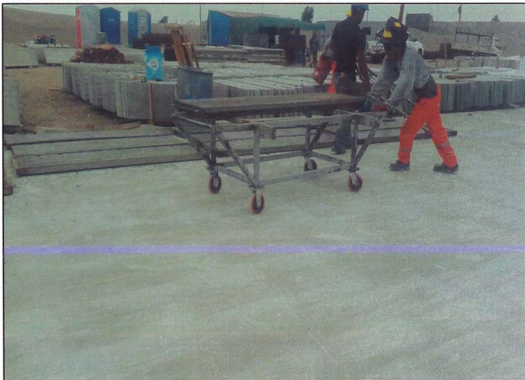
Figura N° 2.49. Fabricación de paneles – Traslado de paneles
