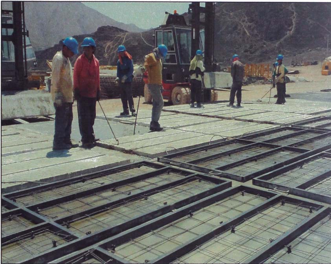
Figura N° 2.12. Traslado de paneles hacia un lugar de acopio
