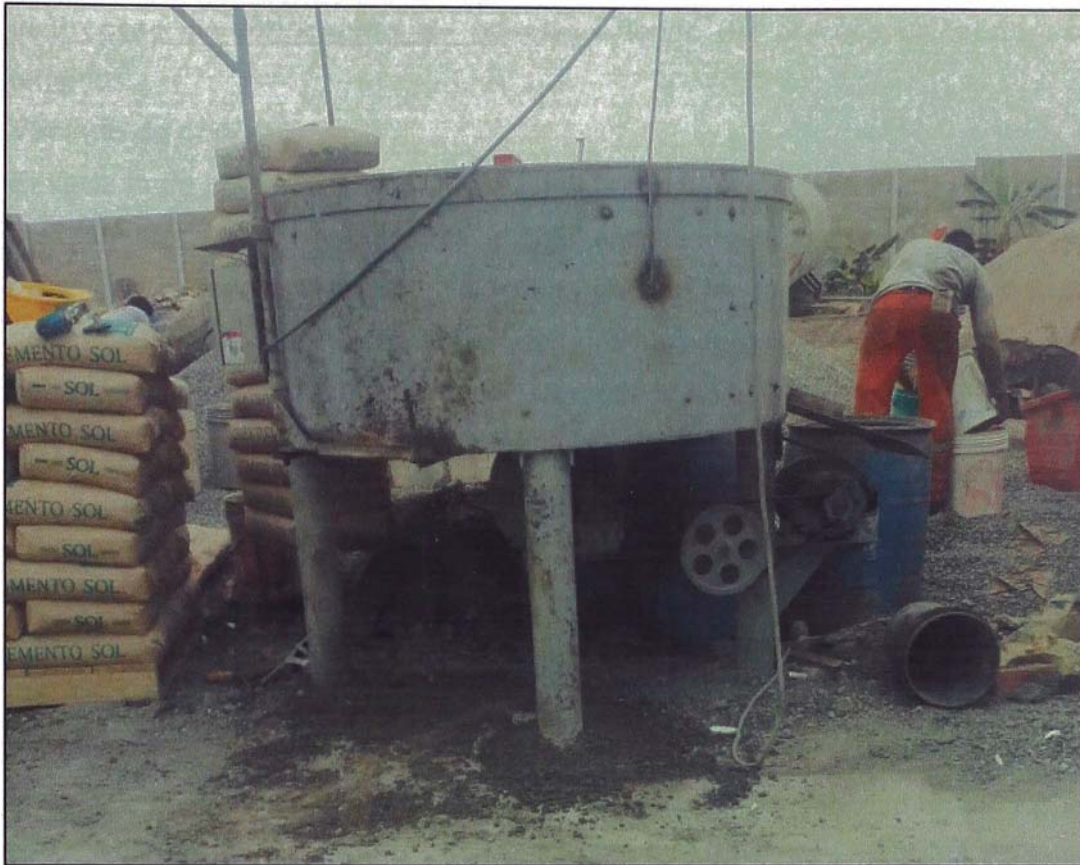
Figura N° 2.47. Preparación del Concreto – Mezcladora de eje vertical
