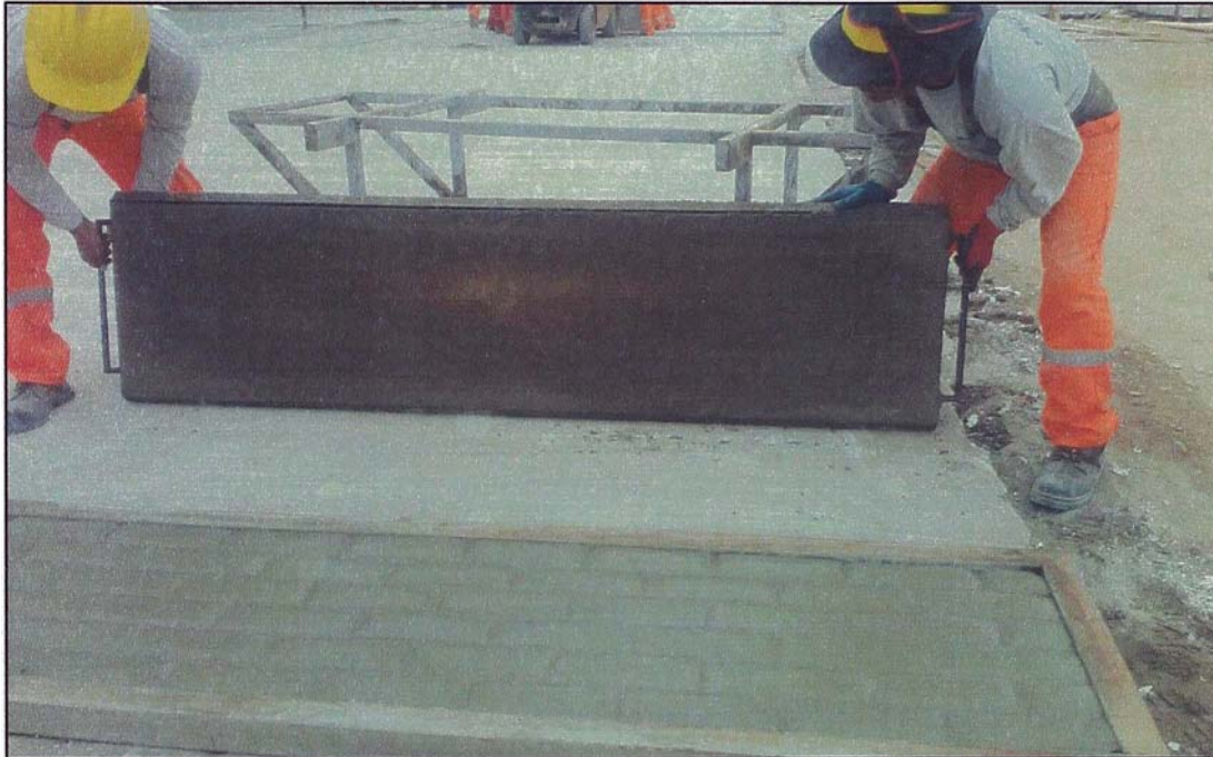
Figura N° 2.52. Fabricación de paneles – Moldes metálicos
