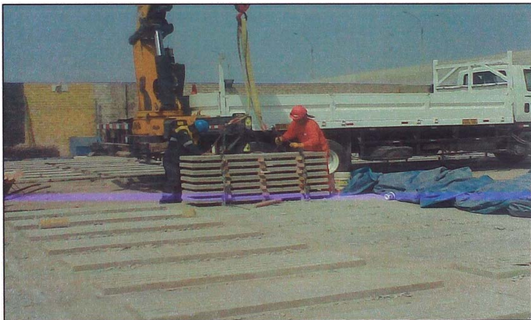
Figura N° 2.34. Fabricación de paneles – Izaje de paneles
