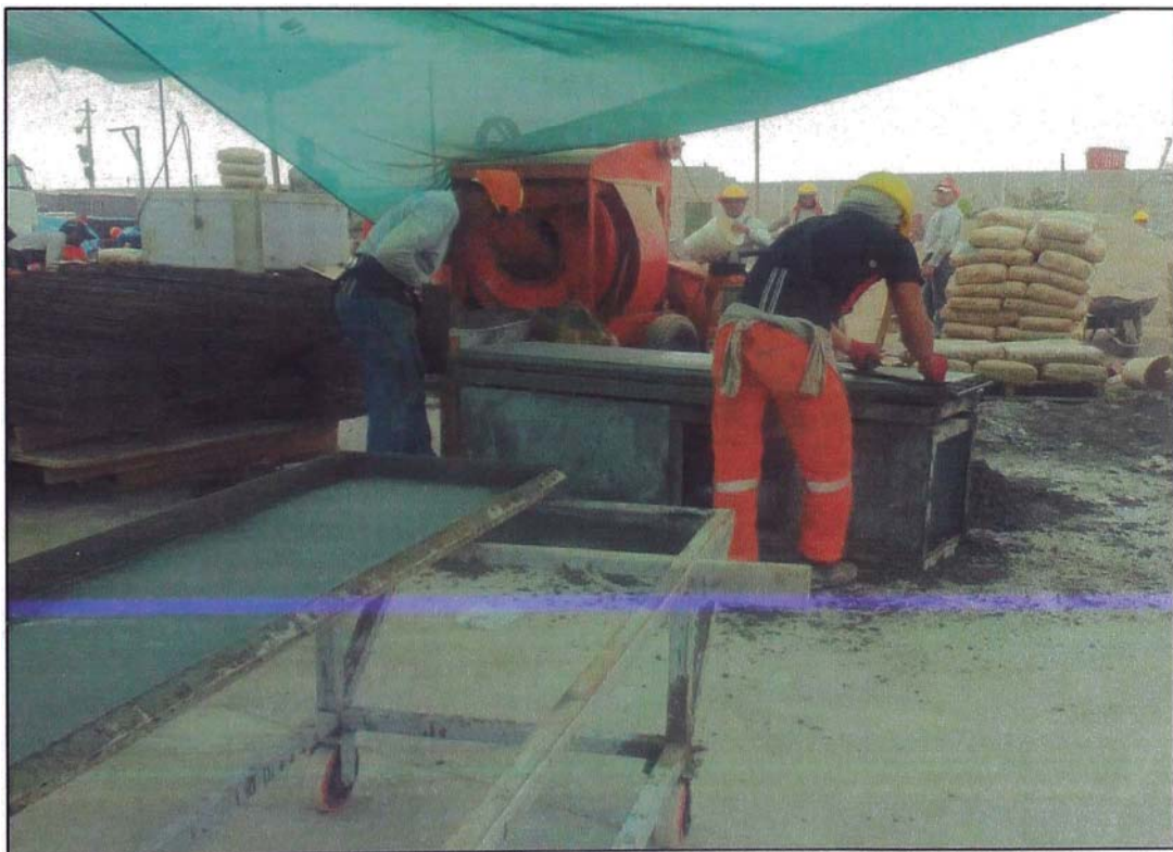
Figura N° 2.48. Preparación del Concreto – Mezcladora tipo tolva
