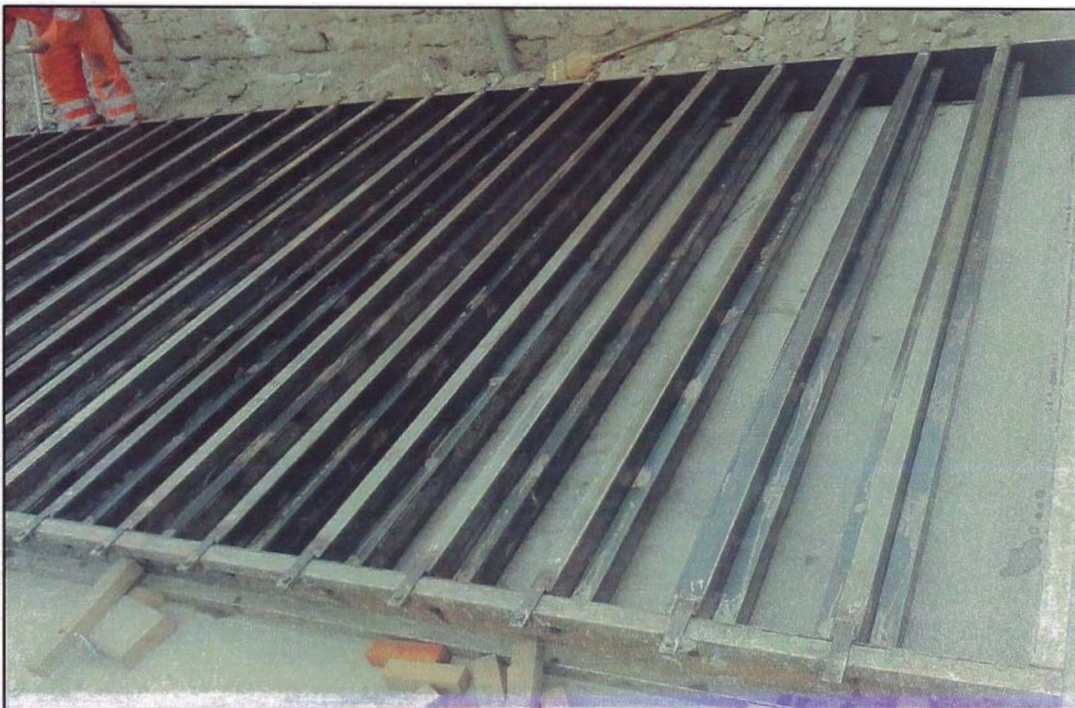
Figura N° 2.40. Encofrado para columnas prefabricadas de concreto
