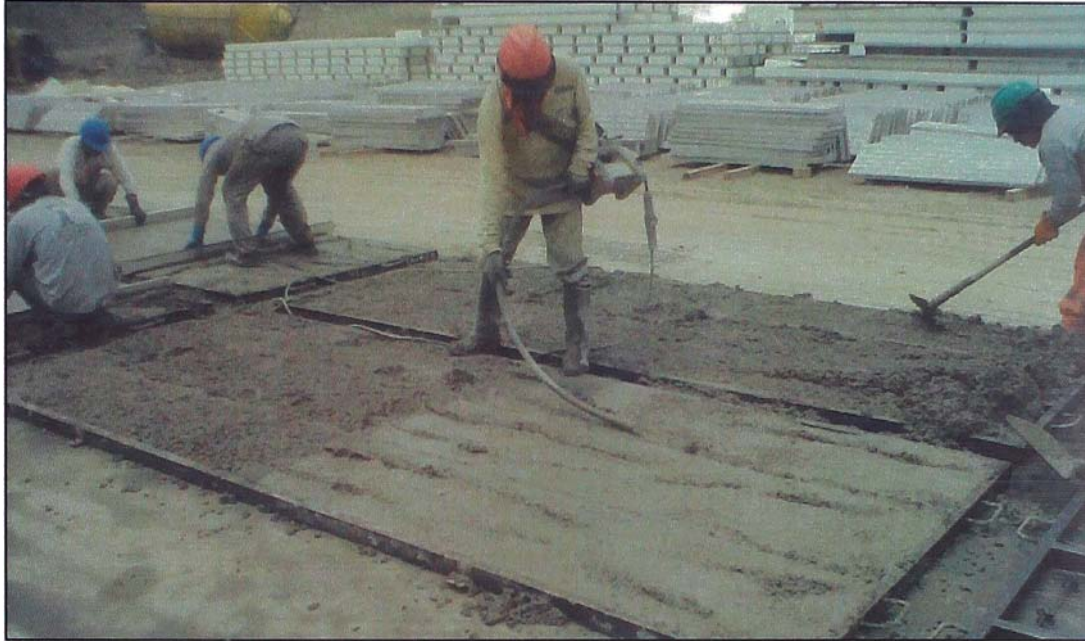
Figura N° 2.9. Fabricación de paneles – Vibrado de concreto
