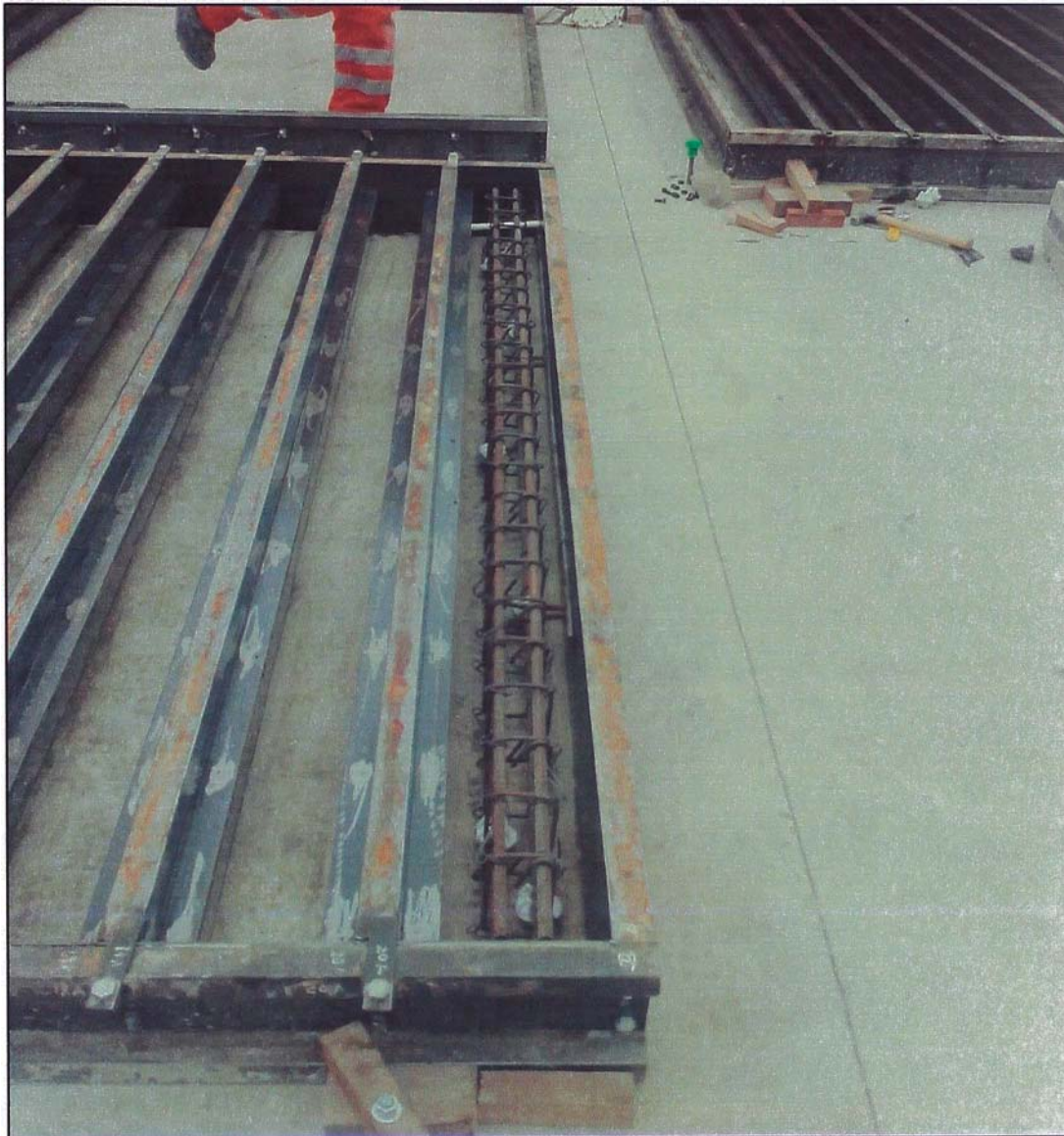
Figura N° 2.41. Fabricación de Columnas – Armadura y separadores
