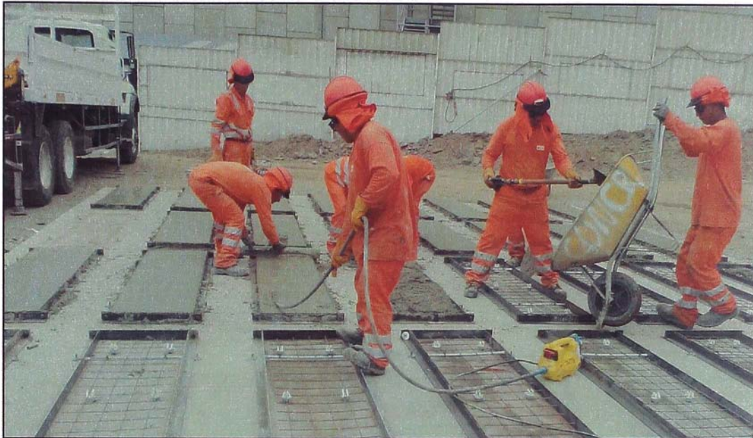
Figura N° 2.28. Fabricación de Paneles – Vaciado de concreto
