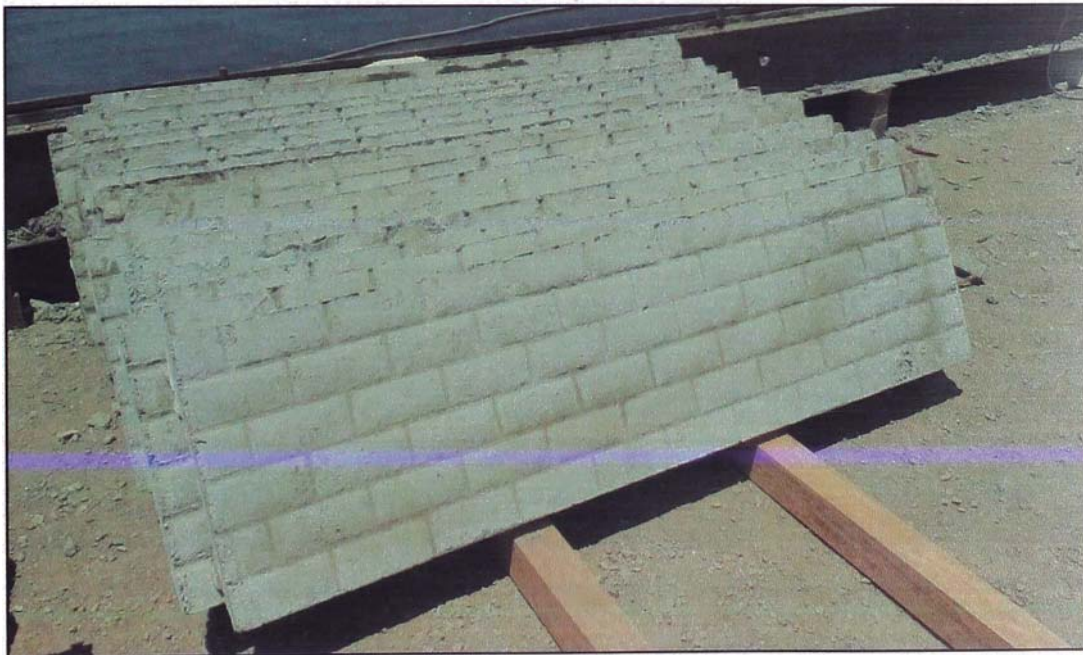
Figura N° 2.14. Paneles apilados para su transporte a obra
