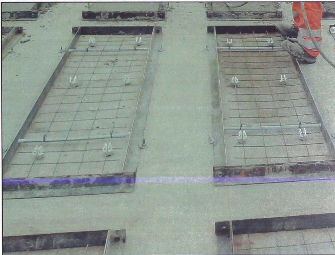
Figura N° 2.25. Fabricación de paneles – Armadura y separadores.
