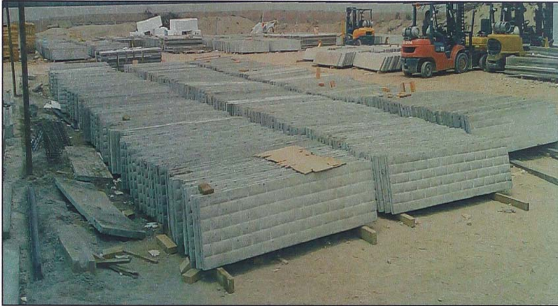
Figura N° 2.57. Fabricación de paneles – Lugar de acopio de paneles
