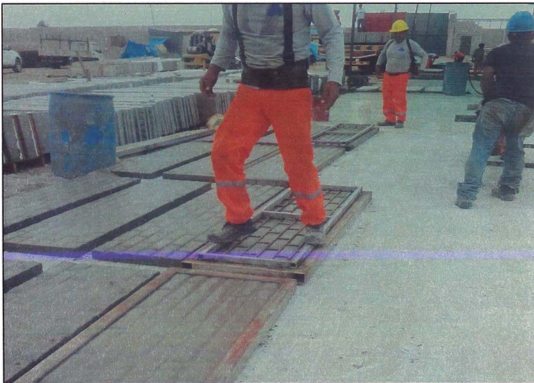
Figura N° 2.53. Fabricación de paneles – Moldes metálicos
