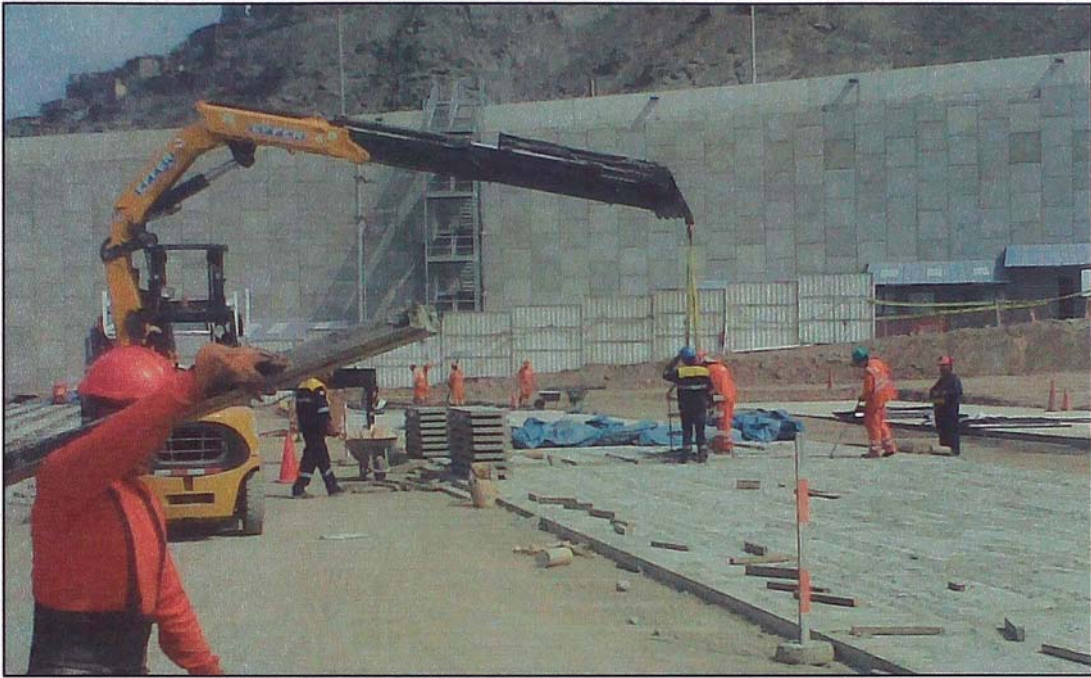
Figura N° 2.33. Fabricación de paneles – Izaje de paneles
