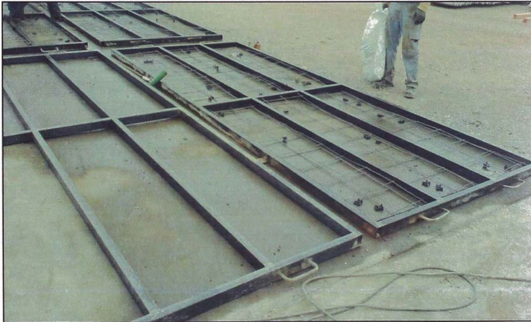
Figura N° 2.7. Fabricación de paneles – Encofrado y armadura
