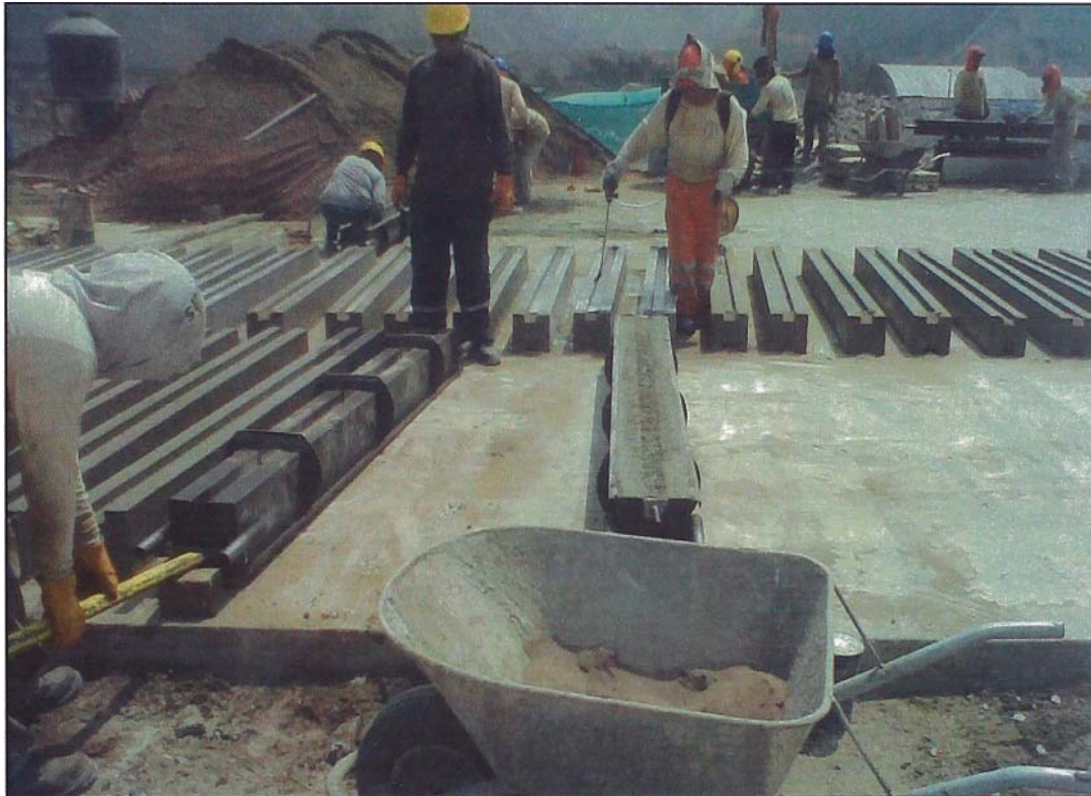
Figura N° 2.20. Fabricación de Columnas – Volteo del encofrado en la losa
