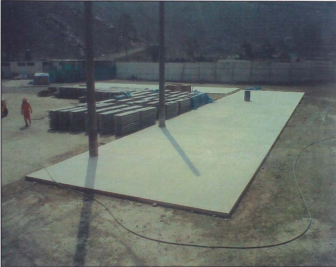
Figura N° 2.38. Losas para la fabricación de Columnas típicas C1 y C2
