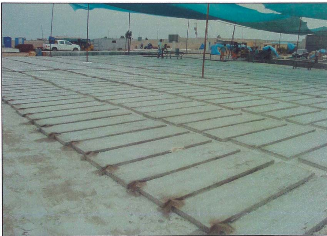
Figura N° 2.54. Fabricación de paneles – Curado de concreto con manguera
