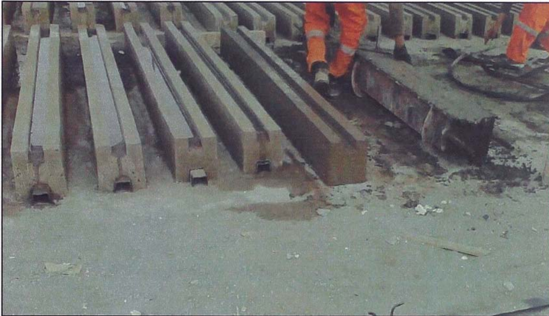
Figura N° 2.60. Fabricación de Columnas – desencofrado de columnas
