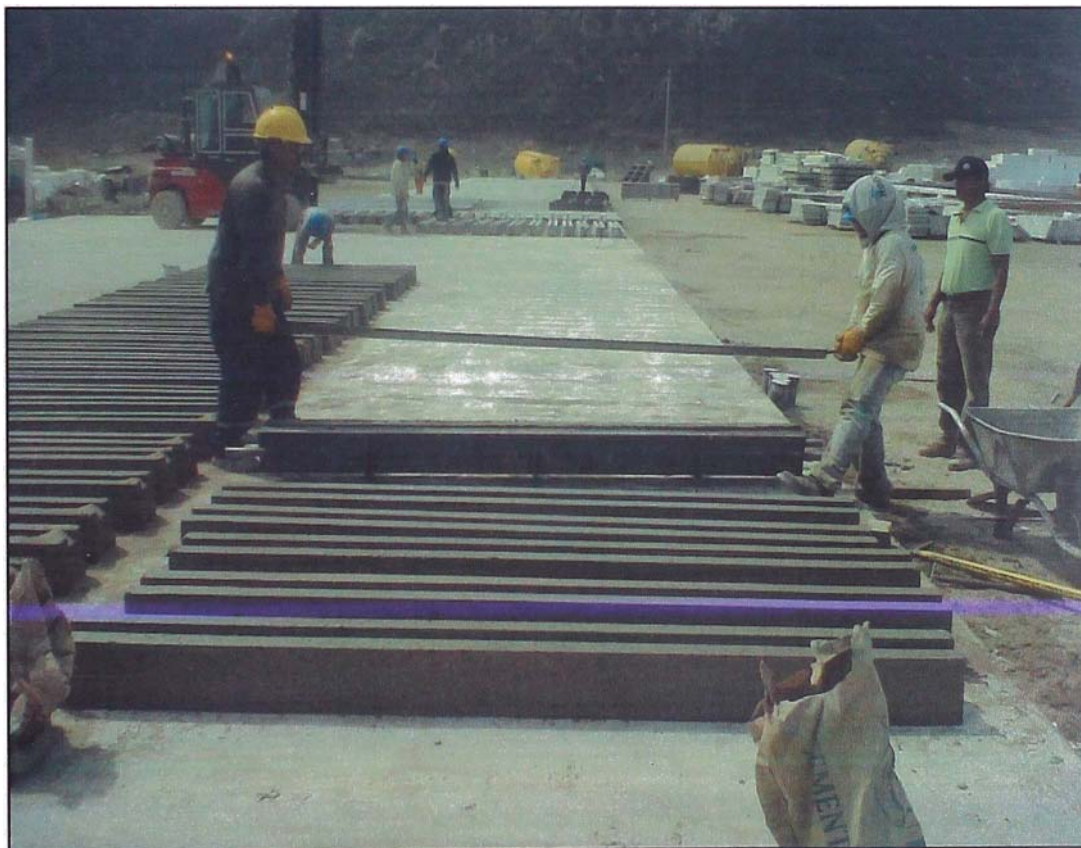
Figura N° 2.19. Fabricación de Columnas – Proceso de desenformado
