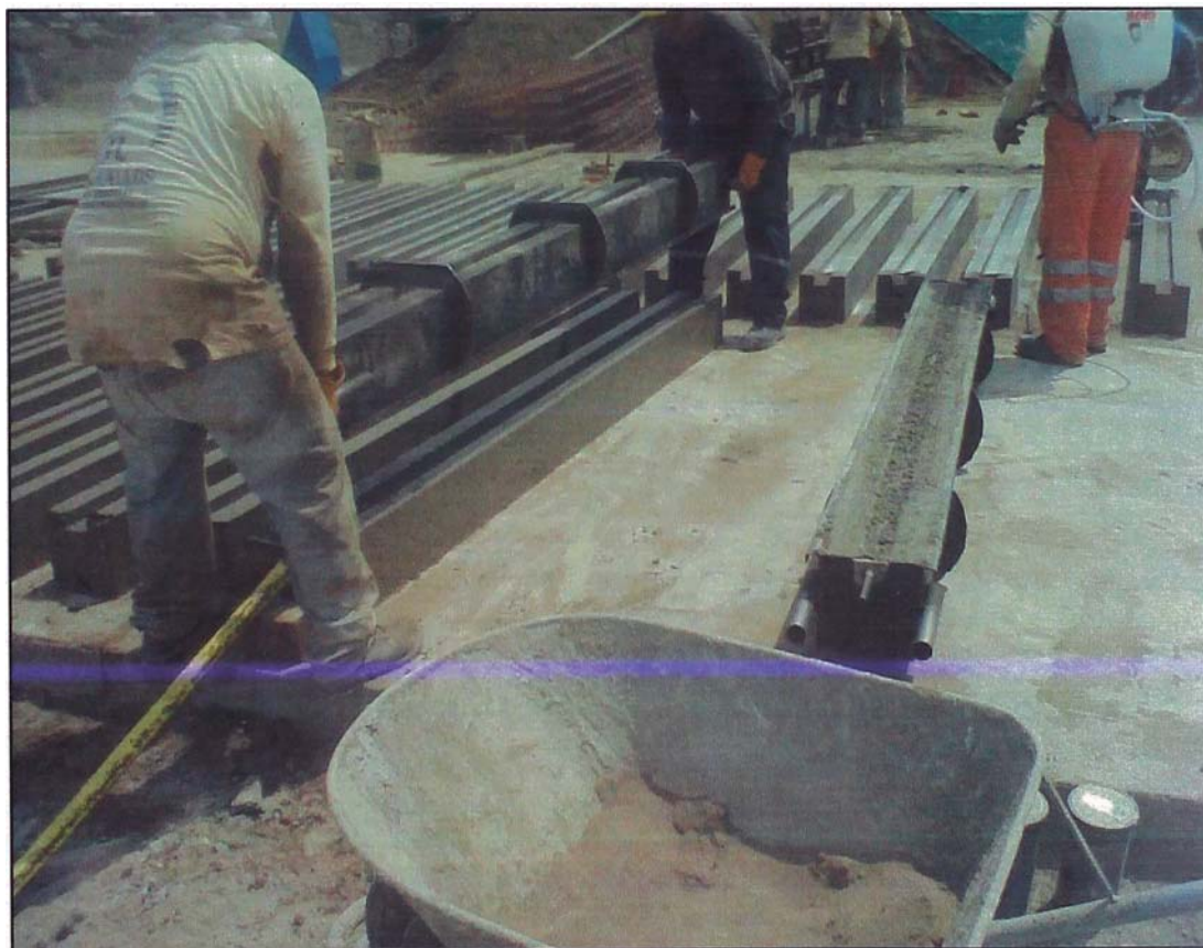
Figura N° 2.21. Fabricación de Columnas – Retiro del molde metálico
