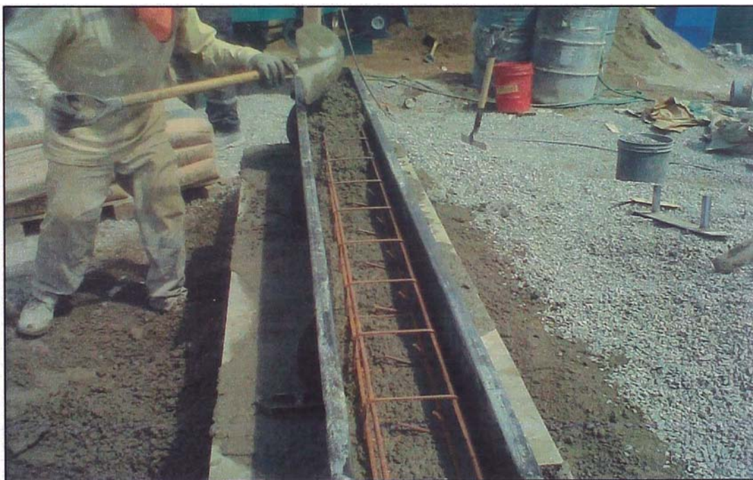
Figura N° 2.17. Fabricación de Columnas – Vaciado de concreto
