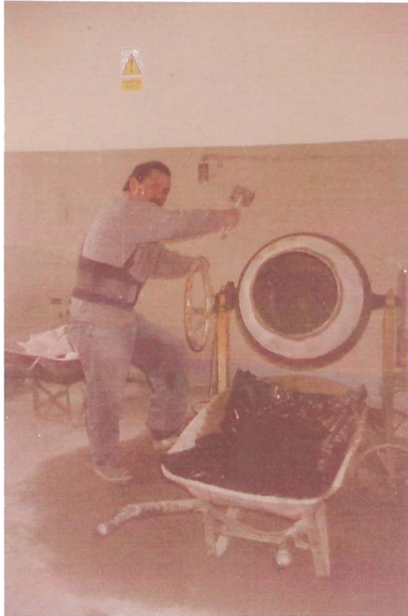
FOTO 7: PROCESO DE MEZCLADO DEL CONCRETO
