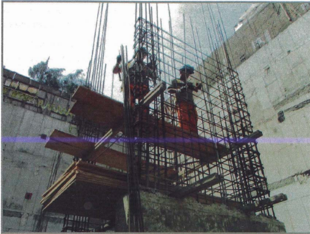
Figura N° 05: Habilitación de malla de acero en elementos verticales
