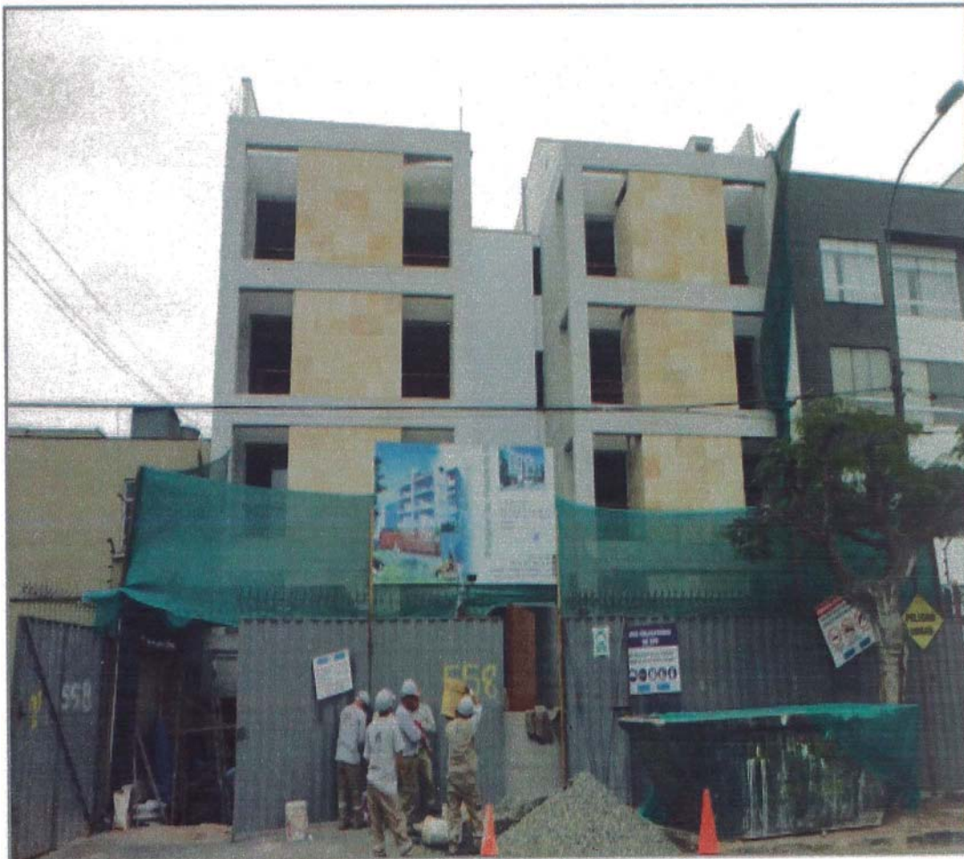
Figura N° 19: Edificio Parque la Pradera II
