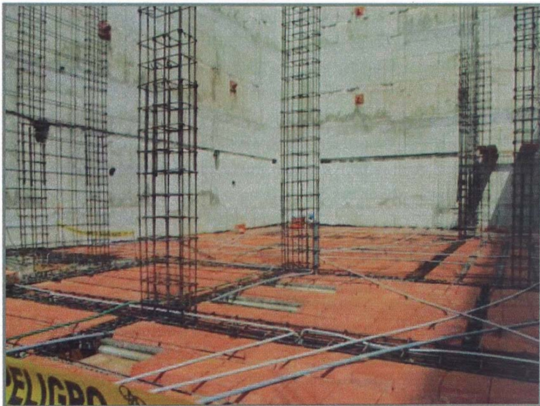
Figura N° 06: Albañilería e instalaciones en losa aligerada del sótano 5
