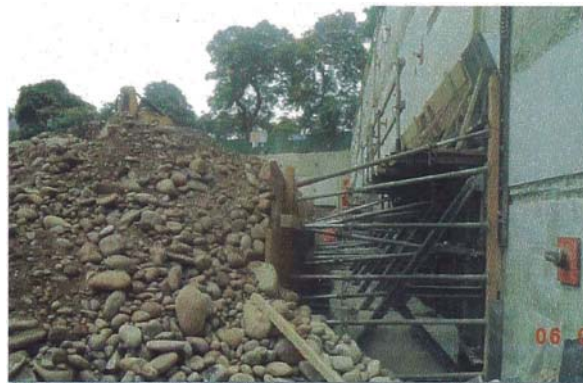
Figura 40 Colocación de tierra (Empuje pasivo)
