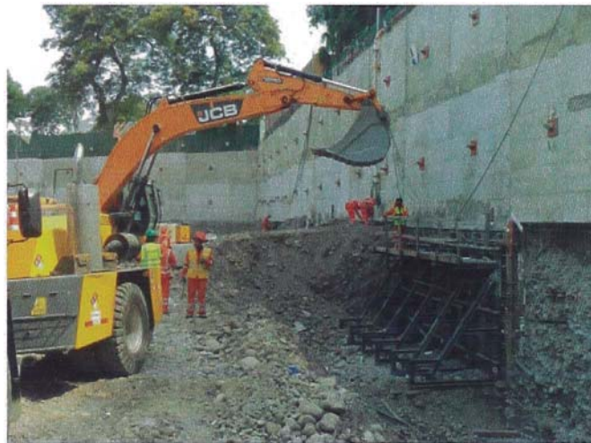
Figura 38 Transporte del Encofrado
