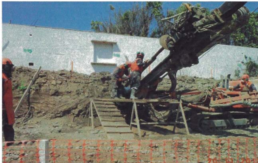
Figura 30 Perforación para el anclaje
