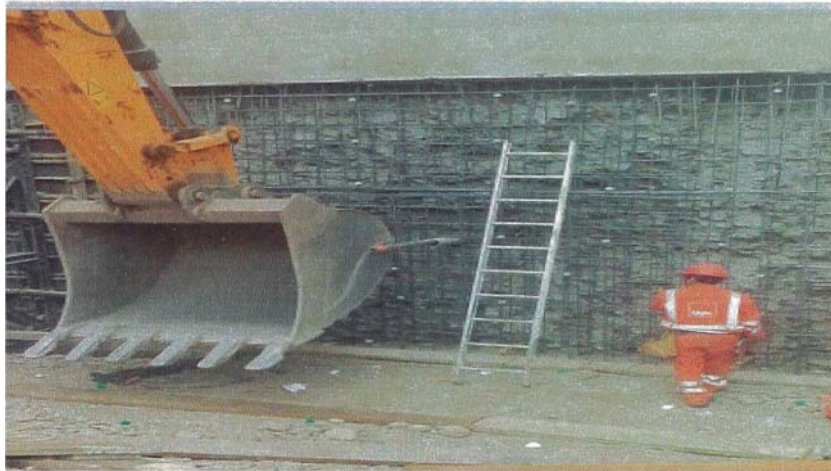
Figura 37 Colocación de tablonos
