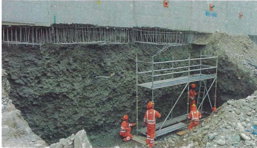
Figura 33 Pañeteo del muro
