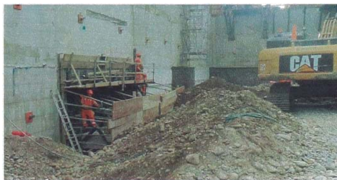
Figura 36 Encofrado Muro pantalla
