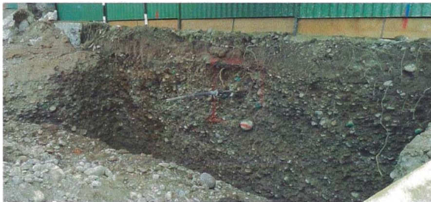
Figura 32 Perfilado o Desquinchado
