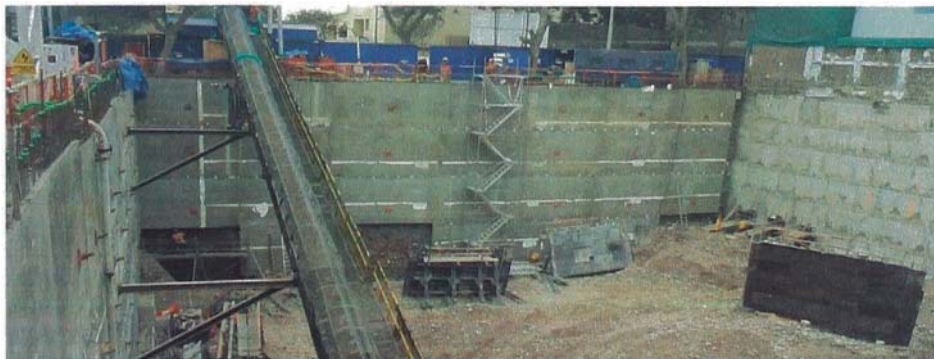
Figura 13 Excavación con faja transportadora
