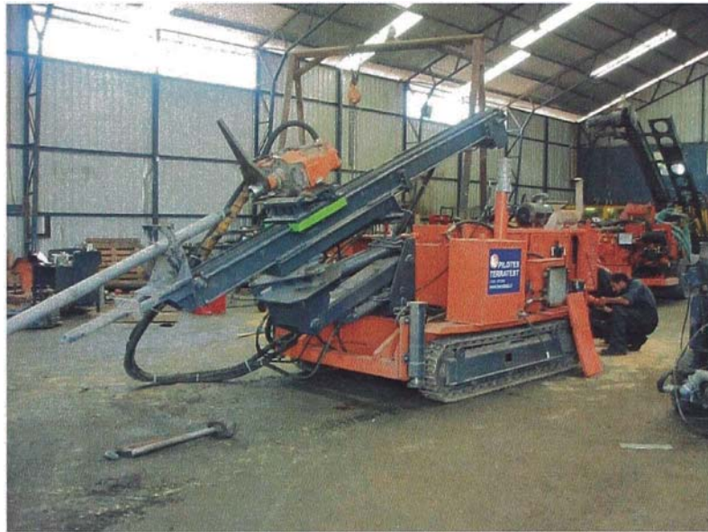
Figura 7 Equipo de Perforación Para Muro Pantalla
