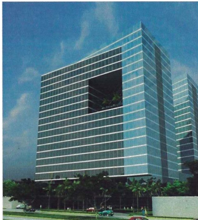
Figura 1: Foto referencial del Edificio
