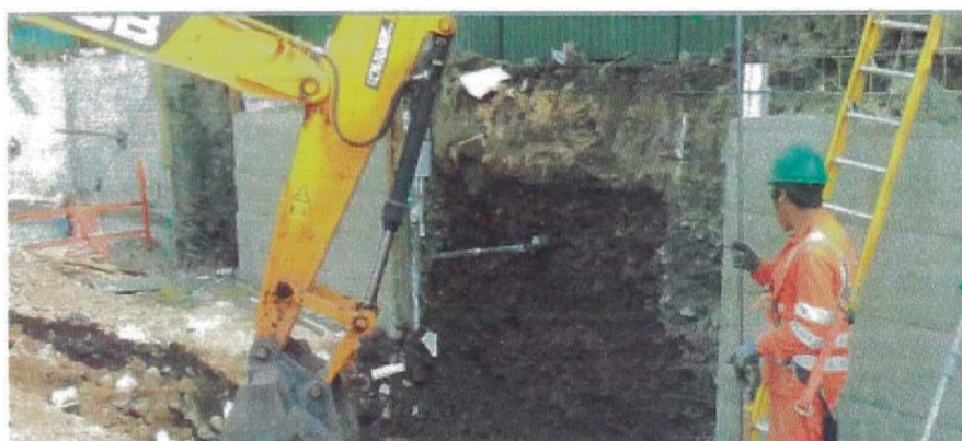
Figura 31 Retiro de Banqueta
