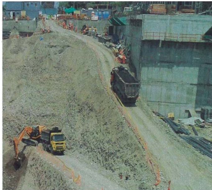
Figura 11 Excavación con rampa
