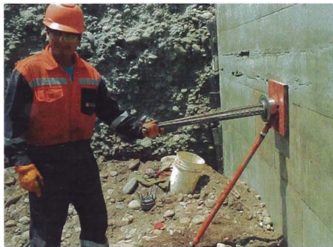
Figura 5 Anclaje con Cable Tensor
