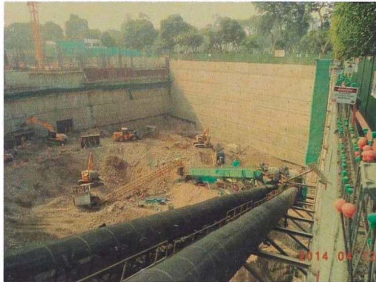
Figura 24 Uso de 2 Fajas transportadoras (Proyecto Panorama)
