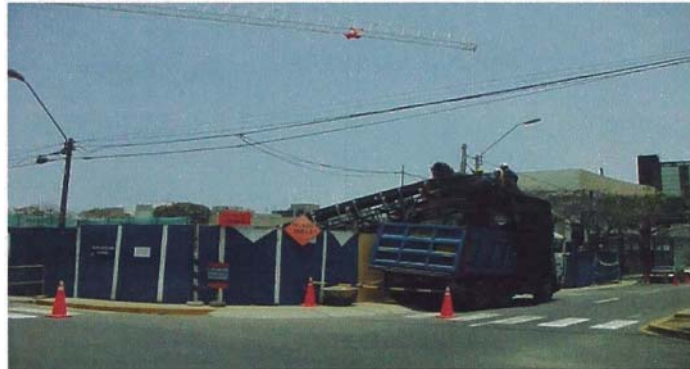
Figura 18 Eliminación de Material
