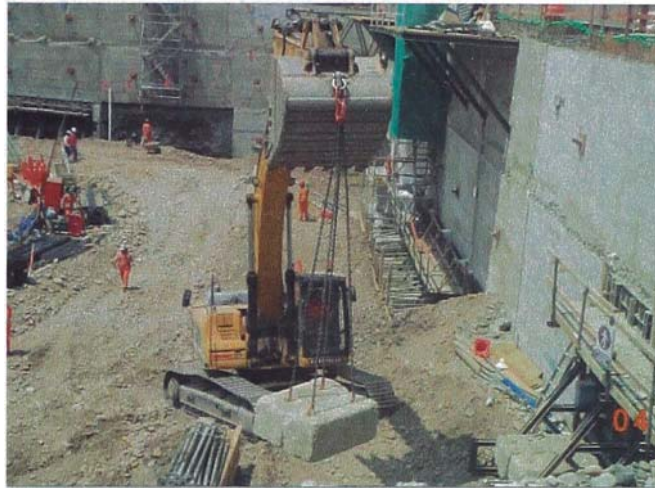
Figura 39 Colocación de Bloques
