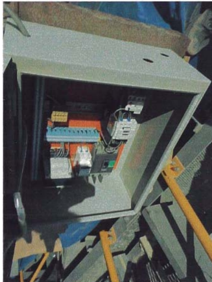
Figura 20 Interruptor termo magnético
