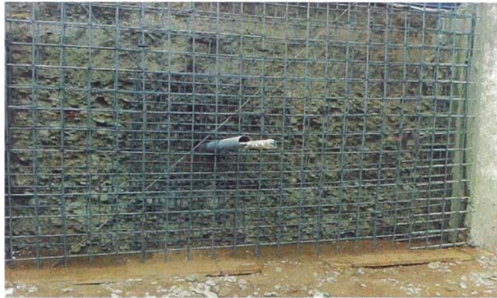
Figura 35 Colocación de acero en muro anclado
