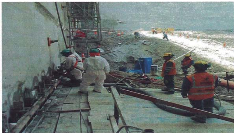
Figura 43 Vaciado de concreto
