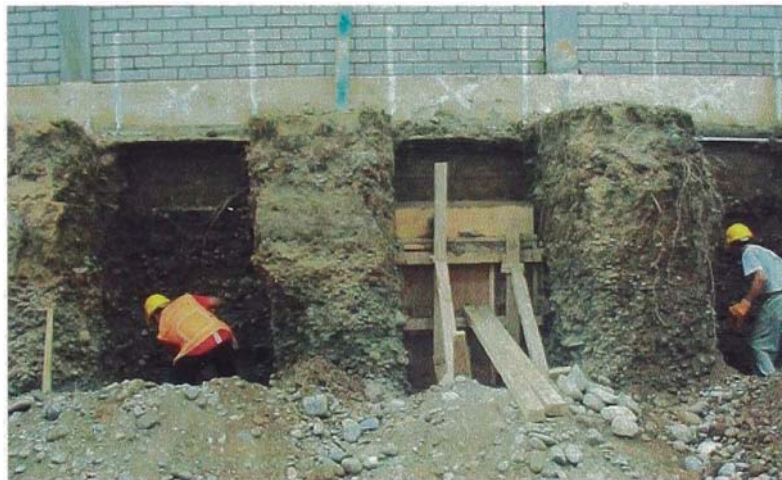
Figura 3 imagen de una calzadura
