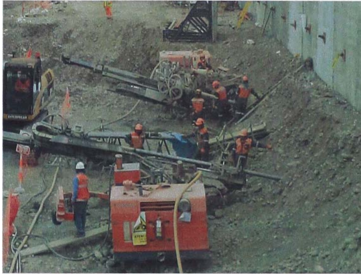
Figura 9 Banqueta para Perforación e inyección
