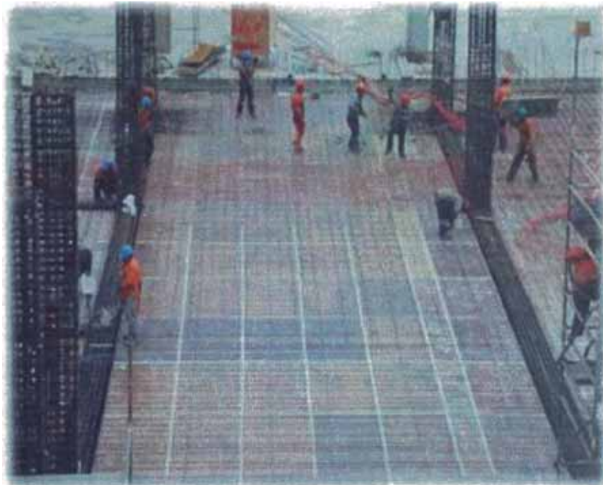
Figura 21: Colocación de trazo de tendones- Fuente: Fotografía propia
