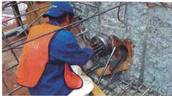
Figura 25: Tensado de tendones- Fuente: Fotografía propia
