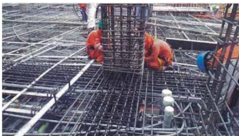
Figura 23: Colocación de acero de refuerzo- Fuente: Fotografía propia
