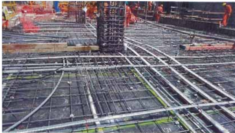
Figura 22: Colocación de tendones- Fuente: Fotografía propia
