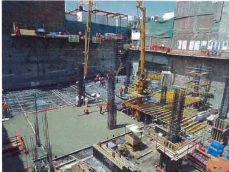
Figura 24: Vaciado de concreto- Fuente: Fotografía propia
