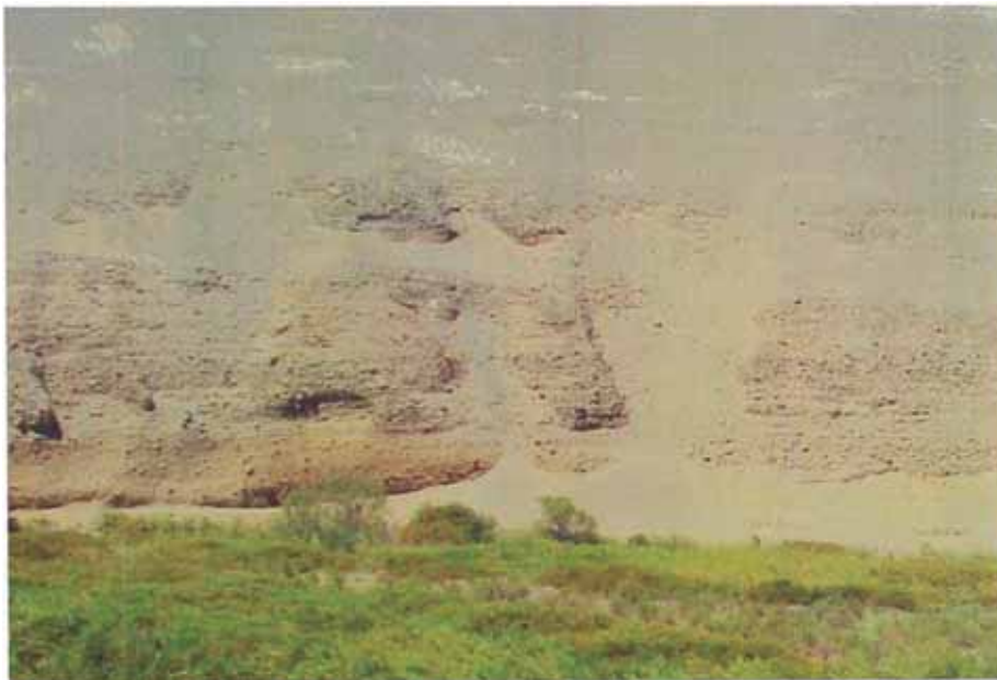
Figura N° 4.4: Estribo izquierdo del eje de la Presa Ite proyectada
