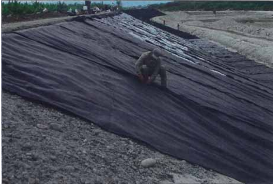
Figura N°4.3 Colocación de geotextil sobre el talud. Fuente, Cortesía de Andex del Norte.
