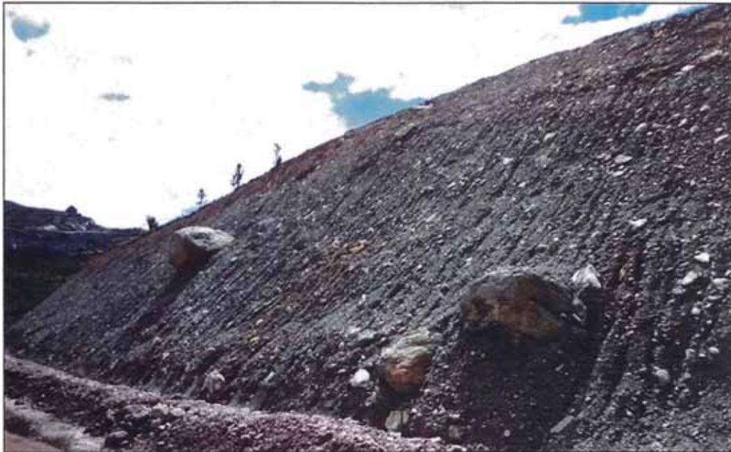
Figura N°3.10 Taludes antes de revegetar. Minera Barrick-La Libertad. Fuente, Cortesía de Andex del Norte.
