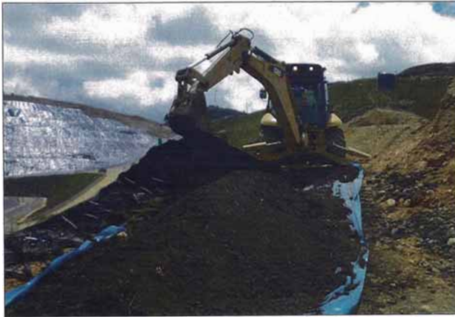
Figura N°4.10 Colocación de Relleno (Top soil + semillas). Fuente, Cortesía de Andex del Norte.
