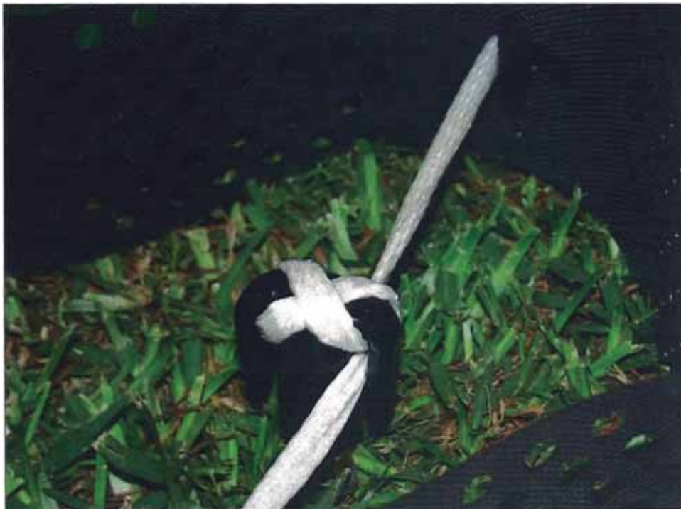
Figura N°3.9 Geoweb con refuerzo de tendón+clip Atra+estaca. Fuente, Cortesía de Andex del Norte.
