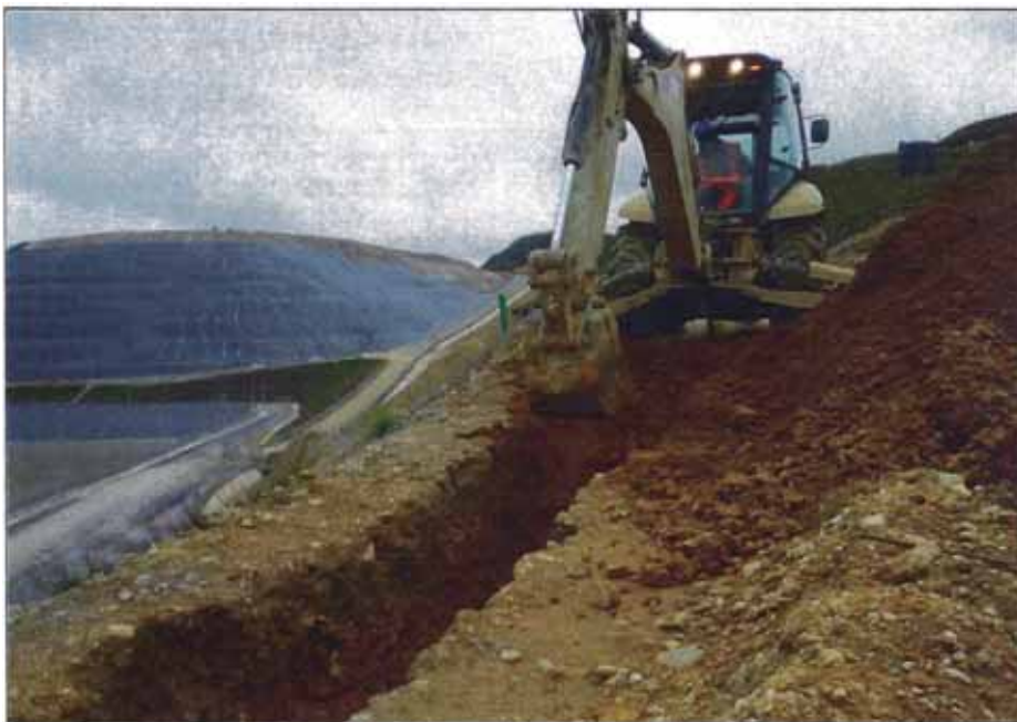
Figura N°4.2 Excavación de zanja de fijación. Fuente, Cortesía de Andex del Norte.
