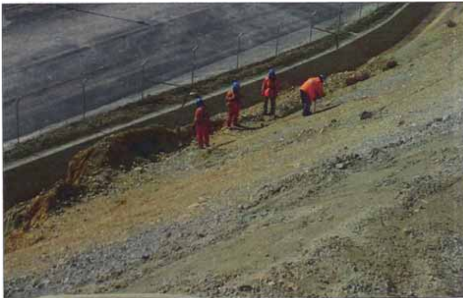
Figura N°4.1 Perfilado del talud existente. Fuente, Cortesía de Andex del Norte.
