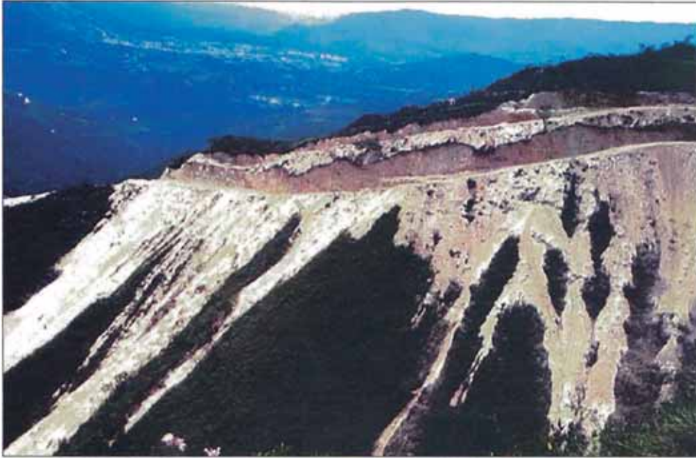
Figura N°1.3 Erosión acelerada por intervención antrópica en taludes. Fuente, Suárez Díaz, Jaime (2001).
