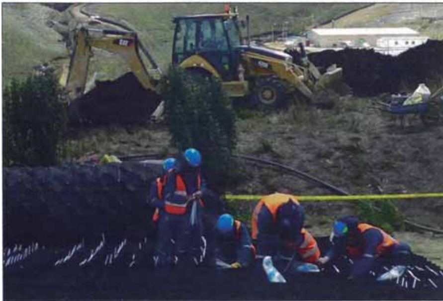
Figura N°4.7 Colocación de cintillos de fijación. Fuente, Cortesía de Andex del Norte.
