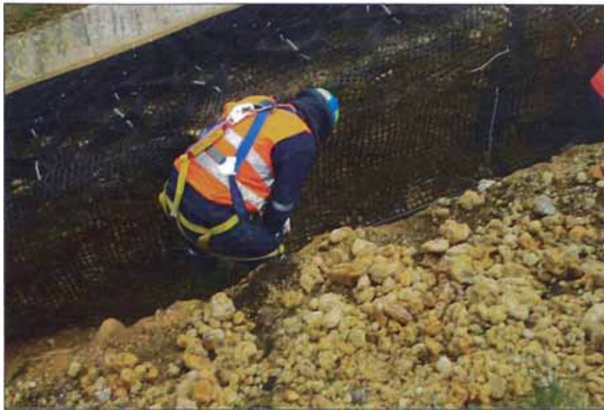
Figura N°4.4 Anclaje de la geomalla. Fuente, Cortesía de Andex del Norte.
